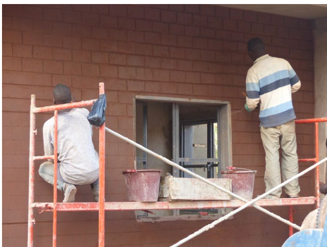
Enduit de terre avec de la pierre de taille.
