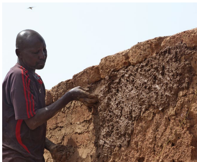
Remise en état périodique d'un enduit de terre.
