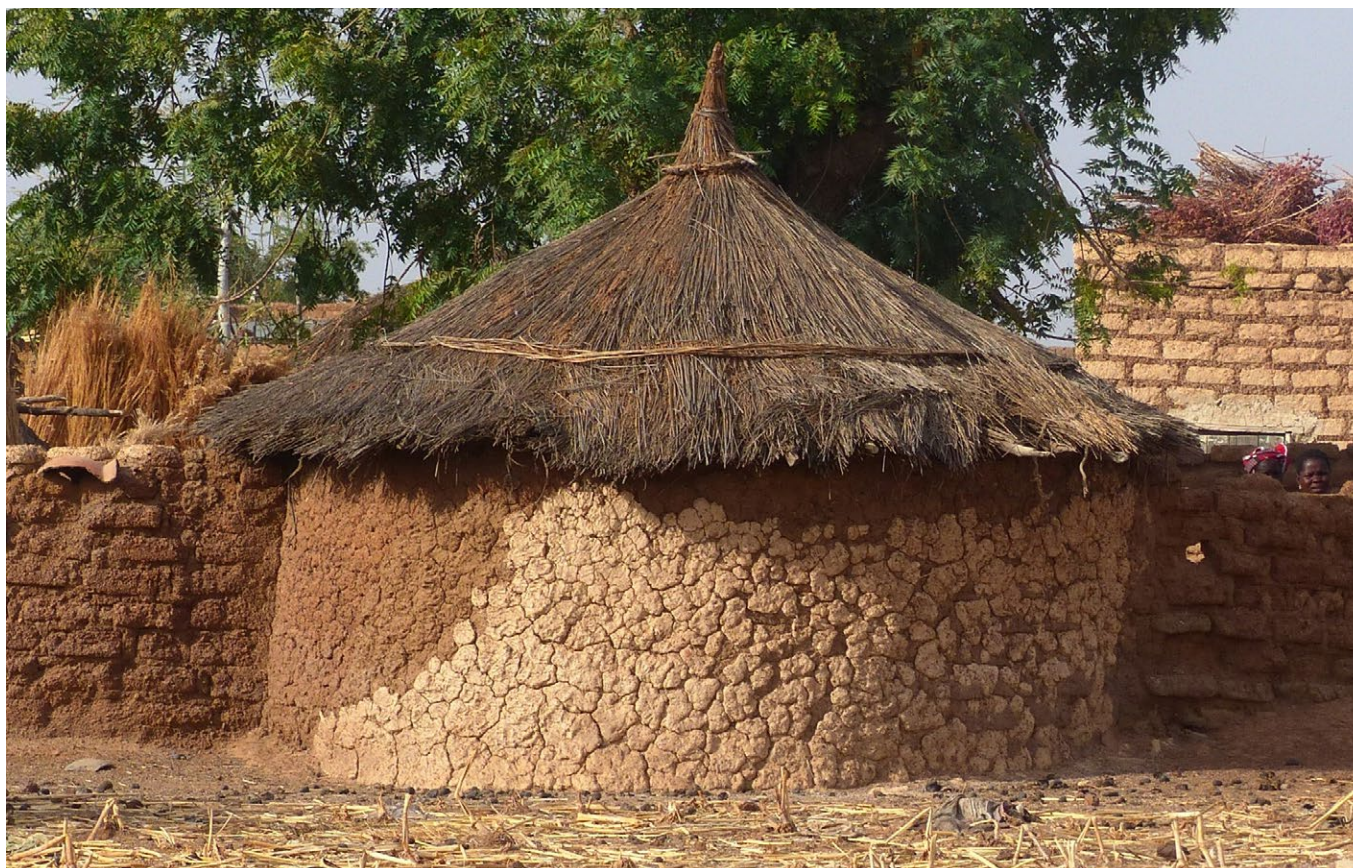
Enduit de deux types de terre sur une case circulaire gan.
