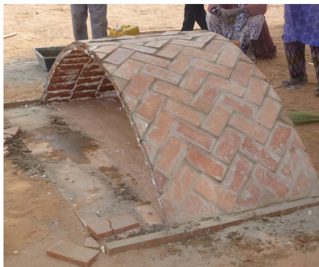
Une voûte de l'atelier de Baasneere, une fois terminée.
