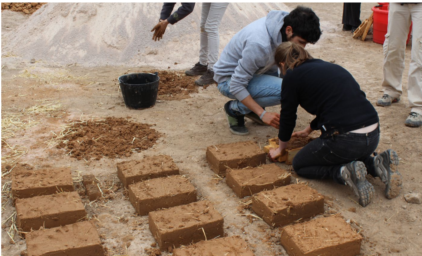
Fabrication d'adobe durant un cours de construction en terre donné à l'UPV.
