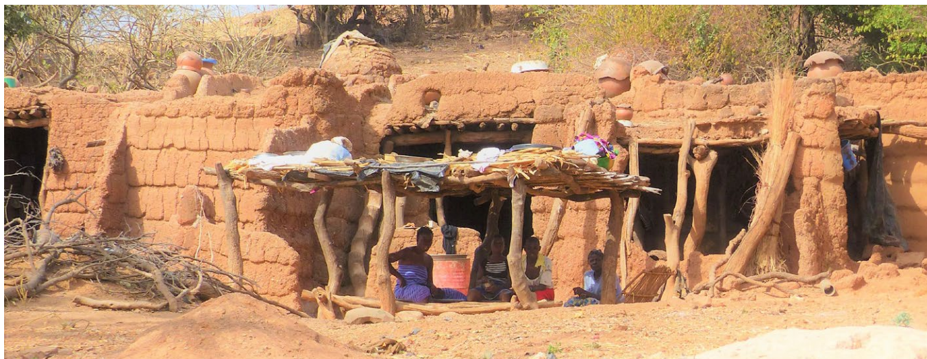
Habitation lobi avec ses caractéristiques murs en terre façonnée à assises emboîtées et porche d'entrée pour se protéger du soleil .
