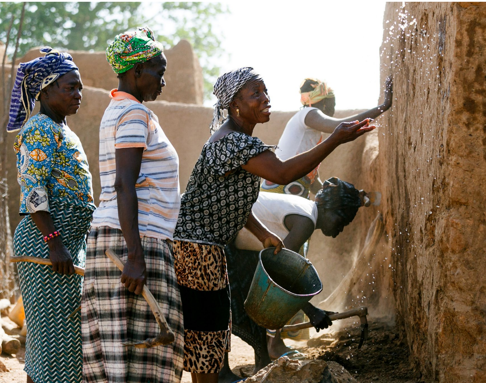
Processus de mouillage des murs en terre avant l'application de l'enduit.
