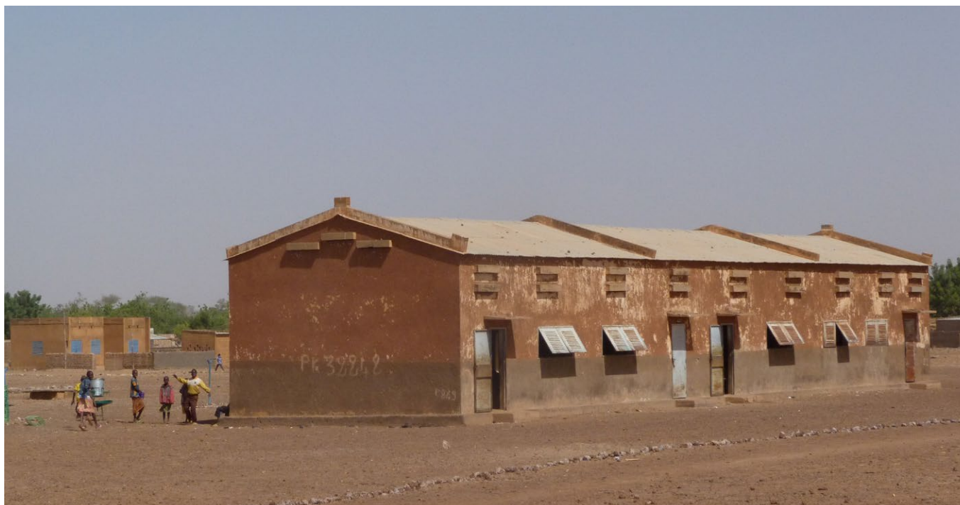
École classique, construite en blocs de béton et tôle métallique. Baasneere, Burkina Faso.
