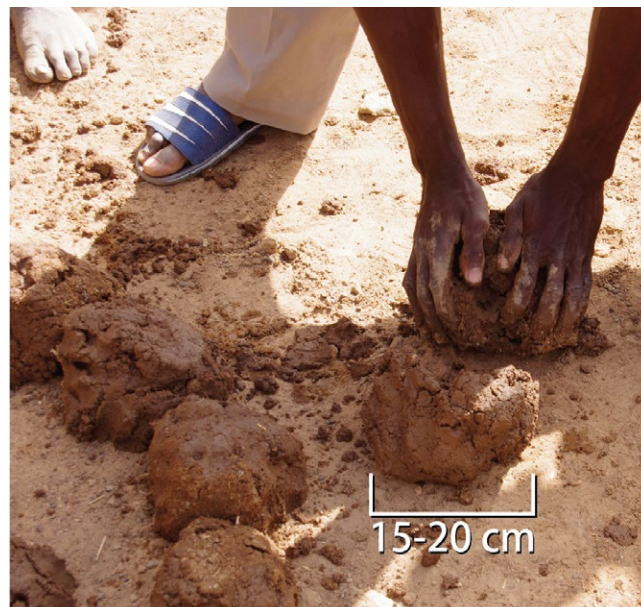
Préparation des boules de terre-argile à utiliser pour la fabrication d'un mur en terre de façonnage direct.
