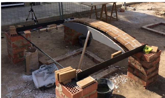
Voûte plate complète en BTC et des essais pour la construction de cloisons pour soutenir le sol.
