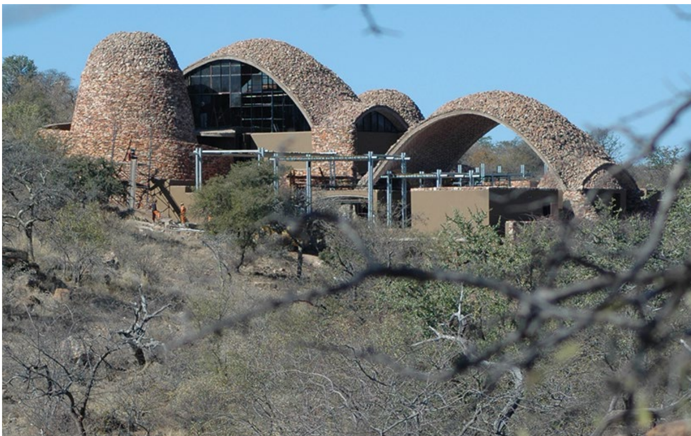
Centre d'interprétation Mapungbuwe, conçu par Peter Rich Architects.
