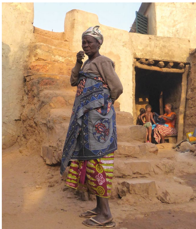
Escaliers en maçonnerie pour accéder au toit-terrasse d'une habitation bobo.
