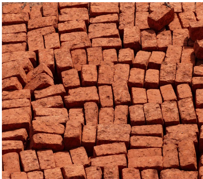
Blocs de latérite taillés empilés, en attente d'être mis en œuvre.
