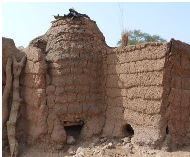
Greniers lobi intégrés aux murs de l'habitation, permettant également leur rigidification.
