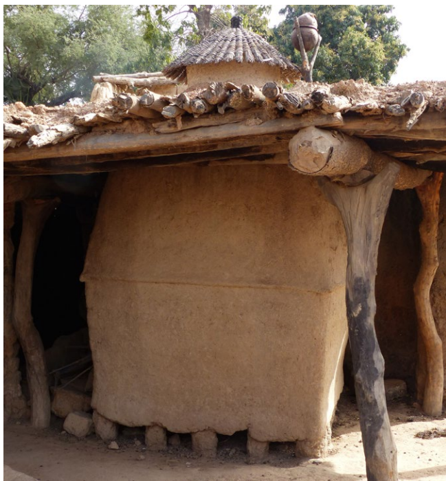
Coupoles en forme de bouteille d'un grenier birifor à l'abri d'un plancher.
