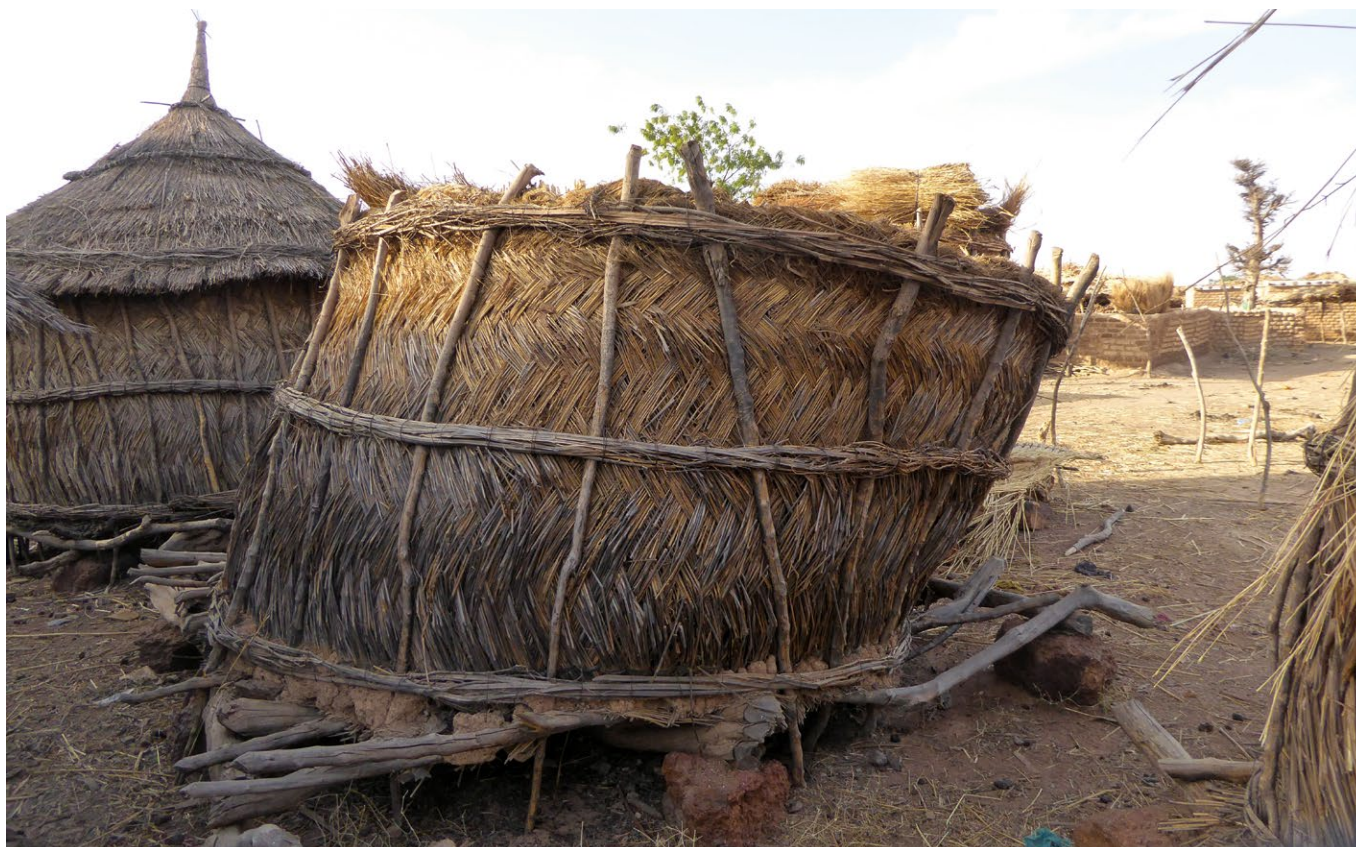
Grenier mossi à parois végétales qui ne se maintient plus correctement, car ses cercles de lianes se sont desserrés et la palissade du périmètre s'est déplacée.
