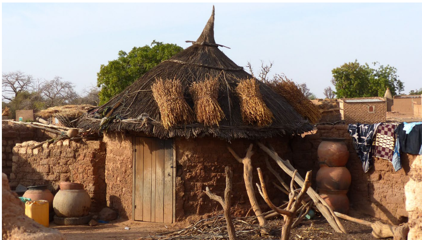
Toiture végétale conique d'une case mossi, utilisée pour stocker et sécher les bottes de céréales.
