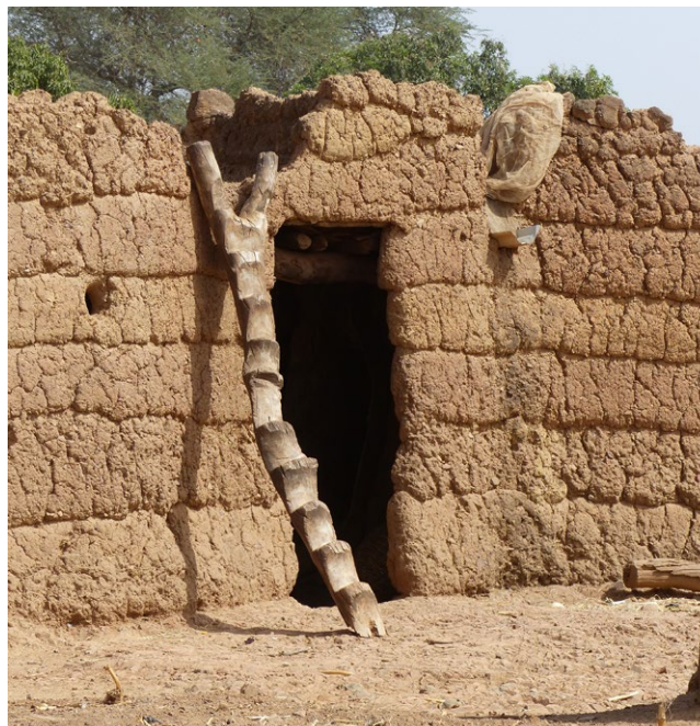
Échelle de tronc fourchu entaillé d'encoches pour former des marches dans une habitation lobi.
