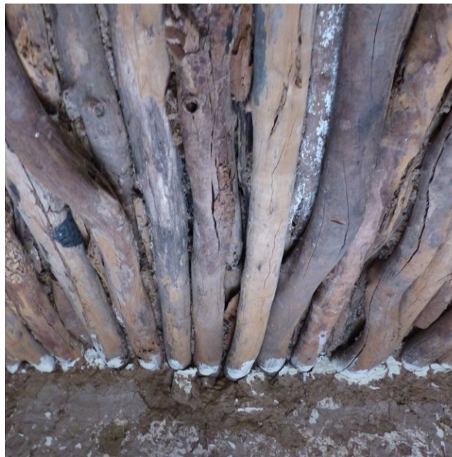
Rondins de bois non sciés utilisés comme solives serrées les unes contre les autres pour supporter le poids de l'épaisse couche de terre qui forme la toiture plate d'une habitation bobo.
