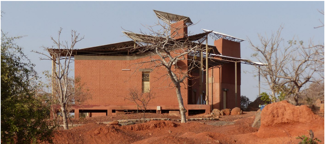
Opera Village de Francis Keré, bâti en BTC à Laongo, Burkina Faso.
