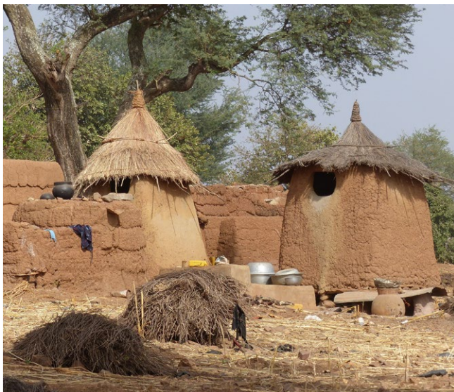
Deux greniers lobi indépendants avec leurs chapeaux végétaux respectifs et leurs bouches d'accès au sommet.
