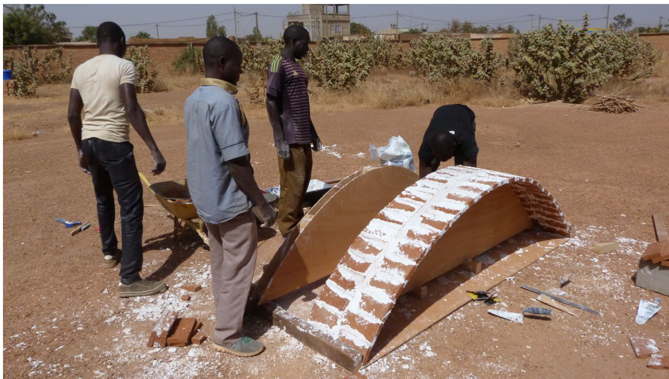
Construction de la couche inférieure de la voûte.
