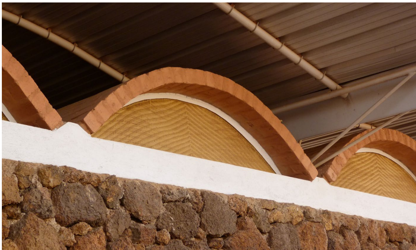
Voûtes de l'orphelinat Home Kisito à Ouagadougou (Burkina Faso), conçues par Albert Faus.
