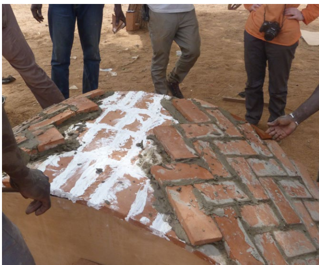
Exécution de la deuxième couche.
