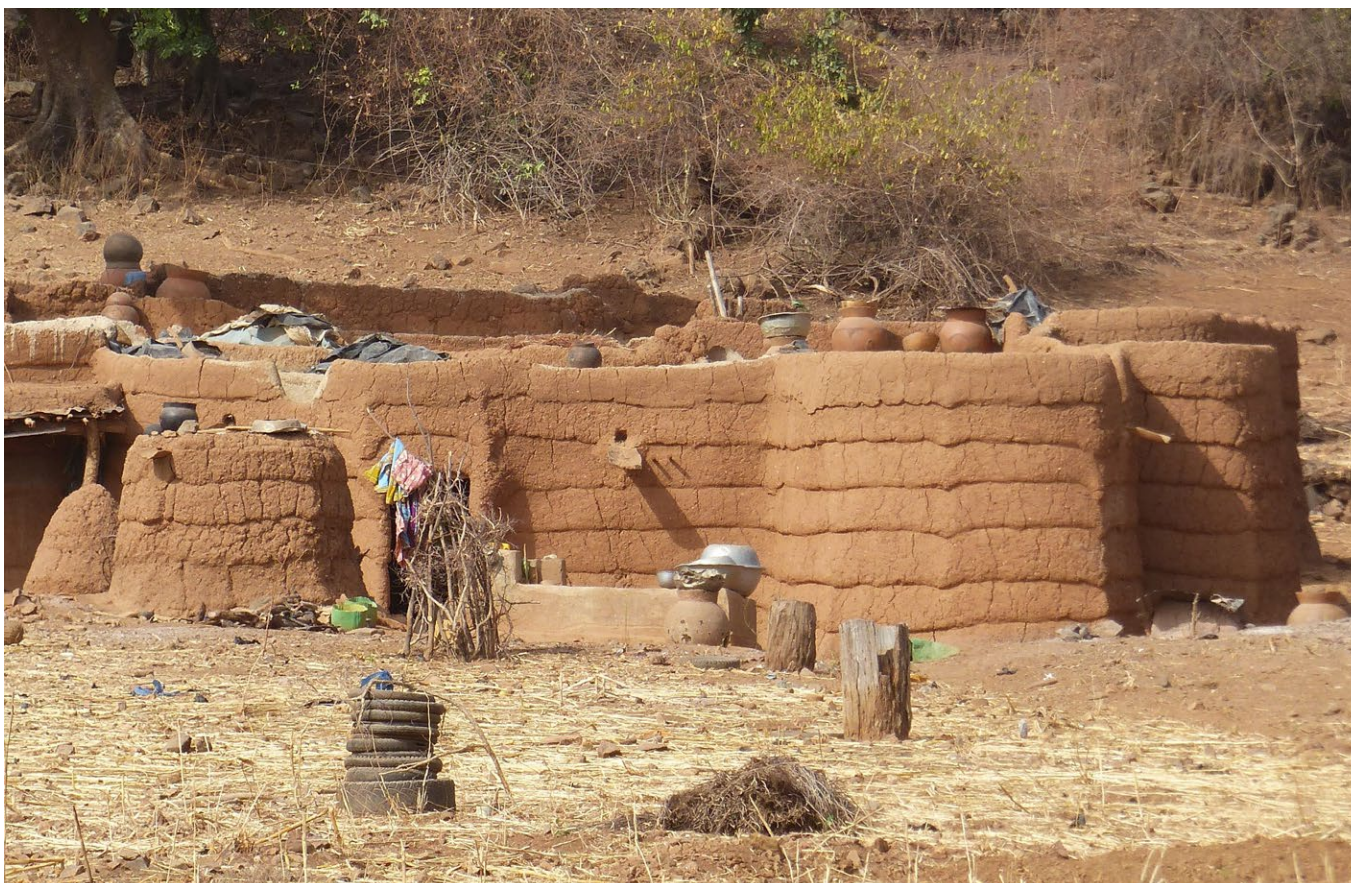
Les murs striés et sinueux d'une maison lobi répondent à des besoins constructifs et structurels, tout en étant d'une beauté unique.
