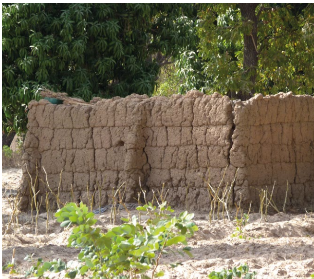
Mur en terre façonnée à assises emboîtées avec des contreforts de stabilisation dans une construction en birifor.
