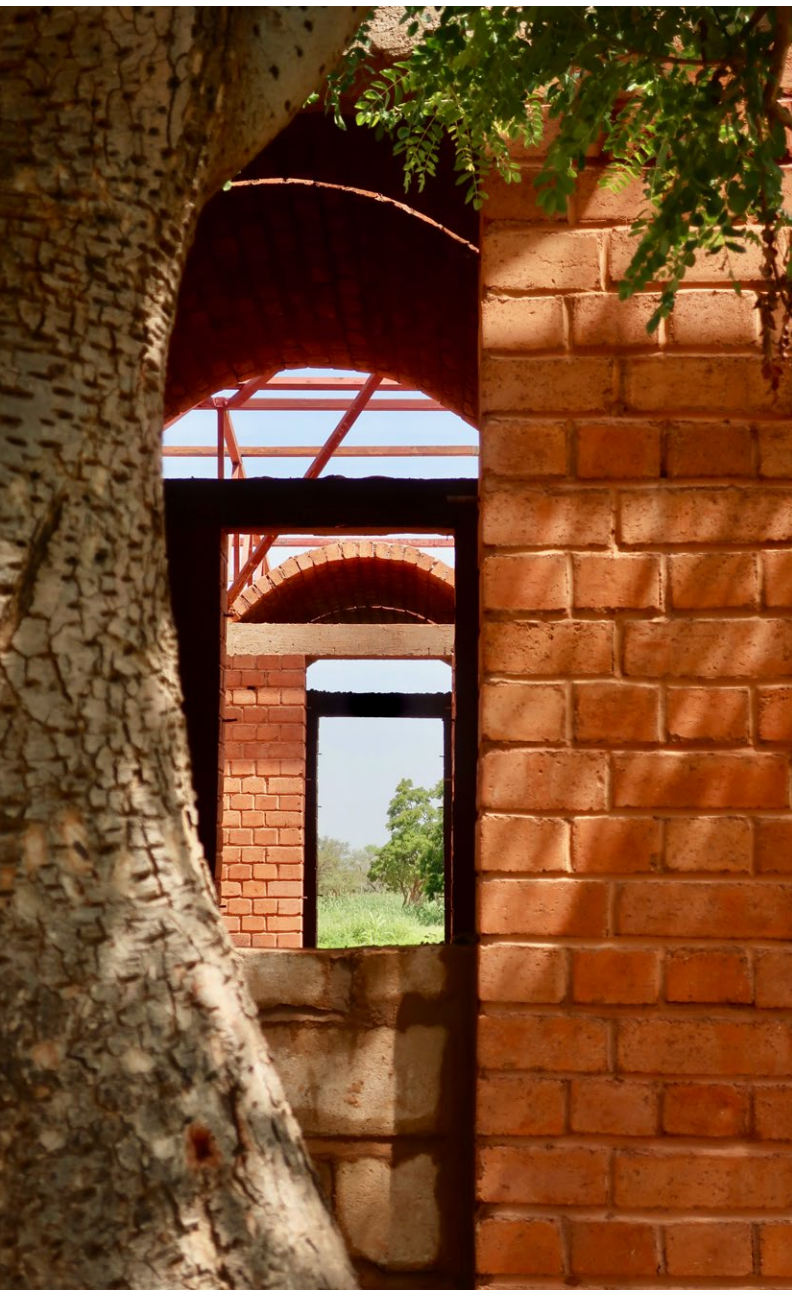
Bâtiment administratif en construction, phase 2 du projet.
