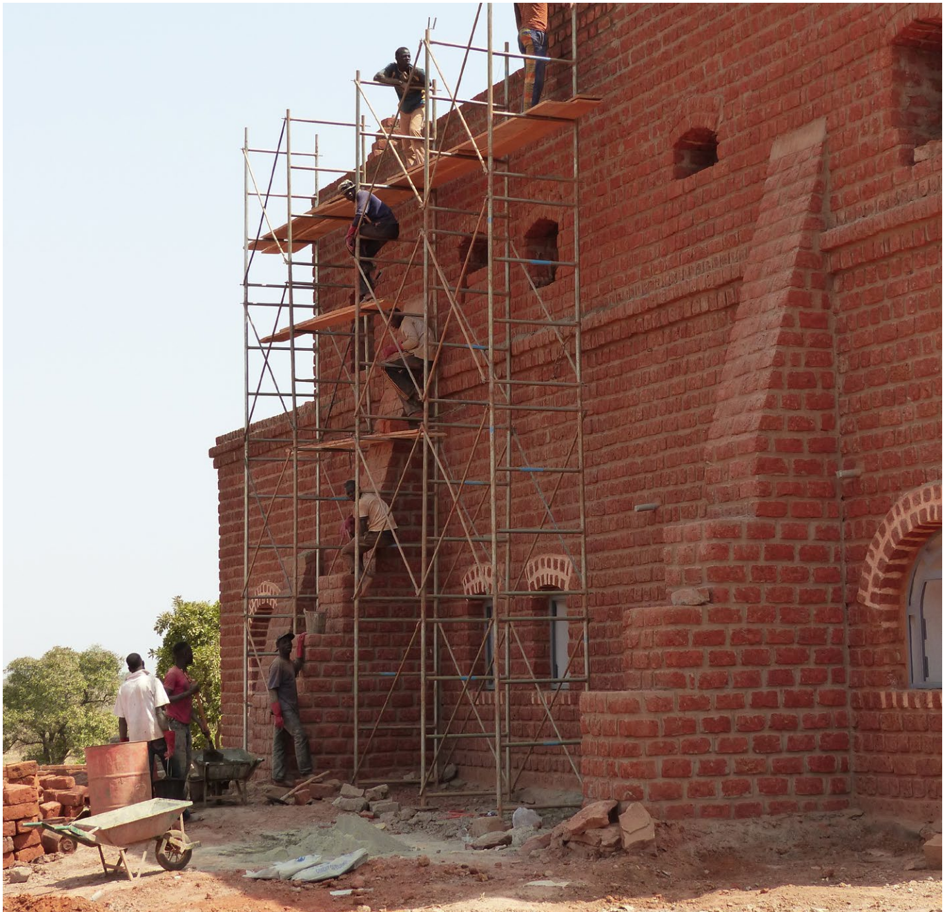
Construction du Centre de Recherche sur le karité à Satiri, Bobo-Dioulasso (Burkina Faso), conçu par Chiara Rigotti.
