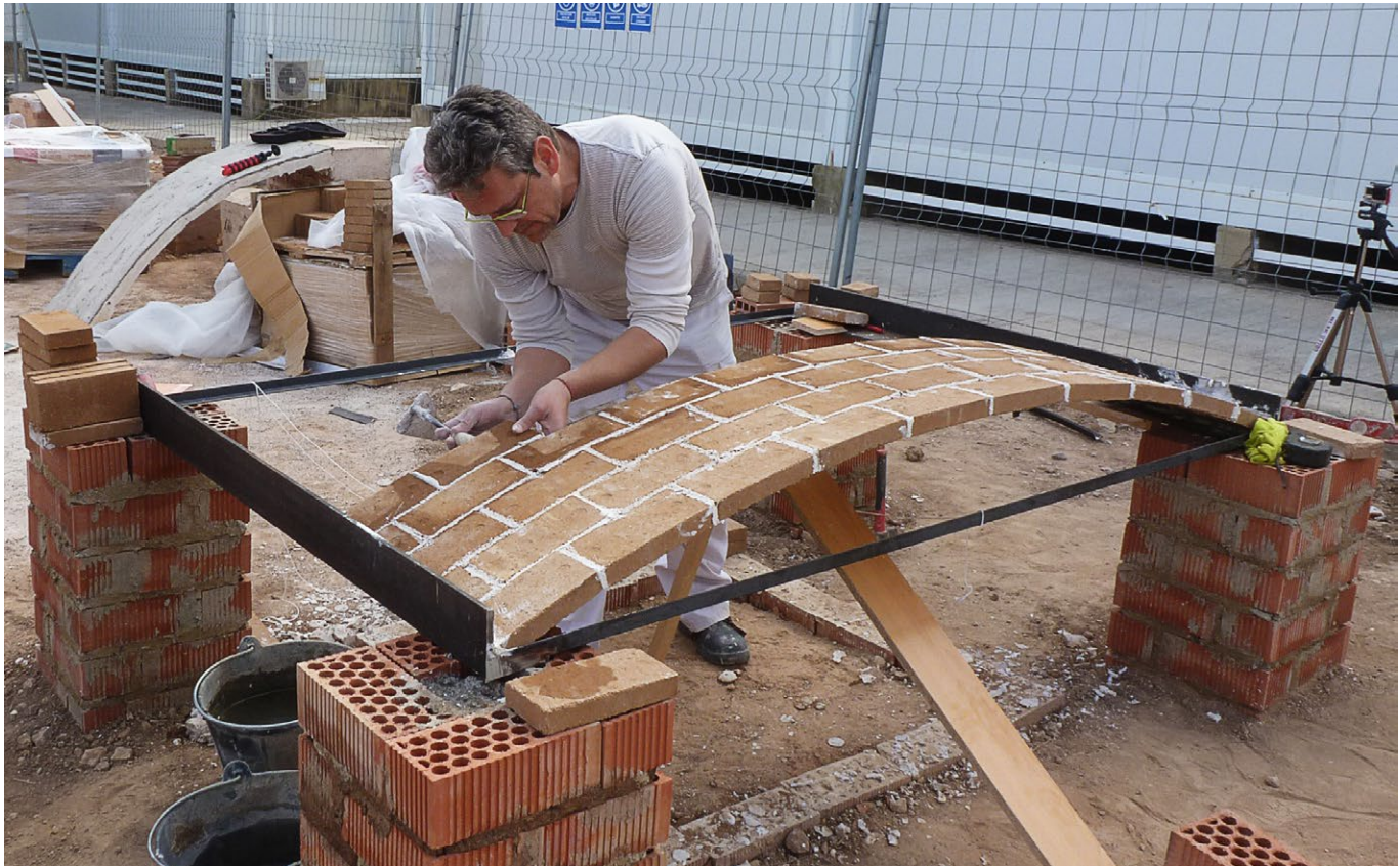
Construction d'un prototype de voûte plates en BTC dans les installations de l'Universitat Politècnica de València.
