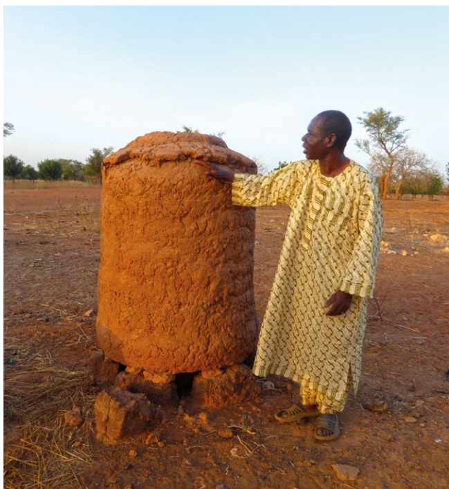
Ancien grenier mossi construit avec de la terre de termites.
