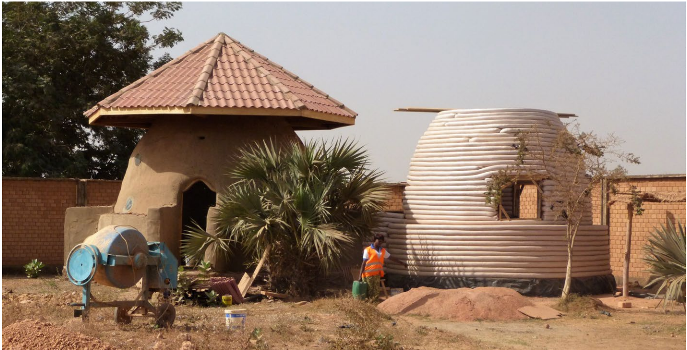
Dômes en superadobe à Ouagadougou.
