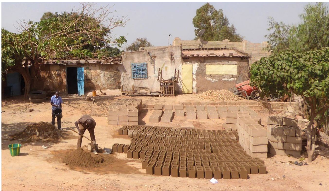
Fabrication actuelle de blocs de ciment préfabriqués à Banfora.
