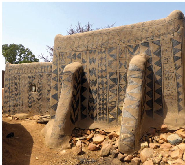
Mur d'une habitation kassena avec des contreforts
