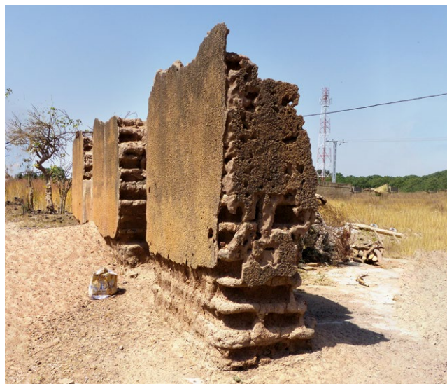
Un cas similaire au précédent, avec une affectation plus importante des parties les plus basses du mur.
