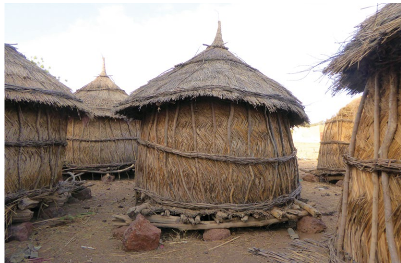
Grenier mossi cylindrique avec des parois en paille tressée renforcées par des tiges verticales et cinglées par des fagots de branches.
