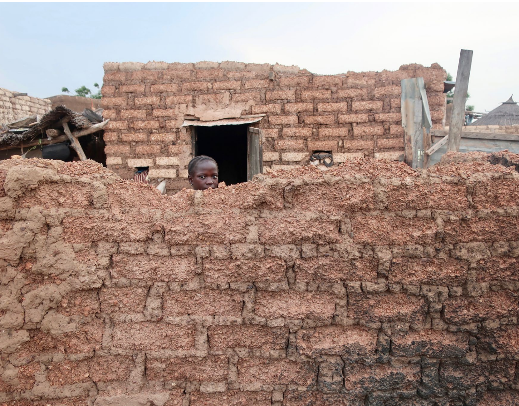
Cour secondaire à l'intérieur de la maison.
