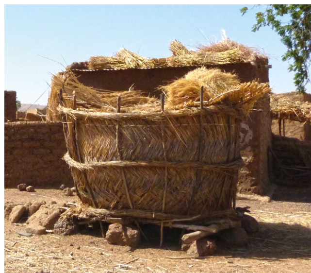
Contenant. Lorsque leur toiture végétale conique est retirée, les greniers en nattes apparaissent comme de grands conteneurs.
