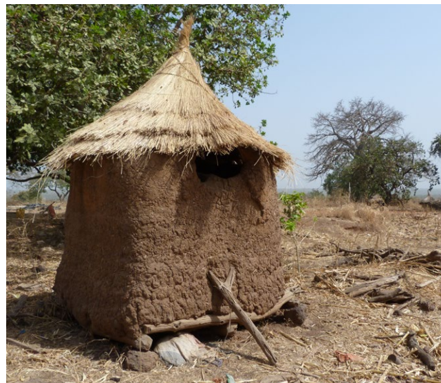
Grenier gan isolé avec un chapeau végétal et une petite fourche pour faciliter l'accès.
