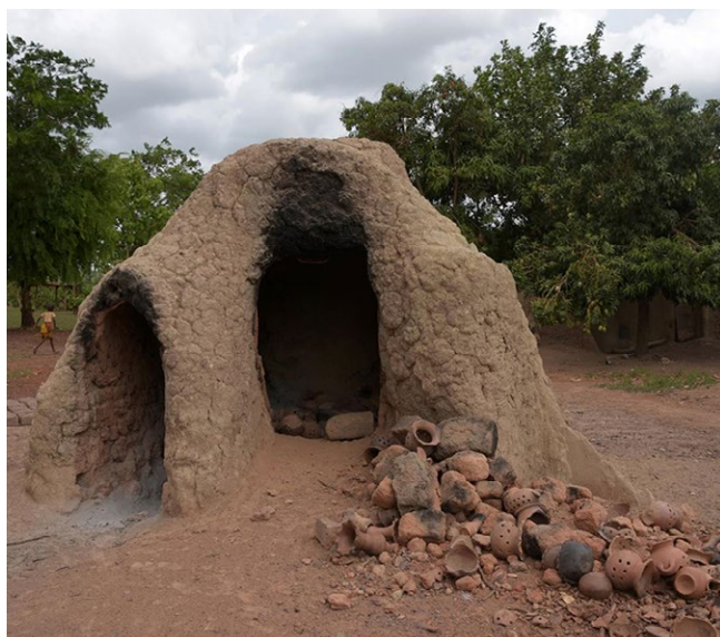
Four à céramique lobi avec deux bouches d'accès donnant lieu à d'intéressantes voûtes courbes.
