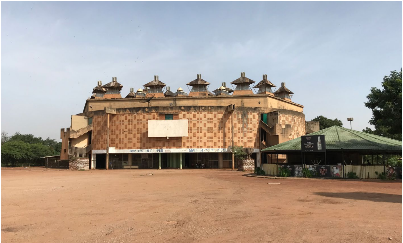
The Maison du Peuple in Ouagadougou, designed by Foblé.
