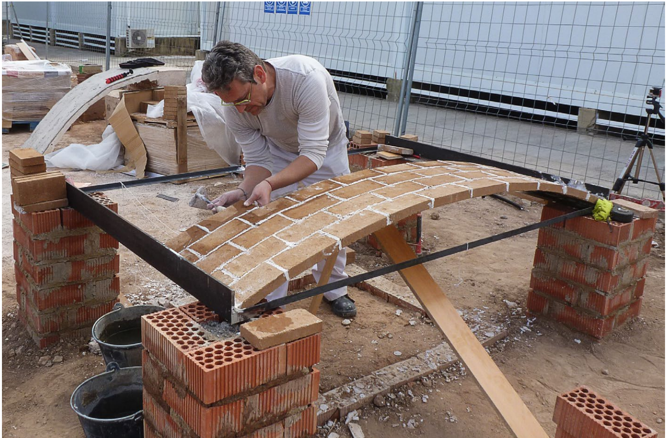
Construction of a CEB tile vault prototype in the Universitat Politècnica de València.
