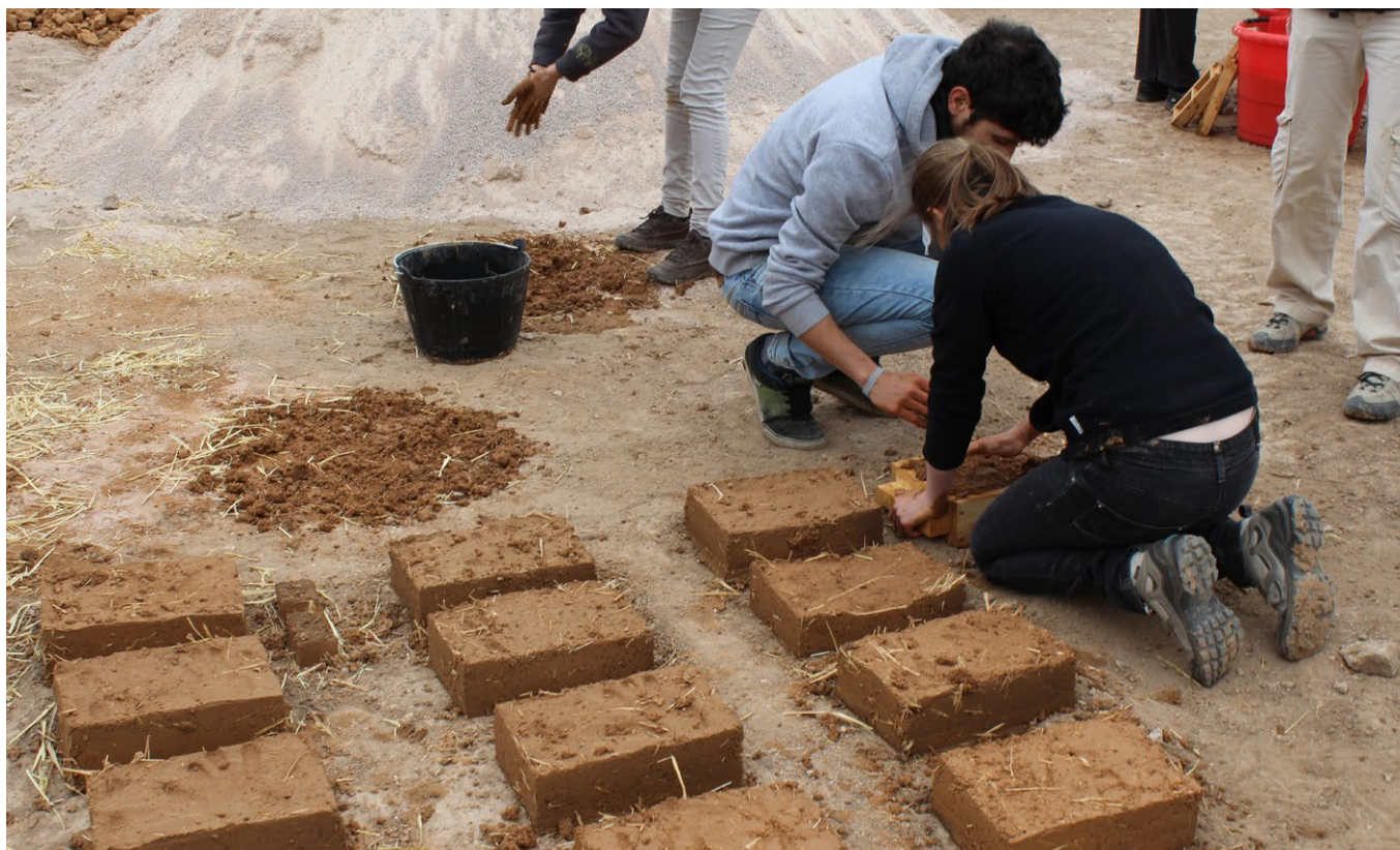
Fabricación de adobe durante un curso de construcción con tierra desarrollado en la UPV.
