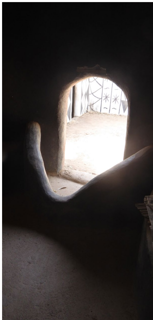
Umbral. Entrada a una vivienda kasena fotografiada desde el interior, con su pequeña entrada y el murete con cesura que obliga a traspasar el umbral agachándose y al mismo tiempo levantando los pies.
