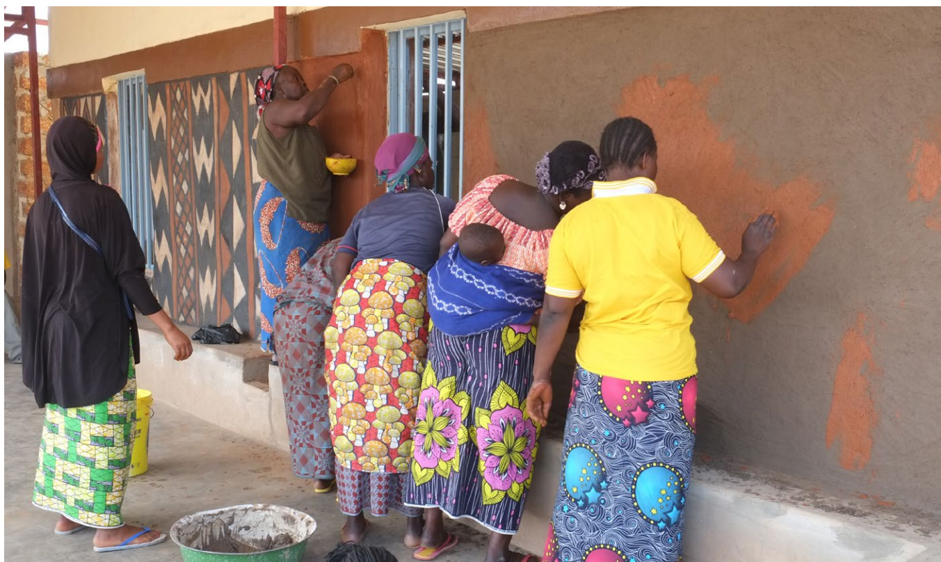
Realización de revestimientos tradicionales de tierra en el barrio de Boassa.
