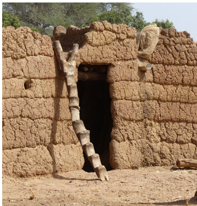
Escalera de tronco bifurcado mellado para formar los escalones en una vivienda lobi.
