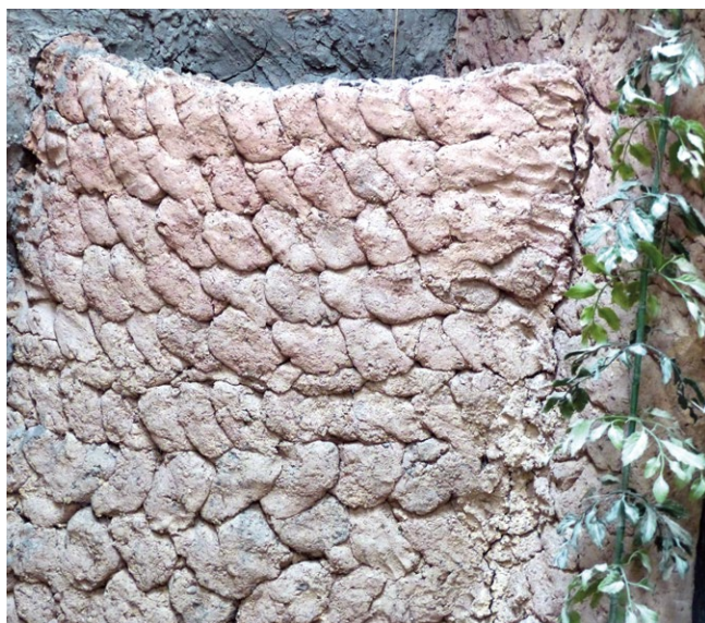
Muro de glebas colocadas sin necesidad de mortero de unión al haber sido aparejadas en fresco.
