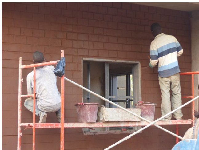
Enlucido de tierra con despiece de sillería.
