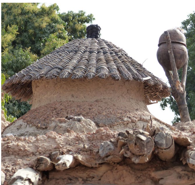
Espacio central. Las cubiertas cónicas vegetales que abundan en la arquitectura tradicional de todo el país, ya sea cubriendo las chozas circulares, los silos o los brocales de las cúpulas de los graneros en forma de gigantes damajuanas, generan geometrías radiales y acentúan el peso específico del centro.
