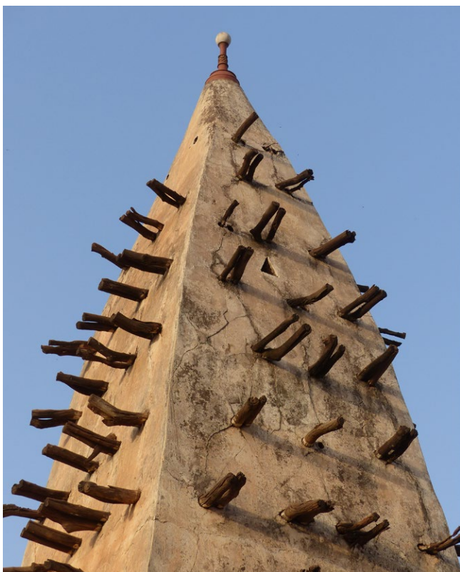
Torre de la mezquita de Bobo-Dioulasso erizada de palos y ramas que servían para encaramarse periódicamente y reparar los enlucidos de barro.
