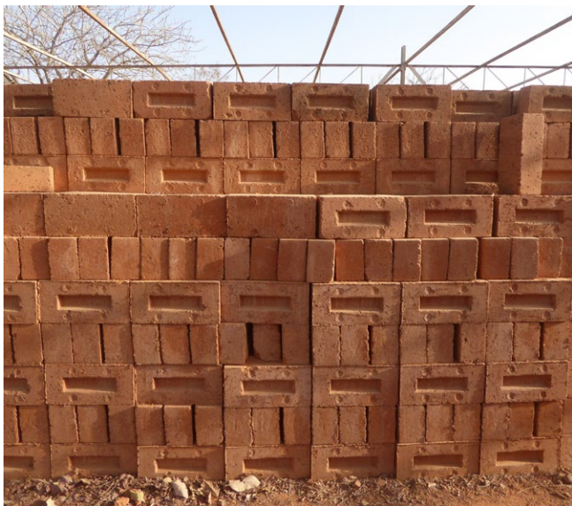
Bloques de tierra comprimidos empleados en la construcción de Opera Village, diseñada por Francis Kéré.
