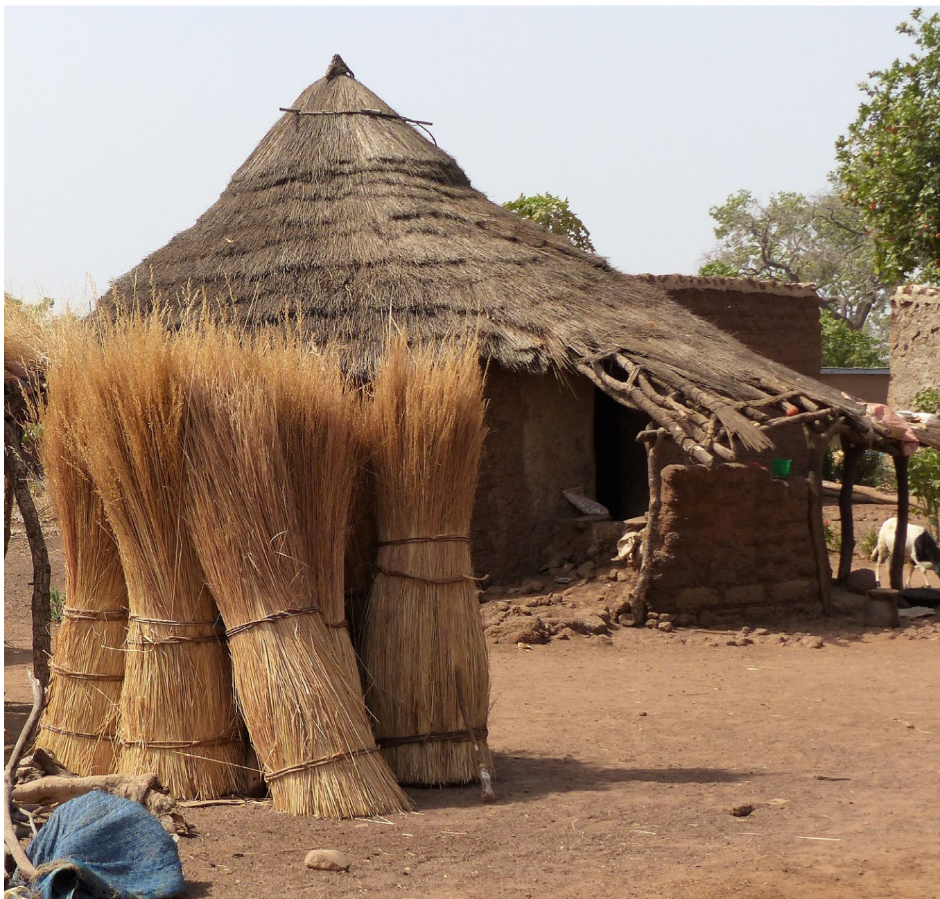
Fajos de paja preparados en un poblado gan para proceder a la reparación de las cubiertas existentes.
