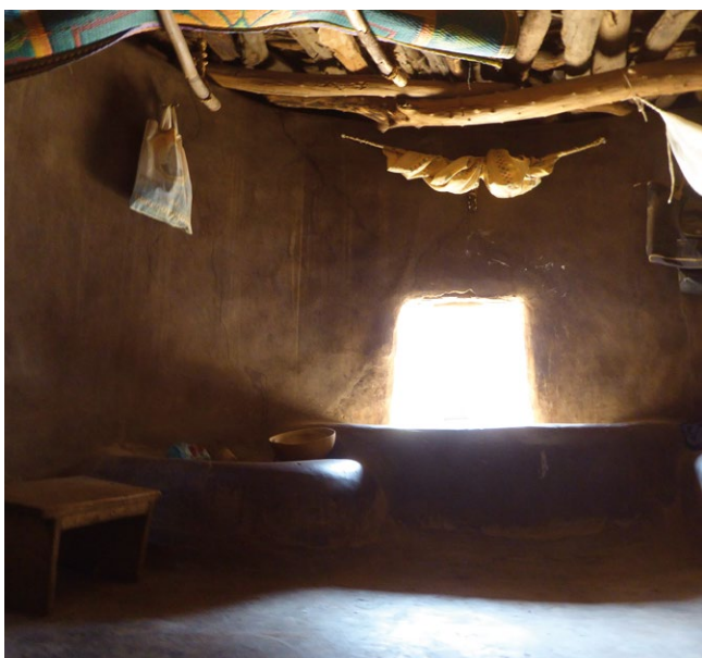
Interior de vivienda kasena con un murete frente a la puerta baja de entrada que dificulta el acceso al interior.
