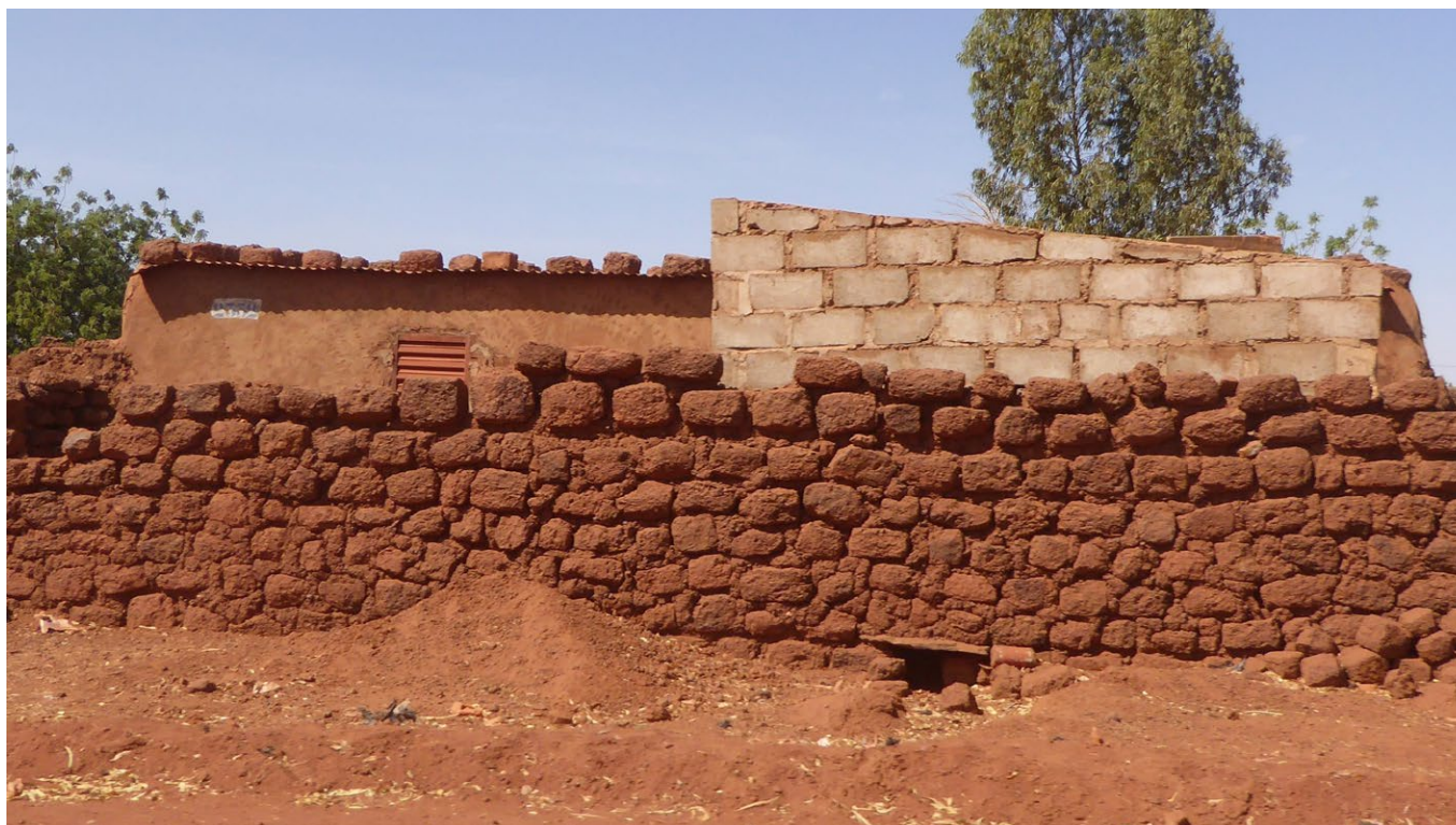
Muro de sillarejo de laterita y muro de bloques prefabricados de hormigón.
