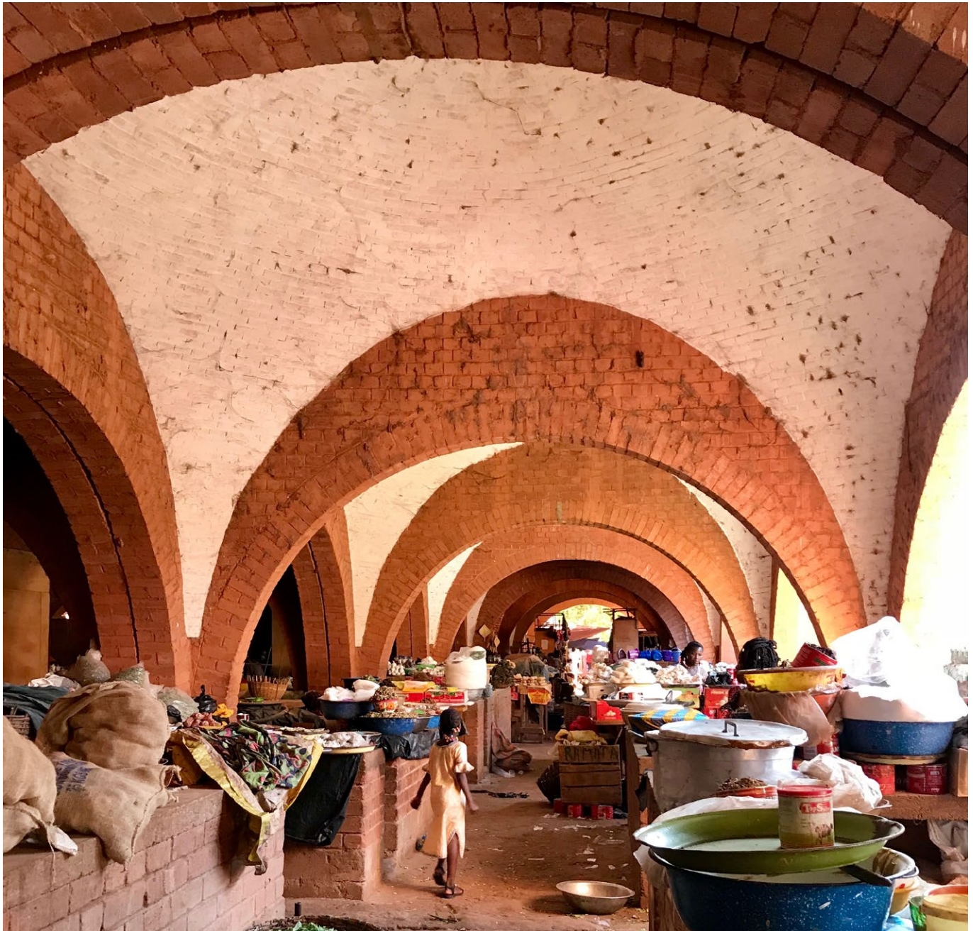
Interior del mercado de Koudougou (Burkina Faso), diseñado por Laurent Séchaud.
