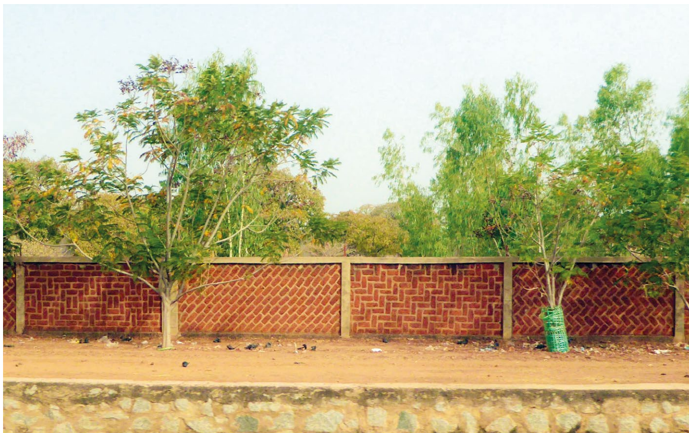
Murete bajo de piedra granítica en primer plano y muro de bloques tallados de laterita con diversos aparejos enmarcados por un pórtico de hormigón en segundo plano .
