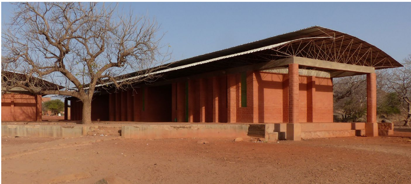
Opera Village de Francis Keré, construida con BTC en Laongo, Burkina Faso.
