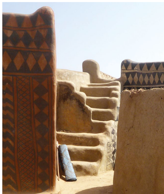
Sugestiva escalera de obra de una vivienda kasena con un guardavecinos escalonado intermedio cruzado para distinguir entre el primer tramo de escalones, también empleados como poyetes de asiento, y el segundo propiamente de acceso al terrado.
