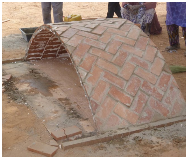
Una bóveda del taller de Baasneere, una vez terminada.
