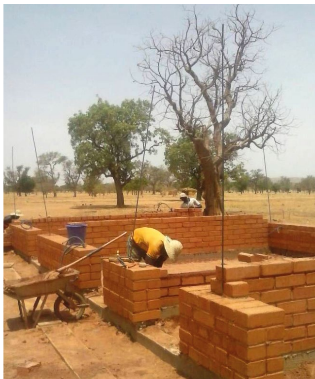
Construcción de muros con bloques de tierra comprimida armados con redondos de acero en los encuentros y las jambas.
