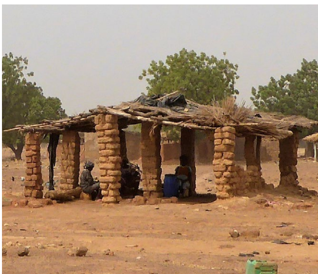
Raro cobertizo sobre pilares de adobe y cubierta tendida a dos aguas en las inmediaciones de Koudougou.
