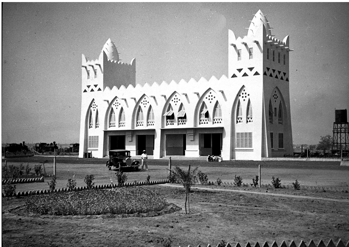
Estación de Bobo-Dioulasso, 1934.
