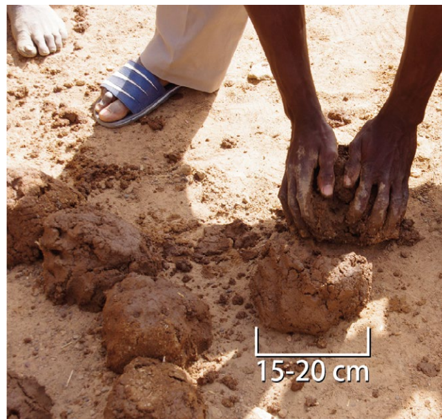
Preparación de las bolas de barro a emplear en la confección de una pared de mano.
