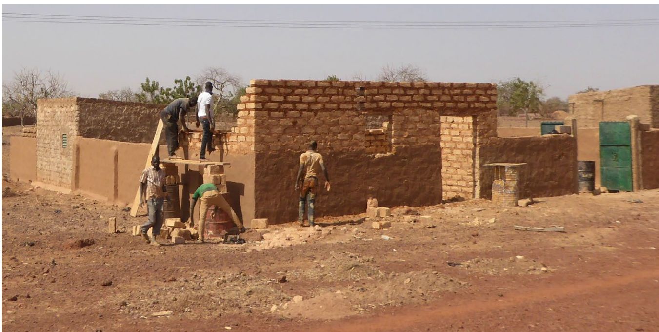
Construcción de una vivienda con adobes.
