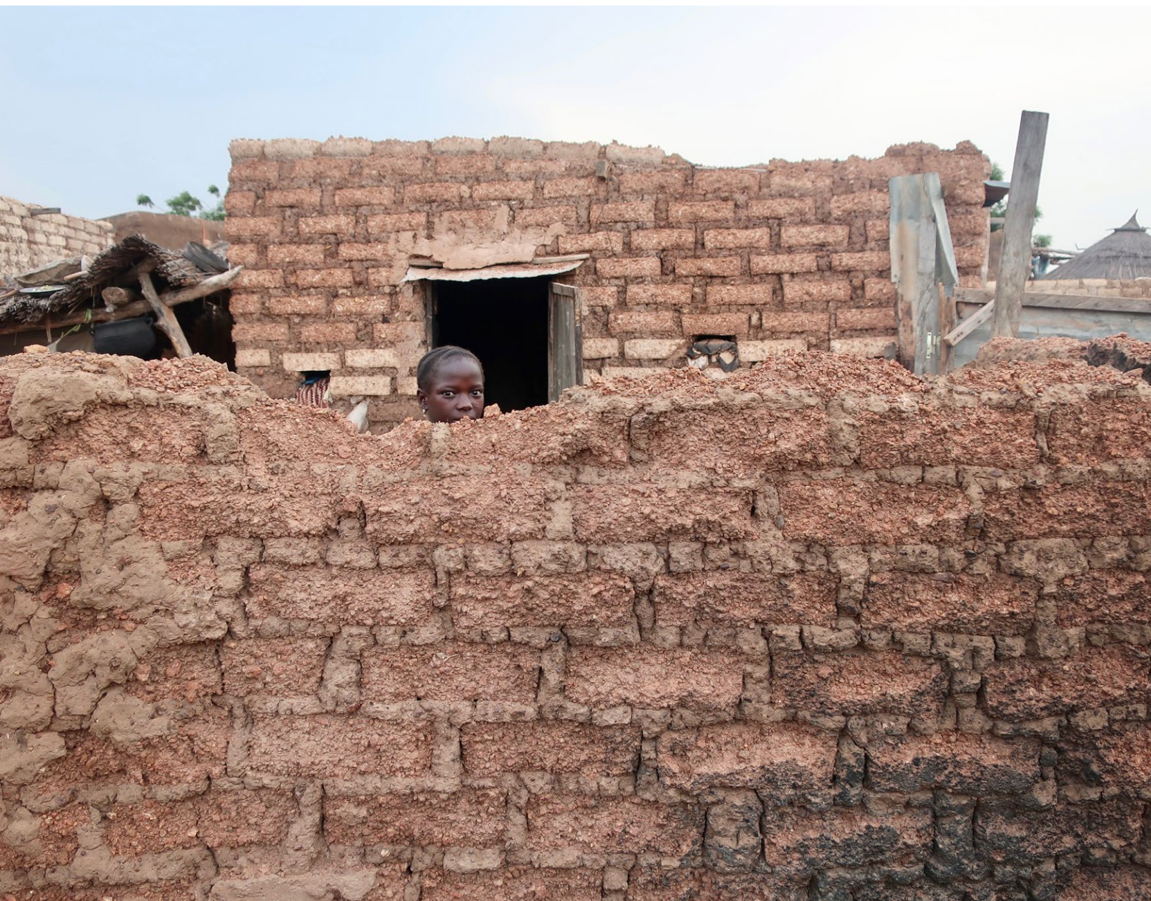
Patio secundario dentro del conjunto de la vivienda.
