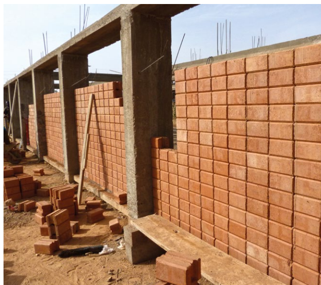
Construcción de un cerramiento de BTC en Ouagadougou, Burkina Faso.
