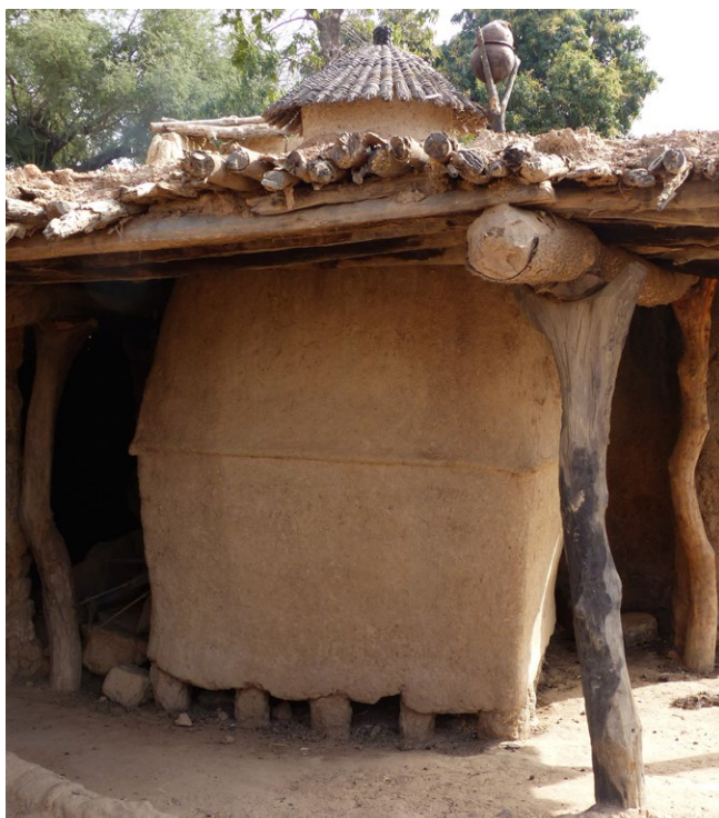
Cúpula abotellada de granero birifor amparado bajo un forjado..
