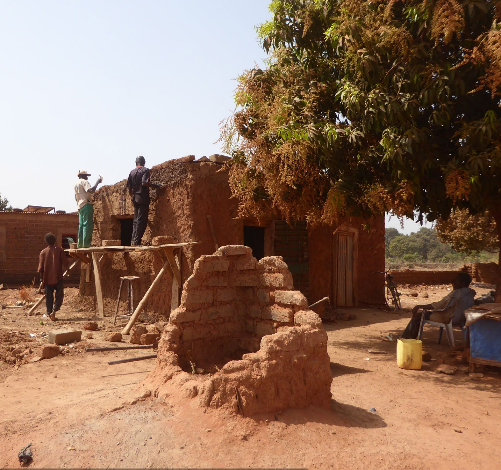
Proceso de mantenimiento de una casa con el reenlucido de barro de sus muros.
