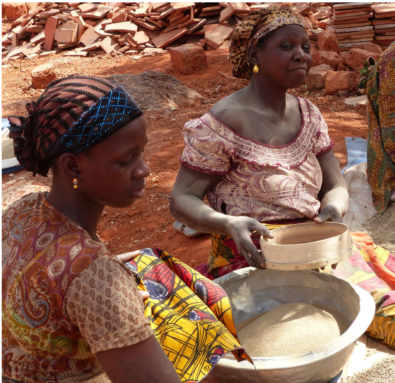
Cribado de la arena para la producción de baldosas cerámicas in situ al pie de un edificio en construcción.
