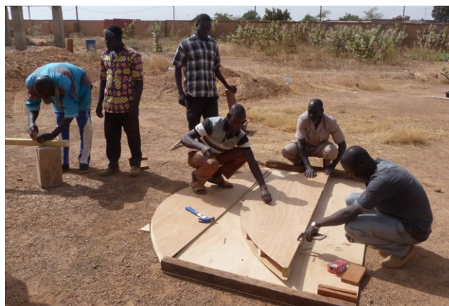
Fabricación de las cimbras de madera.
