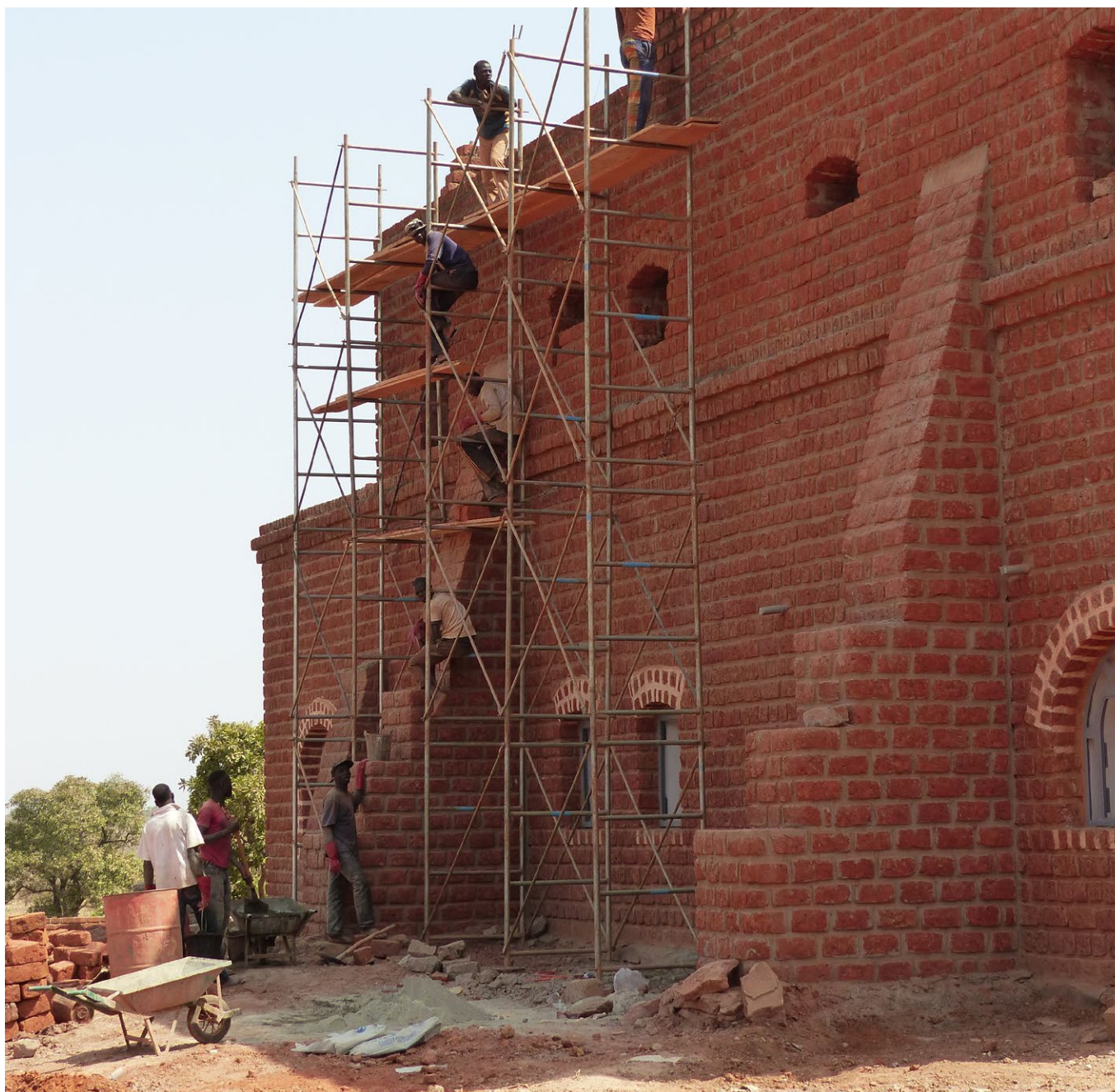
Construcción del Centro de Investigación sobre el karité en Satiri, Bobo-Diulasso (Burkina Faso), diseñado por Chiara Rigotti.
