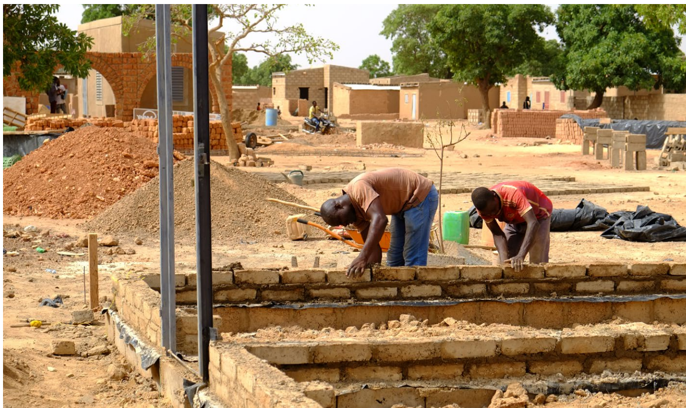
Construcción de edificios durante el proyecto de mejora del barrio de Boassa.
