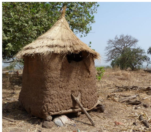
Silo gan exento con caperuzo vegetal y una pequeña horquilla para facilitar el acceso.
