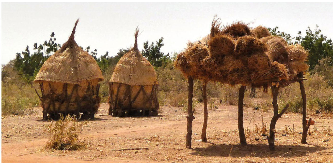
Dos silos con cubierta de paja bulbosa apuntada, junto a un cobertizo pertrechado con un buen estrato de paja.
