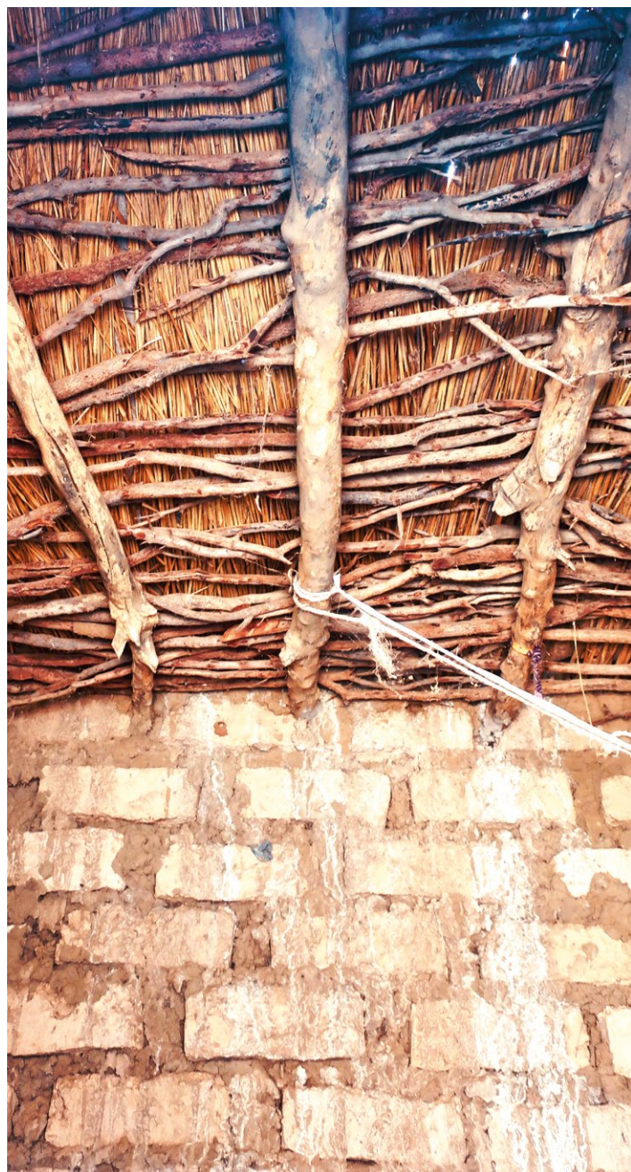
Vista de una cubierta plana tradicional.
