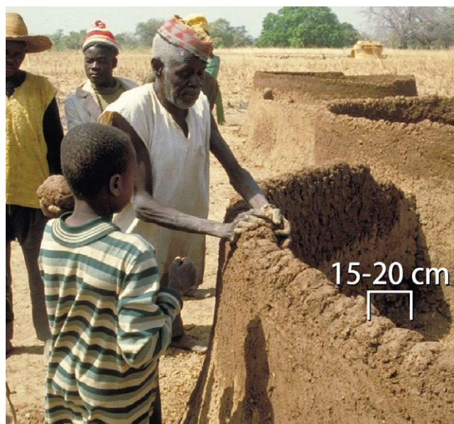
Construcción de pared de mano.
