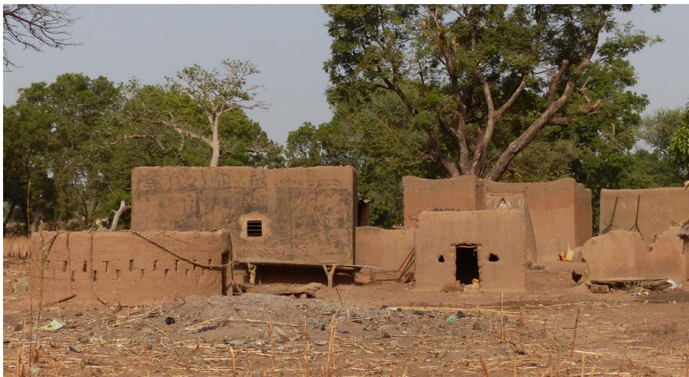
Vanos de diverso tipo en una vivienda kasena: corral circular de muro calado separando el aparejo de los adobes; ventanuco de lamas; y puerta de acceso adintelada con perforaciones abiertas a ambos lados de iluminación.
