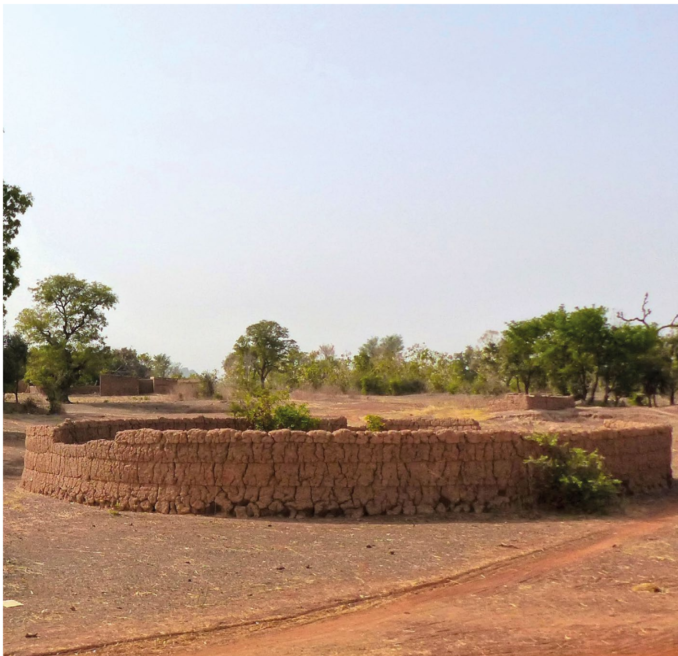
Recinto. Corral birifor circular conformado con un muro curvo de hiladas encabalgadas.
