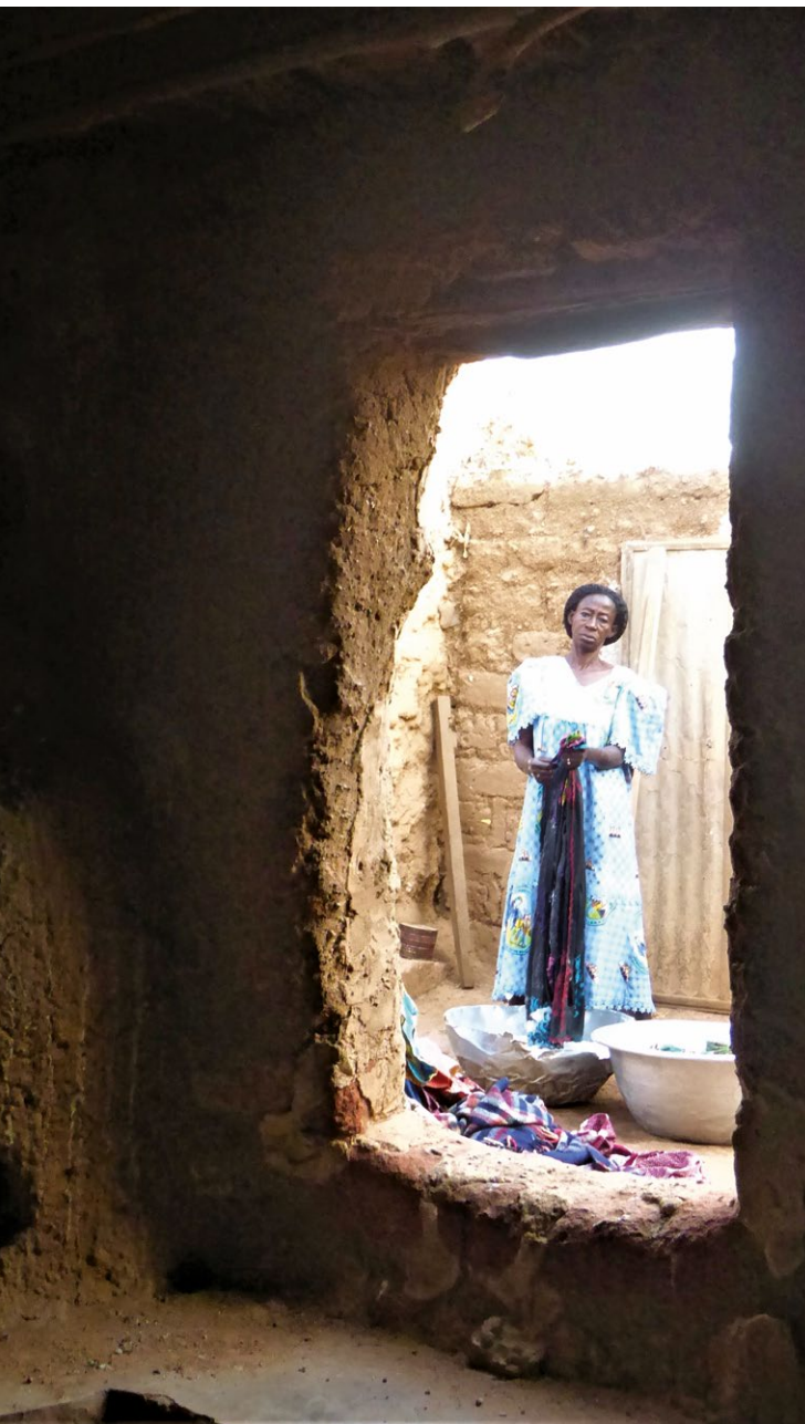
Vano adintelado de acceso a vivienda bobo.
