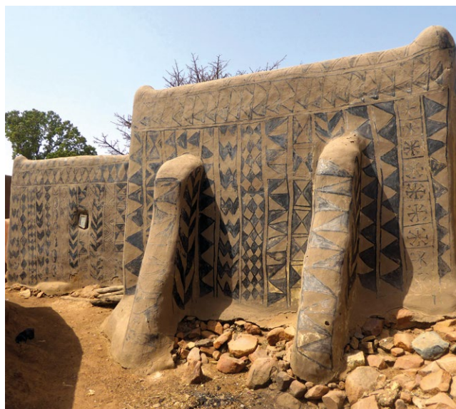
Muro de una vivienda kasena con contrafuertes.
