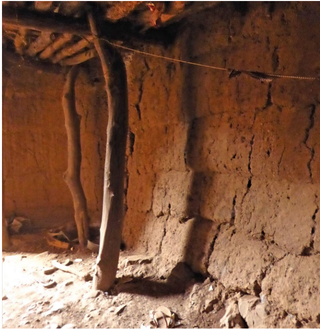
Pilar con extremo bifurcado junto a un muro de hiladas encabalgadas de una vivienda lobi, sobre la que arroja una sugestiva sombra escalonada .
