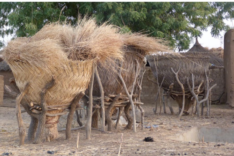
Silo mossi sin témpano de base, estrangulado con cuerdas, en forma de cuévano apoyado en su punta y un conjunto de troncos bifurcados en su perímetro.
