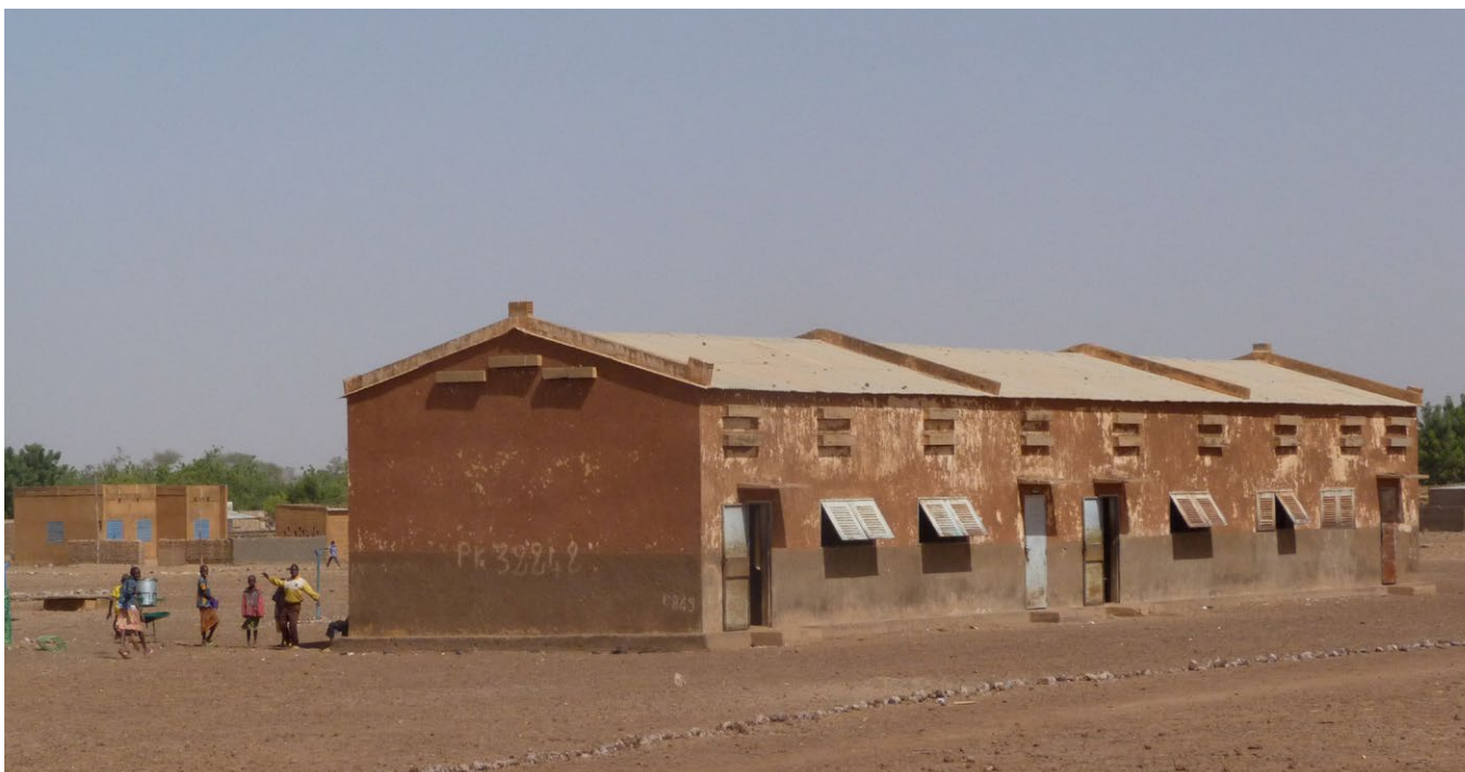
Escuela convencional, construida con bloque de hormigón y chapa metálica. Baasneéré, Burkina Faso.
