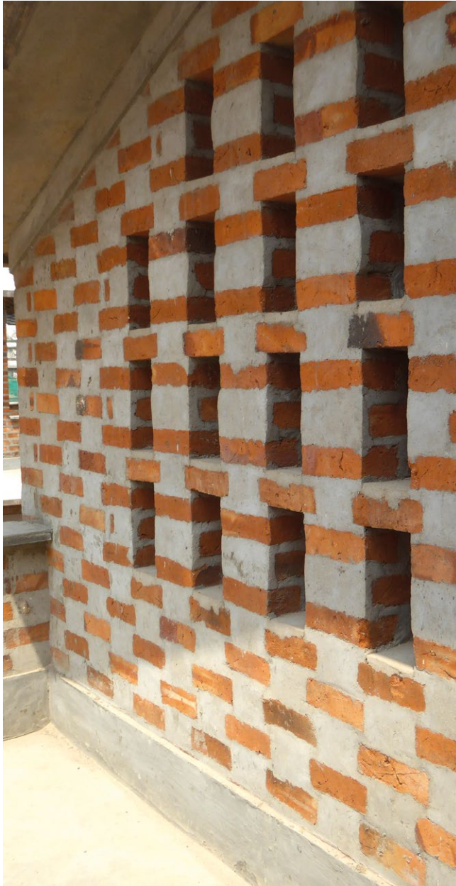
Detalle del aparejo de los muros en las viviendas de Karimadom Colony, Trivandrum (India), diseñado por Laurie Baker.
