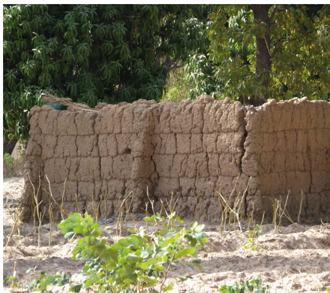
Muro de hiladas encabalgadas con contrafuertes de estabilización en una construcción birifor.
