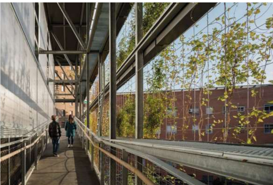
Figura 152: Rampa que conecta las calles a diferente cota.
