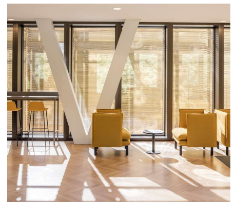
Figura 197: Protección solar en fachada de paneles perforados.
