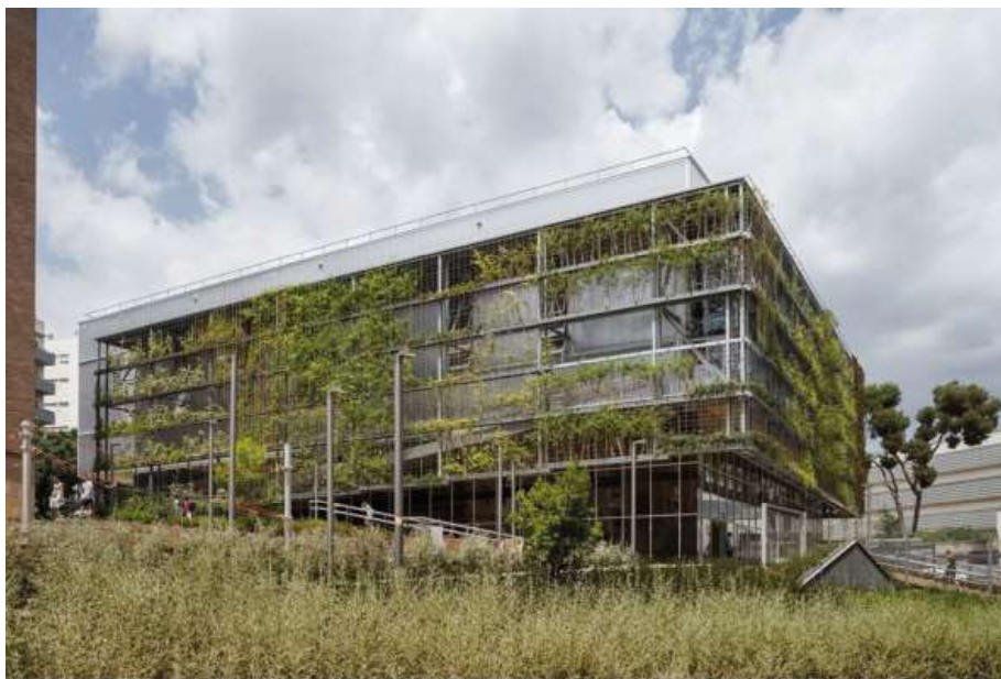
Figura 129: Polideportivo visto desde la zona verde.
