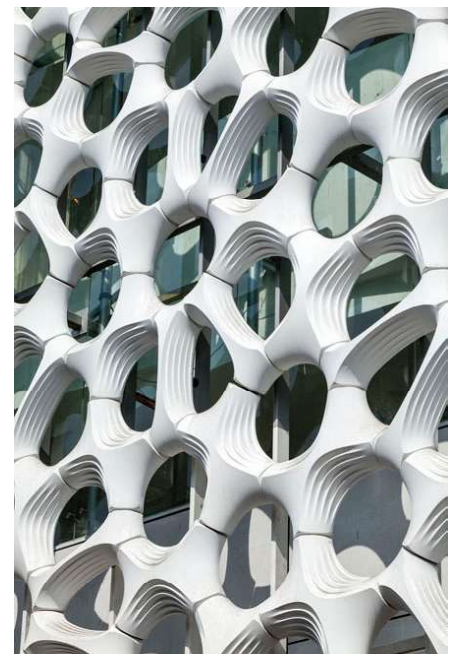
Figura 72: Torre de Especialidades. Hospital Manuel Gea Gonzales.
