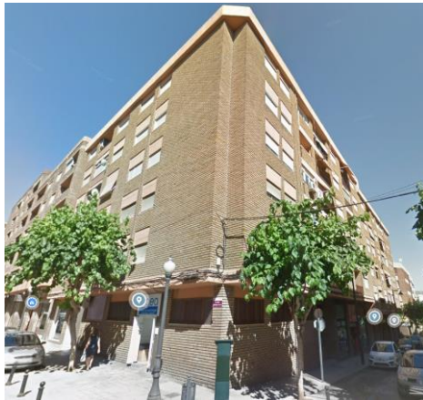
Figura 10: Fachada Sur y Este. Fuente: Google Maps
