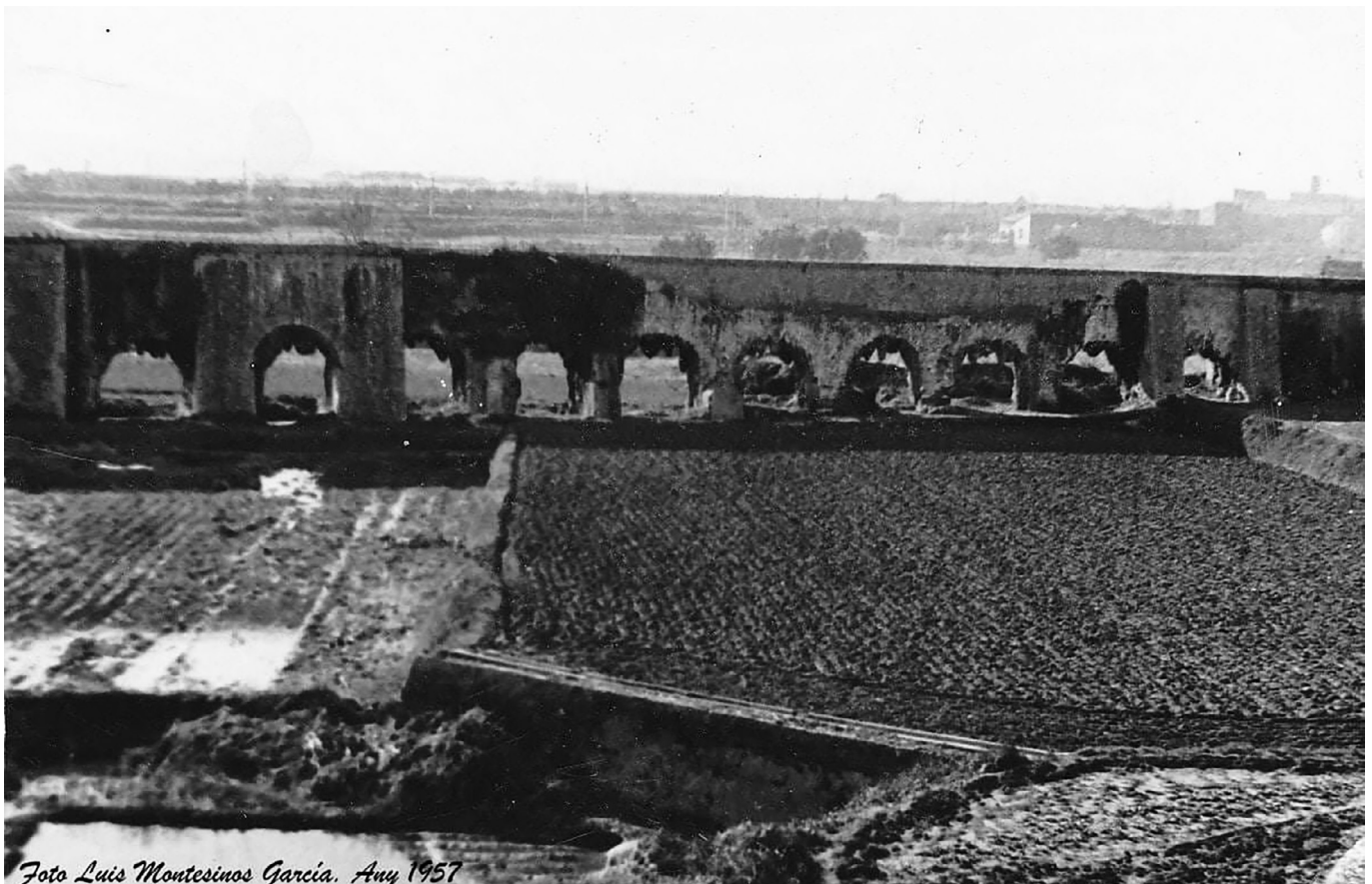
Figura 2. Fotografía del estado de los arcos en 1957, cedida por el Ayuntamiento de Manises.
