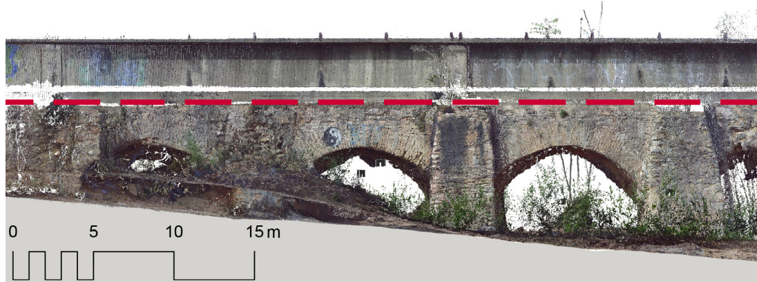
Figura 6. Los tres primeros arcos, de factura cristiana. Levantamiento con escáner 3D.
