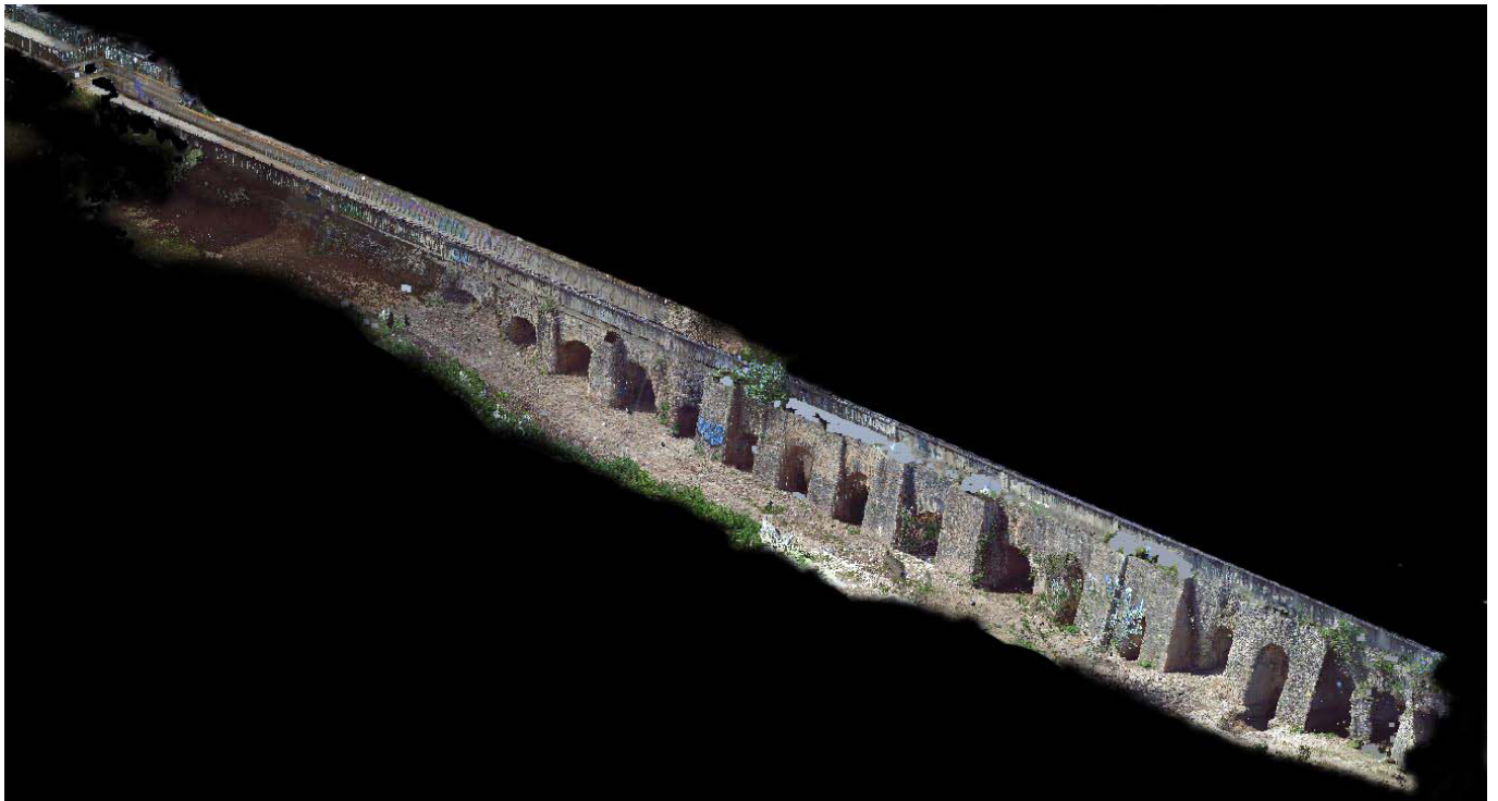
Figura 4. Perspectiva general del acueducto. Nube de puntos extraída del escaneado 3D.
