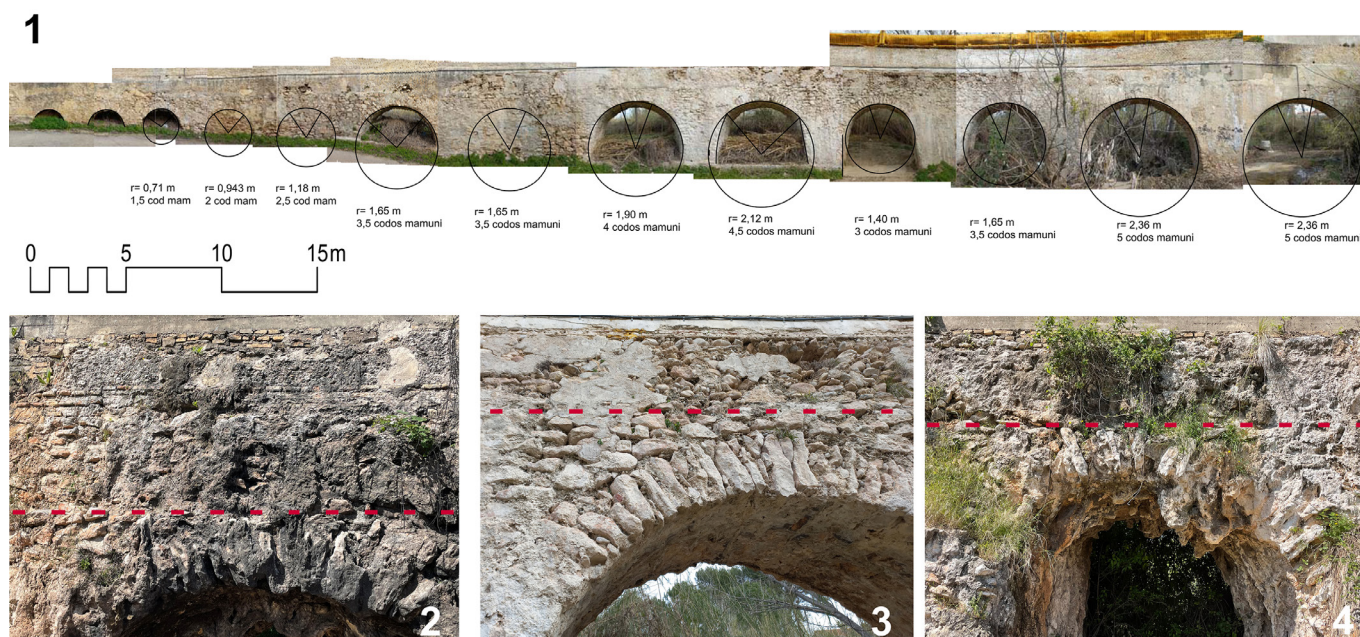
Figura 11. 1: Análisis metrológico del acueducto sobre el barranco de Granolera en Riba-Roja (Valencia). 2 y 4: Línea que indica el cambio de aparejo en el frente del acueducto de Els Arcs. 3: Línea que indica el cambio de aparejo en el frente en el acueducto de Riba-roja.
