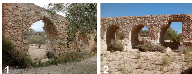
Figura 10. 1: Acueducto de l'Arcá, en Relleu (Alicante), del siglo XV. Fotografía de Oscar Calvé., Fondo CDR, tomada de Arciniiega, 2019, p, 131. 2: acueducto sobre el Barranc dels Arcs, en Elche (Alicante), fechado en el siglo XIII.
