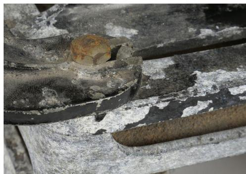
FIG. 22. Detalle de la corrosión del aluminio, pérdida y levantamiento de la película pictórica en la base del proyector
