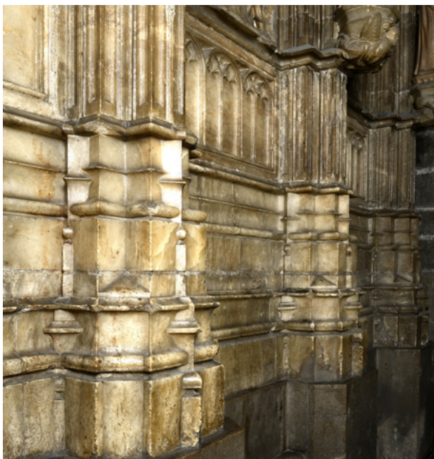
FIGURA 4. Basamento de los pináculos de la fachada del trascoro de la catedral de València
