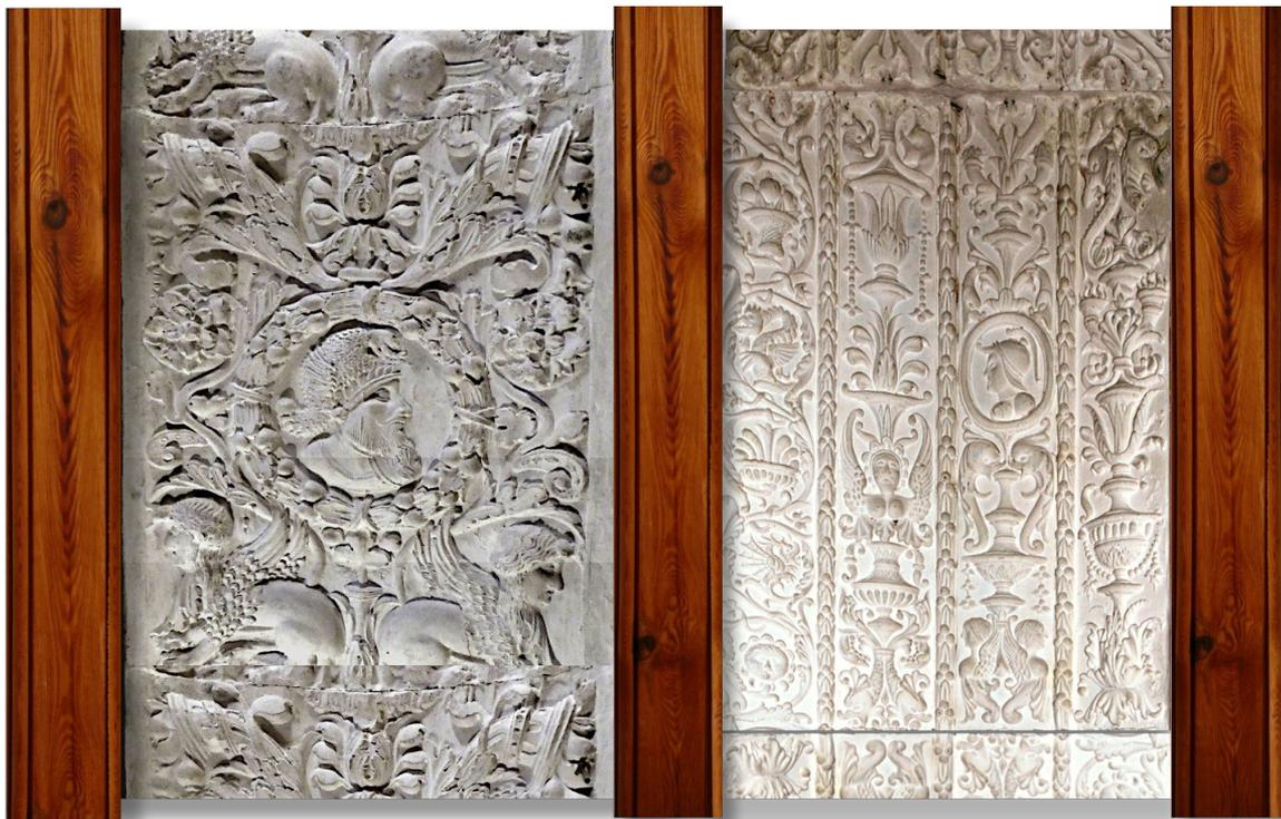
**Fig. 11.** Detalles de dos entrevigados premoldeados del Castillo-Palacio de Benisanó (Valencia). El de la izquierda está formado por una única pieza. El de la derecha es una composición de láminas y cordones de laurel que admite distintas combinaciones. Fuente: Fotografía del autor.
