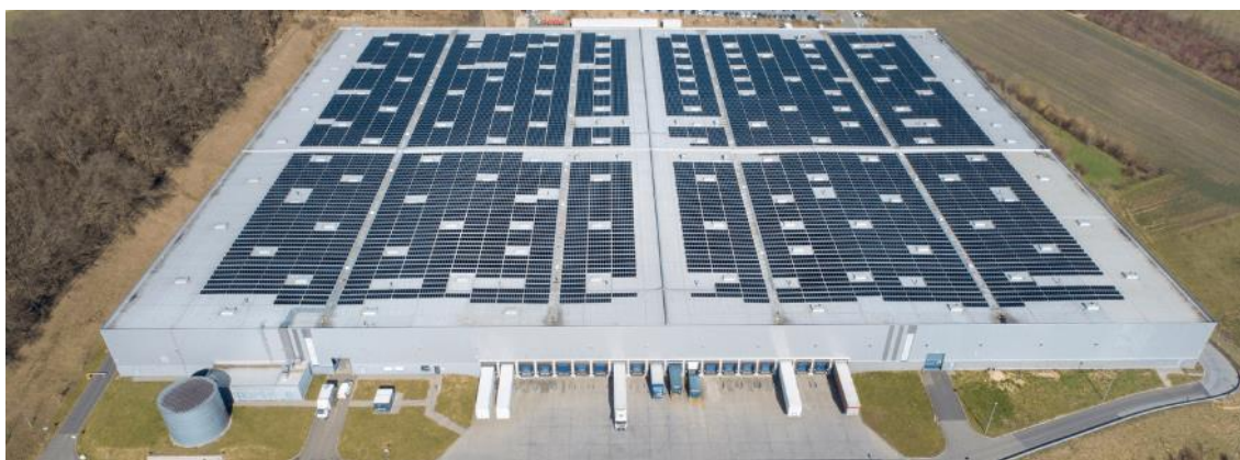
ILUSTRACIÓN 22. INSTALACIÓN DE PLACAS SOLARES EN UNA EMPRESA INDUSTRIAL. FUENTE: TOTAL ENERGIES. (TOTAL ENERGIES, 2021)
