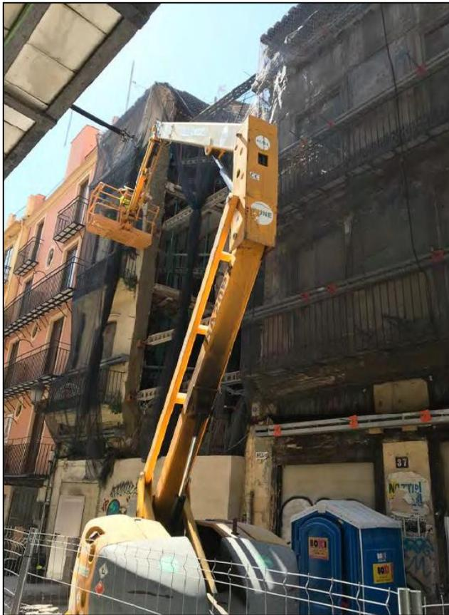
Figuras nº64 y nº 65: colapso de edificio en Corona 35 y situación de ruina inminente para los edificios laterales de calle Corona 33 y 37.
