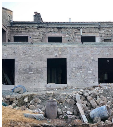
Figura 95. Nuevo muro de hormigón ciclópeo.
