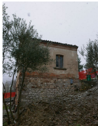
Figura 130. Apariencia exterior antes de la intervención.
