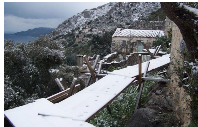
Figura 172. Imágenes de la obra.
