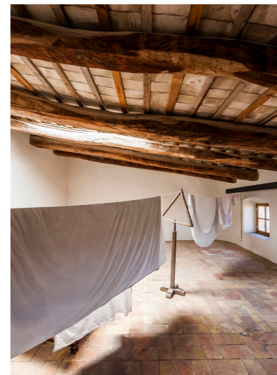
Figura 19. Forjado planta superior.
