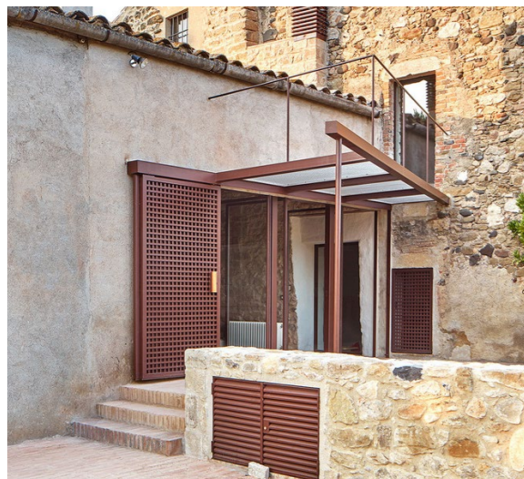
Figura 73. Entrada exterior al comedor-barbacoa.
