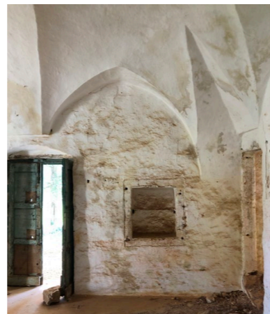
Figura 153. Entrada desde el interior antes de la intervención.
