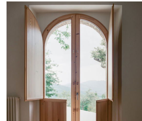
Figura 145. Carpinterías de madera.
