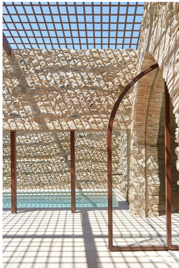
Figura 70. Patio en segunda planta después de la intervención.
