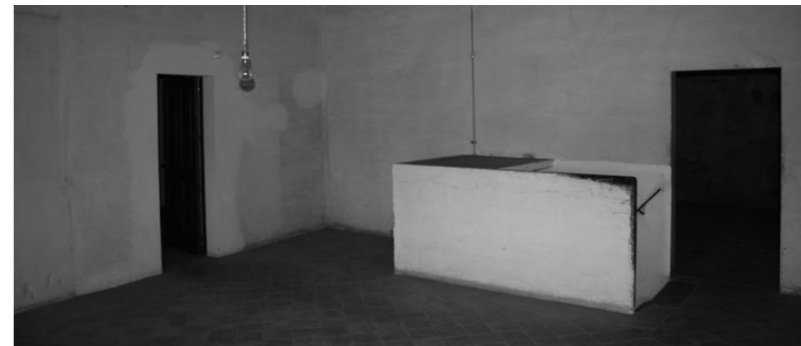
Figura 69. Salón en planta superior antes de la intervención [4].
