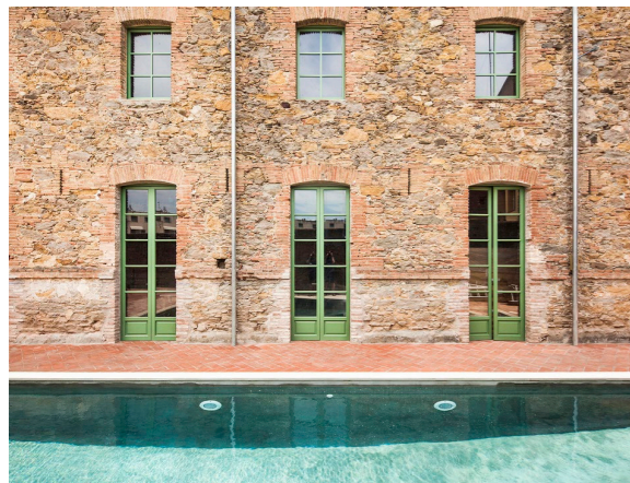
Figura 21. Fachada y patio después de la intervención.
