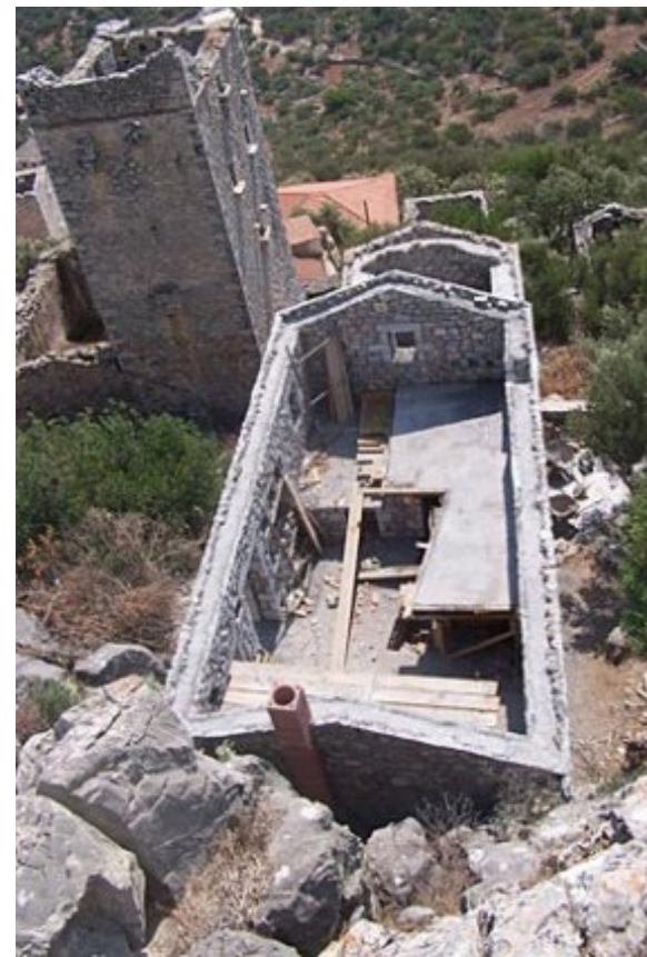
Figura 170. Construcción del nuevo volumen.
