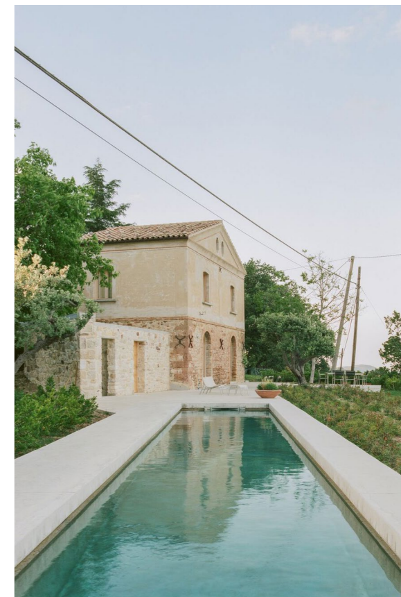
Figura 128. Fachada sur y jardín con piscina.
