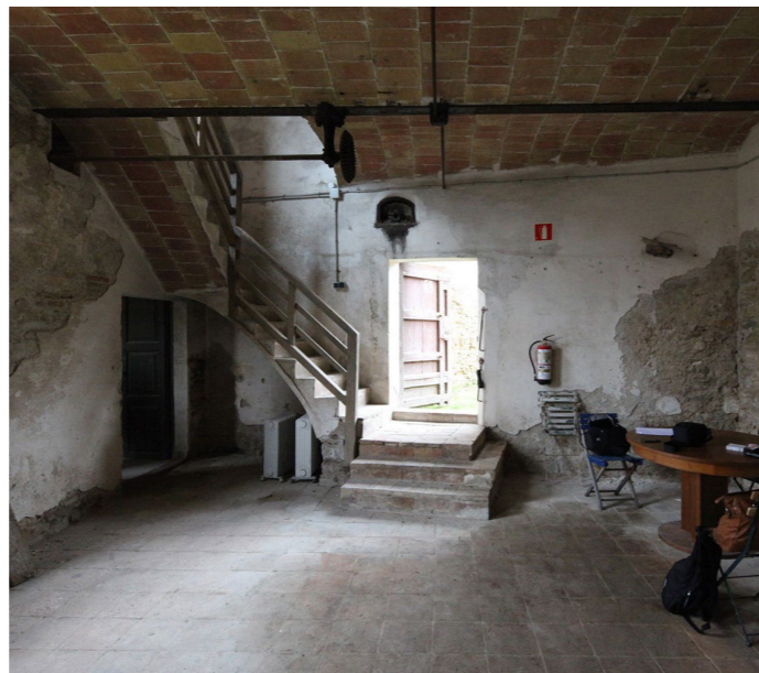
Figura 17. Entrada norte y escalera antes de la intervención.
