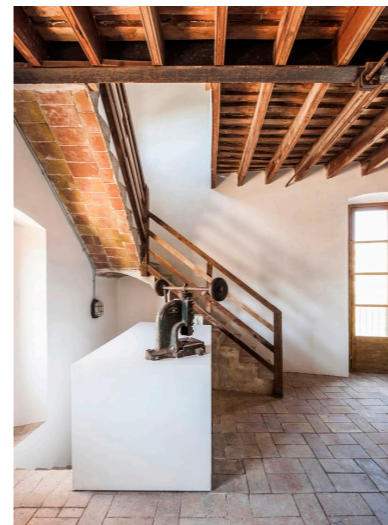
Figura 18. Escalera y forjado en planta primera.
