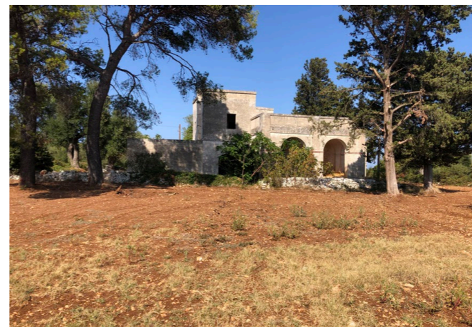
Figura 154. Exterior antes de la intervención.
