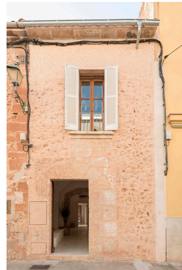
Figura 45. Fachada después de la intervención
