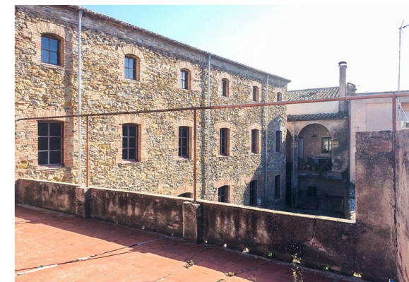
Figura 14. Estado de la fábrica antes de la intervención.
