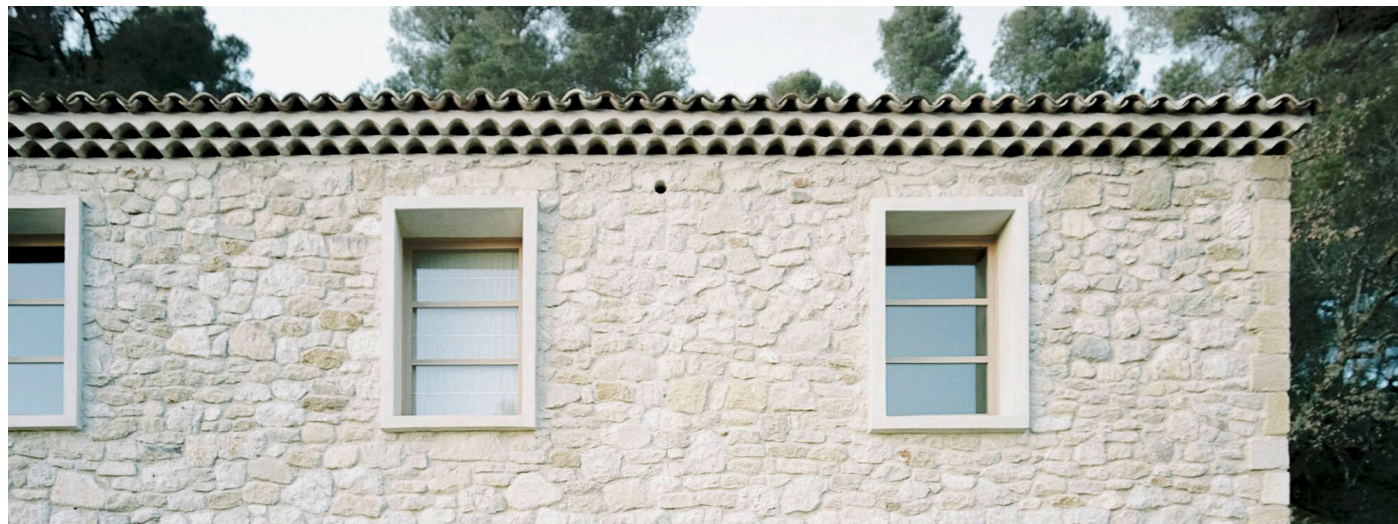
Figura 110. Cubierta Casa Ma.
