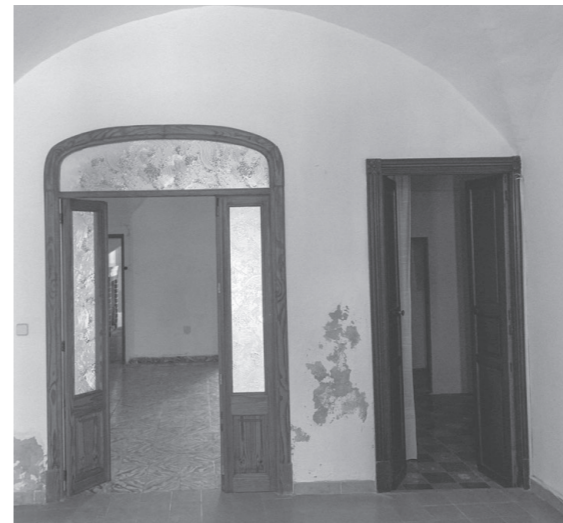
Figura 40. División entre vivienda y negocio antes de la intervención
