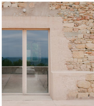
Figura 94. Antiguo muro de piedra.
