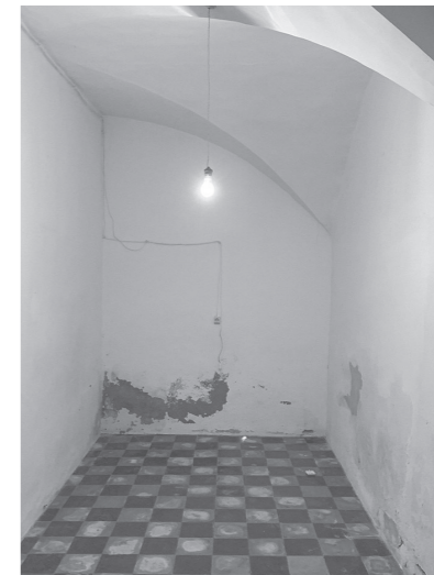
Figura 41. Antiguo almacenamiento bajo la escalera.
