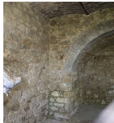
Figura 132. Bóveda de piedra en planta baja antes de la intervención.
