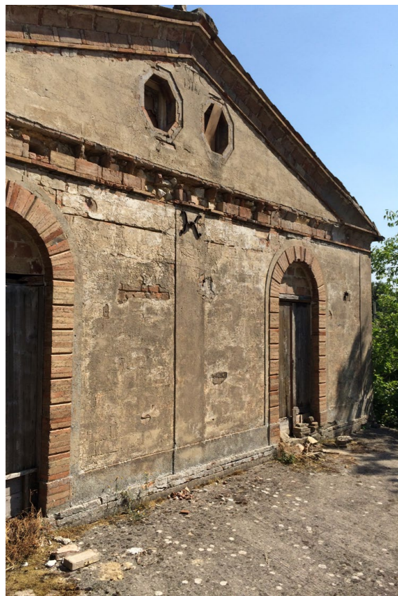
Figura 129. Apariencia exterior antes de la intervención.
