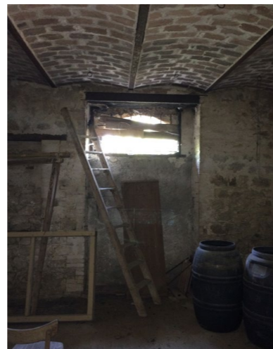
Figura 131. Imagen del forjado en planta baja.
