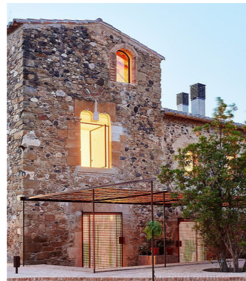
Figura 71. Fachada sur tras la intervención
