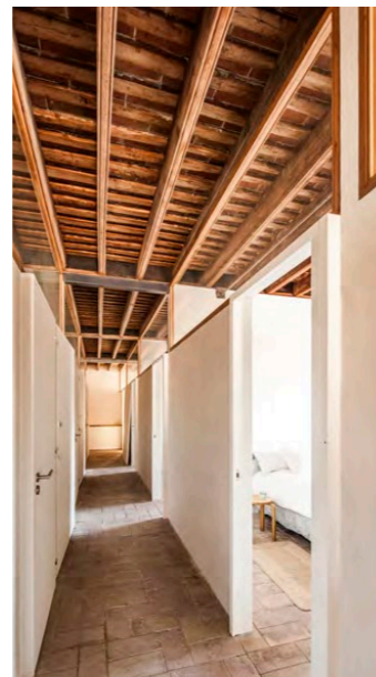
Figura 29. Pasillo planta primera.
