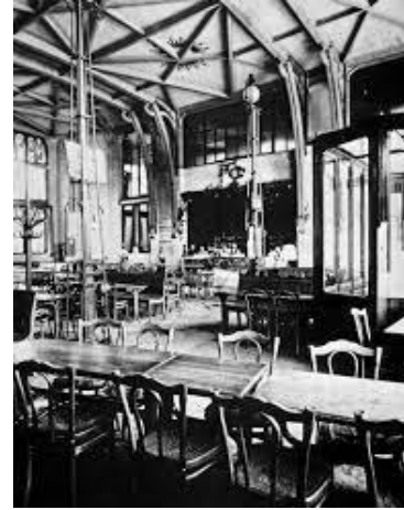
Imagen interior de la Casa Tassel (Imagen 51)
