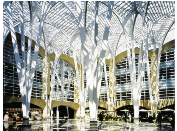
Imagen interior de la plaza "Heritage Toronto Square" del BCE Place (Imagen 70)
