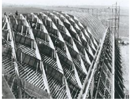
Imagen de la cubierta del hangar en construcción (Imagen 43)
