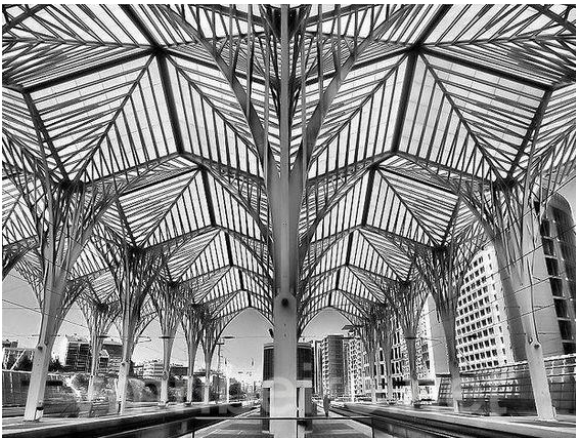
Imagen desde debajo de la cubierta (Imagen 68)
