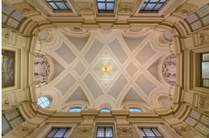
Imagen del techo de la capilla (Imagen 24)
