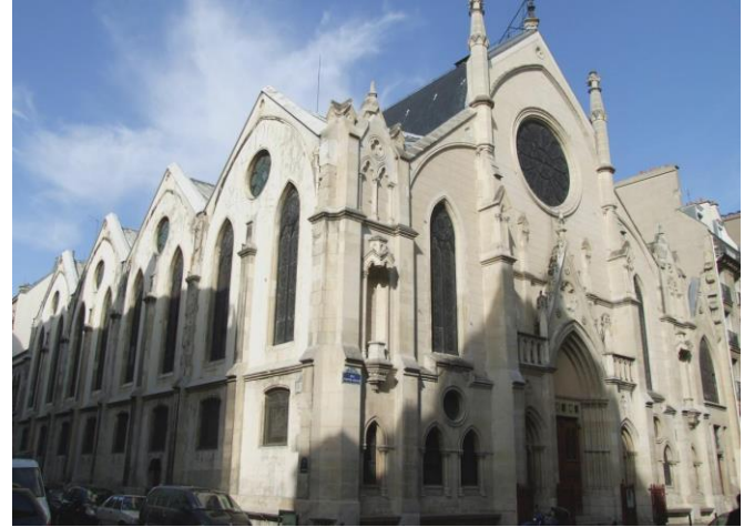
Imagen exterior del acceso principal (Imagen 33)
