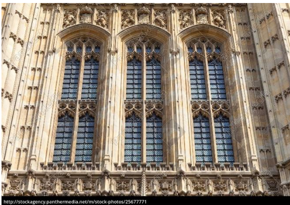
Detalle de las tracerías y de las vidrieras exteriores (Imagen 17)
