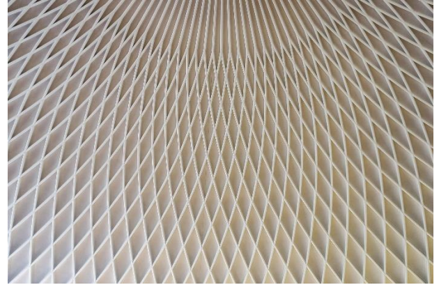
Detalle de los nervios de la cubierta (Imagen 47)
