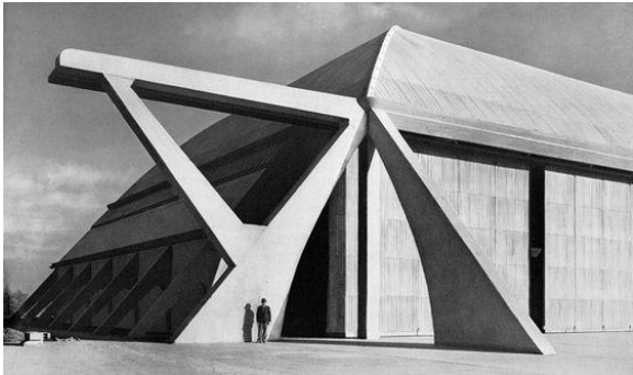
Imagen detalle de los contrafuertes exteriores (Imagen 42)
