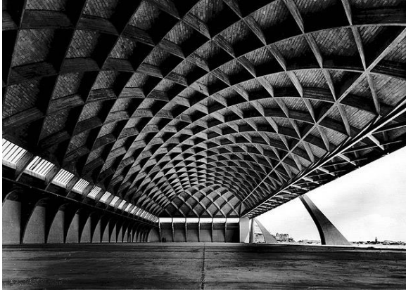
Imagen interior del hangar (Imagen 41)
