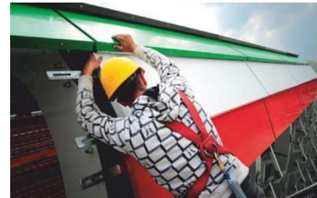
Figura 60. Montaje del revestimiento del Juventus Stadium.
