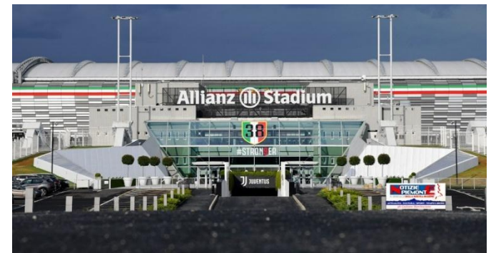
Figura 44. Vista del acceso al Juventus Stadium.
