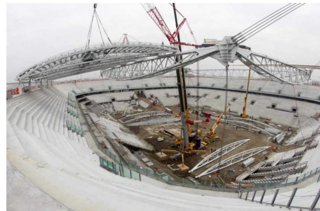
Figura 55. Proceso de construcción del Juventus Stadium.
