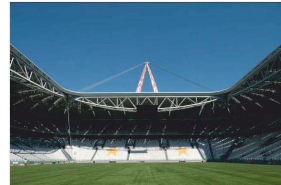
Figura 43. Vista interior del Juventus Stadium.
