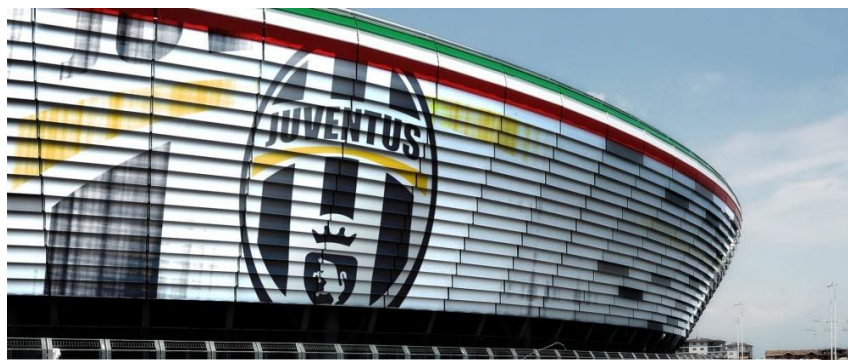
Figura 62. Revestimiento del Juventus Stadium.
