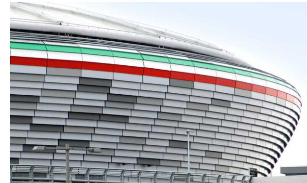
Figura 59. Revestimiento y cubierta del Juventus Stadium.
