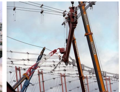
Figuras 24 y 25. Cables cincados formando un anillo alrededor del estadio.
