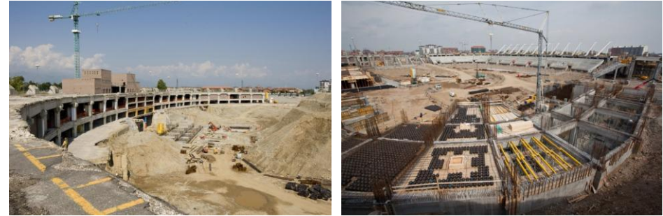
Figuras 51 y 52. Inicio del proceso de construcción del Juventus Stadium.
