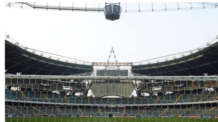
Figura 20. Sistema de audio suspendido sobre el terreno de juego.
