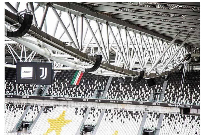
Figura 66. Una de las vigas principales del Juventus Stadium.
