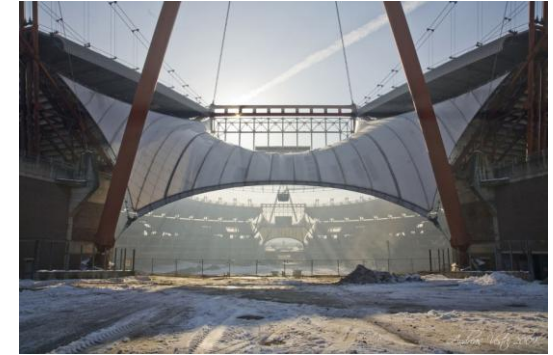
Figuras 26 y 27. Faja de tela de fibra de vidrio que protege del viento.
