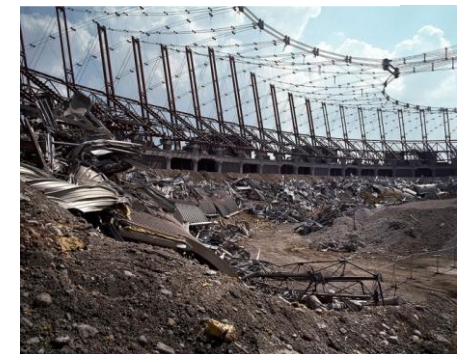
Figuras 34 y 35. Derribo de las gradas del Stadio Delle Alpi.
