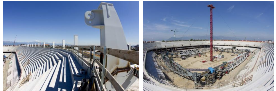
Figuras 53 y 54. Proceso de construcción del Juventus Stadium.
