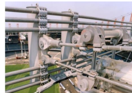
Figuras 24 y 25. Cables cincados formando un anillo alrededor del estadio.
