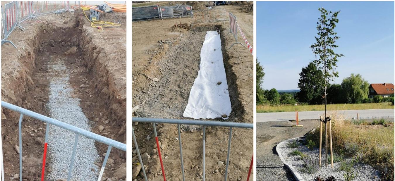
Fig. 59. Proceso constructivo de la Eco-Street. Fuente: Zenebio, 2024
