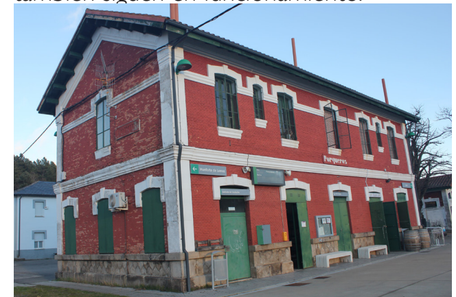
Fotografía 28: Estación de Ferrocarril de Porqueros |
