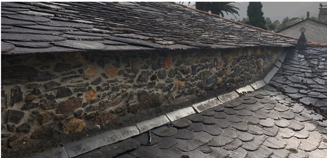
Fotografía 10: Cubierta de pizarra | Fuente: La autora
