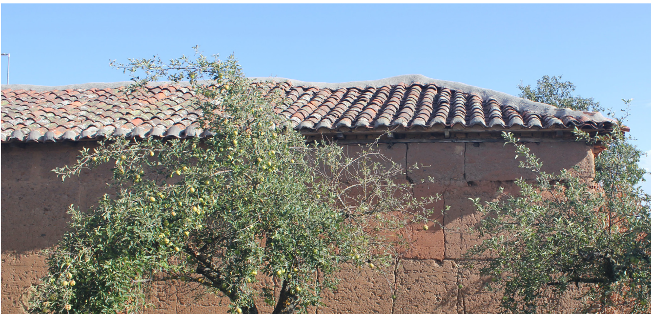
Fotografía 11: Cubierta de teja | Fuente: La autora
