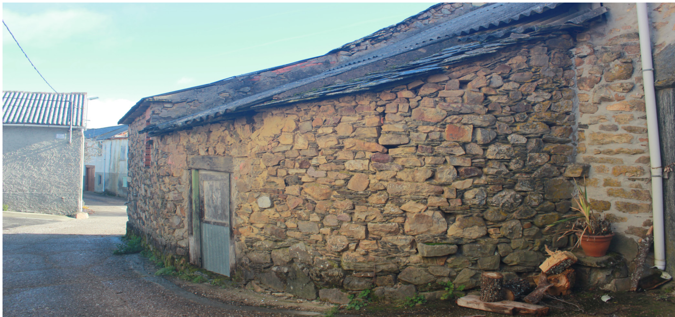
Fotografía 8: Fachada de piedra construida en seco | Fuente: La autora
