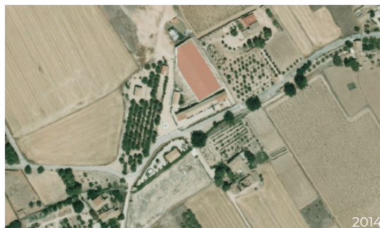
Imatge 46. Construcció d'una nova nau, part del nou restaurant instal·lat a l'antiga fàbrica.
