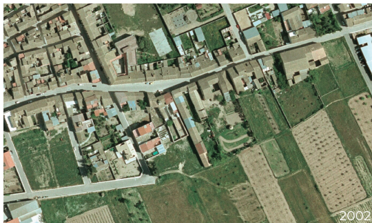
Imatge 51. Ja es poden veure dos zones amb la coberta substituïda i un enfonsament a la coberta de la bodega.
