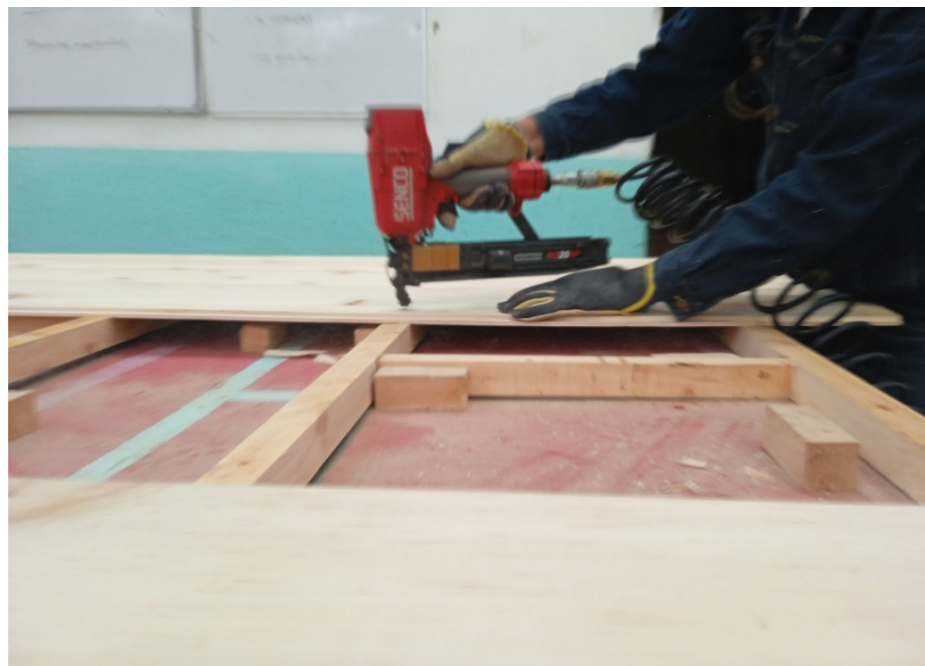
Fig. 26 Revestimiento con tablas tingladas. Elaboración propia.
