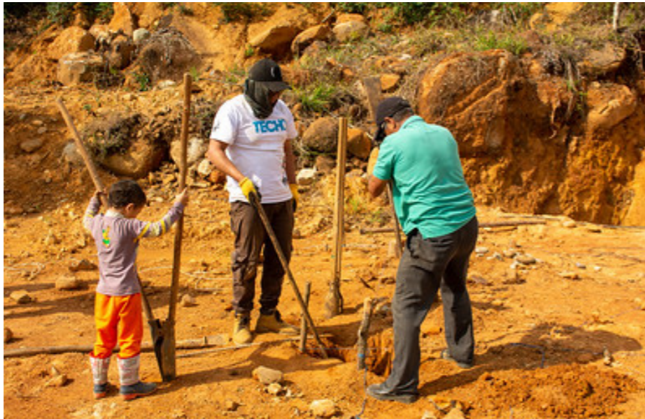
Fig. 30 Excavación de los huecos para los pilotes. Fuente TECHO.
