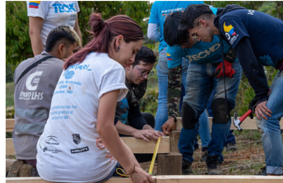
Fig. 33 Colocación de las vigas de piso. Fuente TECHO.
