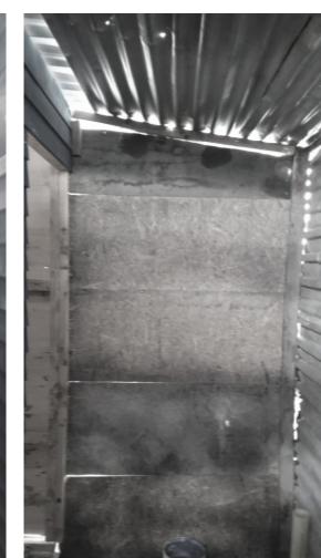
41 Aseo (sin terminar) Fuente. Elaboración propia
