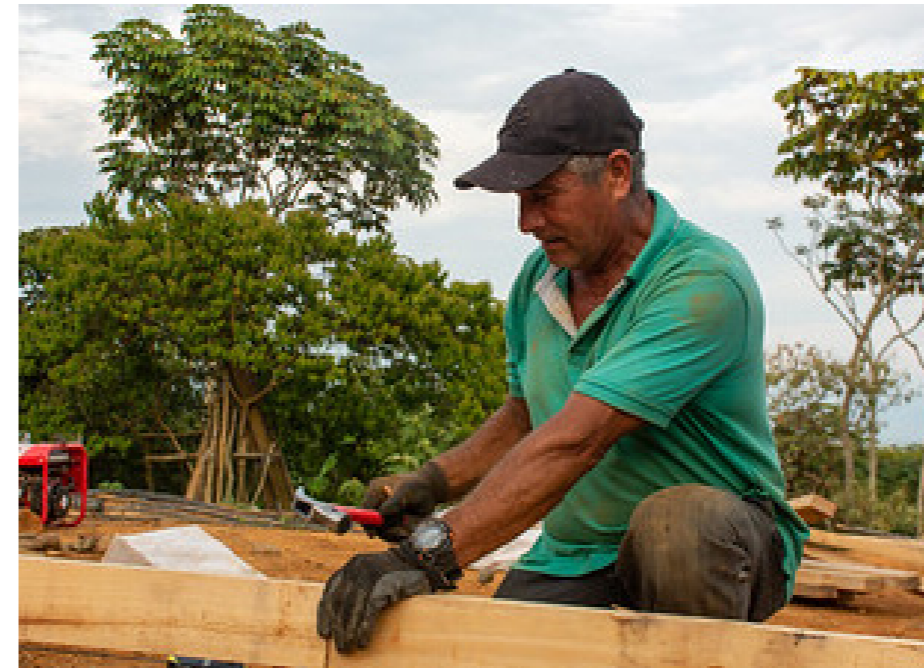
Fig. 34 Clavado con puntillas de las vigas de piso al pilote. Fuente TECHO.
