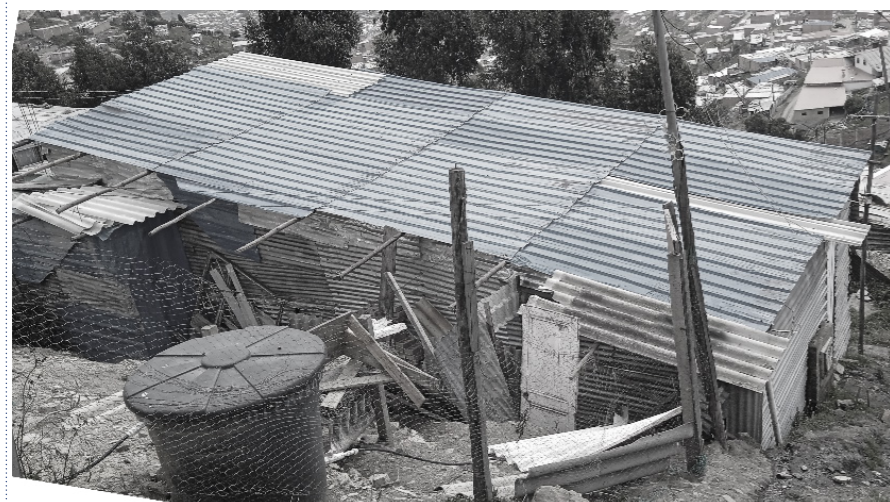
33 Vista exterior vivienda. Fuente. Elaboración propia
