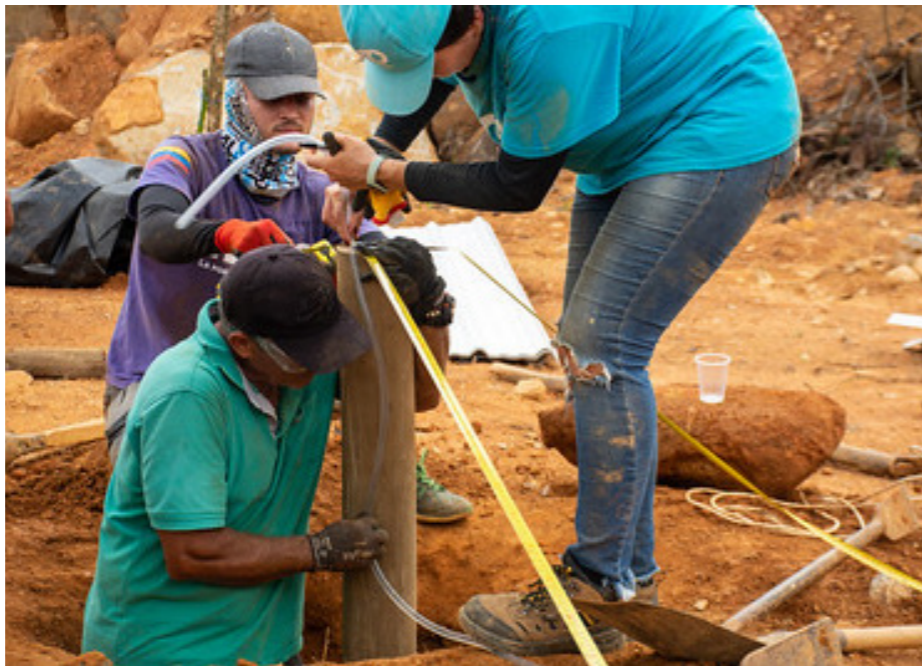
Fig. 32 Comprobación de las medidas con metro y nivel. Fuente TECHO.
