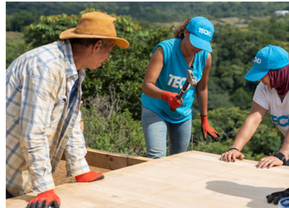
Fig. 35 Colocación y clavado de los paneles de piso. Fuente TECHO.
