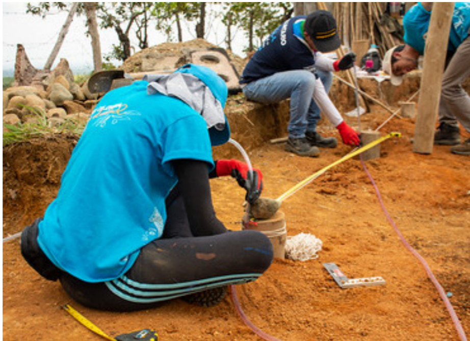
Fig. 31 Comprobación de las medidas con metro y nivel. Fuente TECHO.
