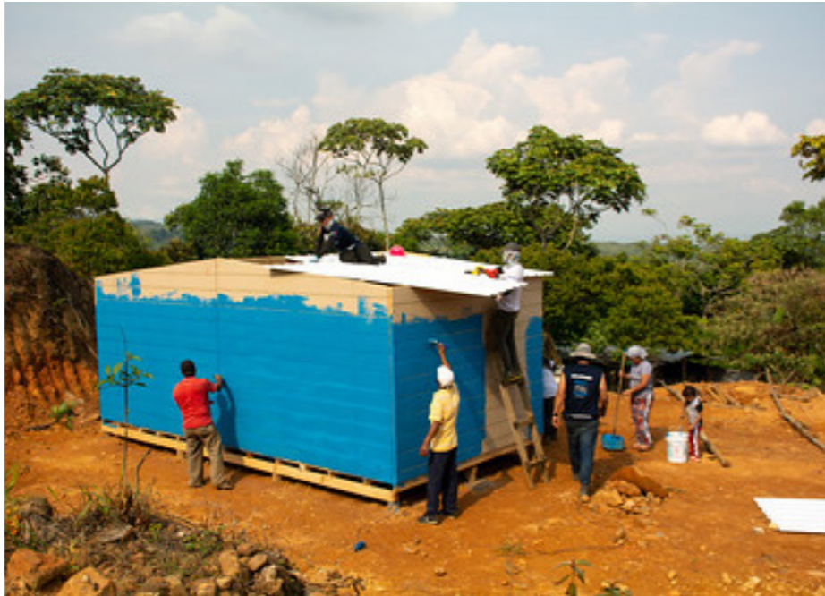
Fig. 37 Colocación de las tejas de zinc. Fuente TECHO.
