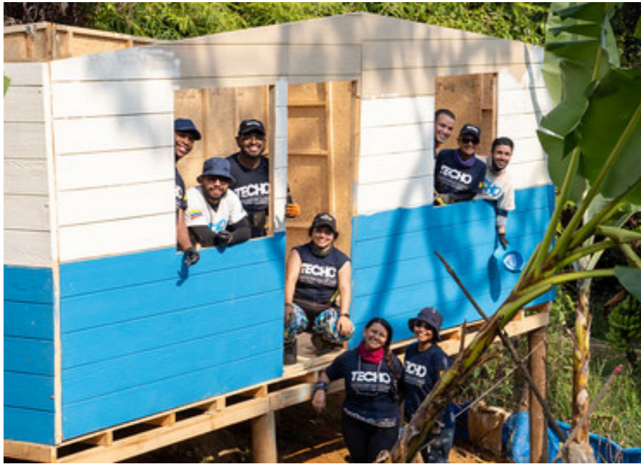
Fig. 36 Colocación de los paneles laterales. Fuente TECHO.
