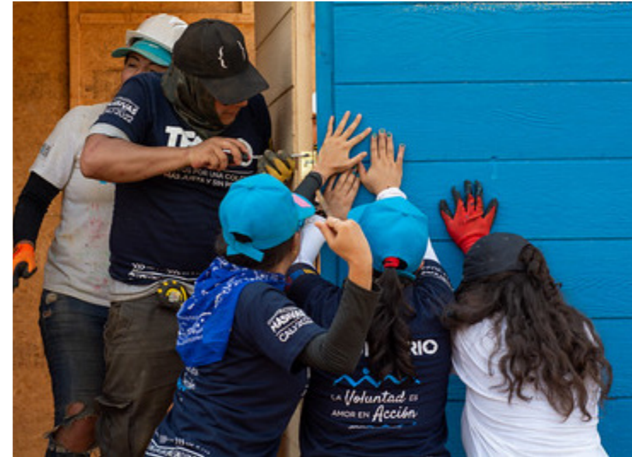
Fig. 40 Instalación de la ventana. Fuente TECHO.
