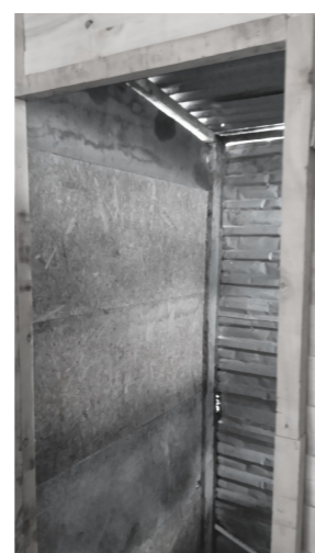
39 Huevo realizado en el testero para conectar con el aseo. Fuente. Elaboración propia
