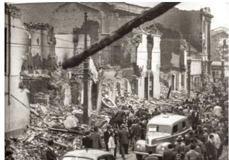
Fig. 8 Destrucción en Bogotá
