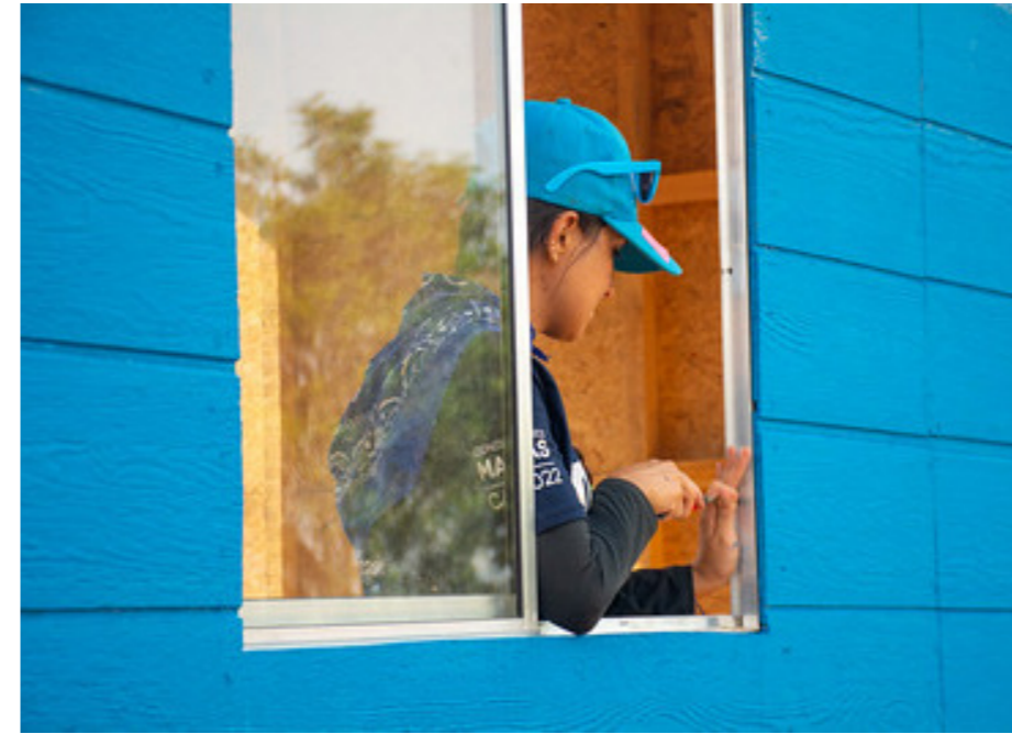
Fig. 39 Instalación de la ventana. Fuente TECHO.
