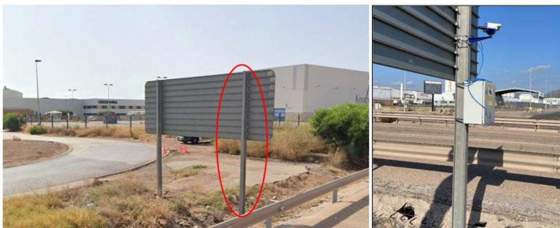
**Ilustración 28: Punto de instalación cámara lectura de matrículas. Fuente: CPS**
