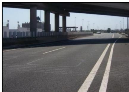
Ilustración 4. Detector electromagnético con lazo inductivo. Fuente: Internet.
