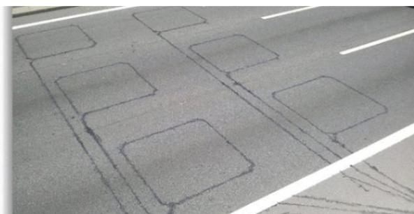
**Ilustración 8: Ejemplo instalación configuración lazo inductivo doble. Fuente: Internet.**
