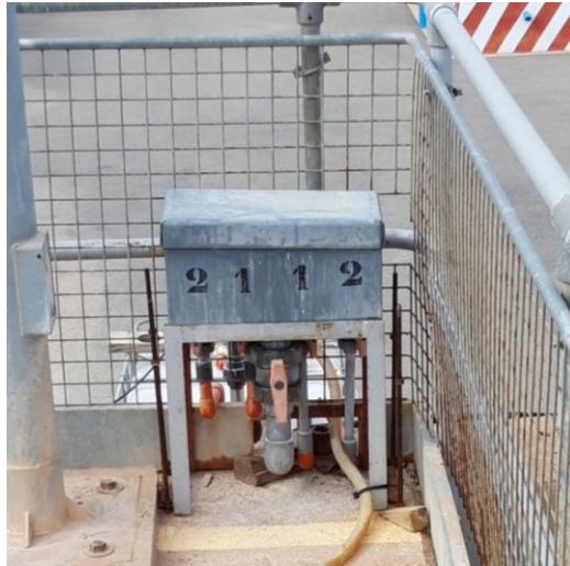
Figura 15. Cubeto de repartición. (Fuente: Propia.)
