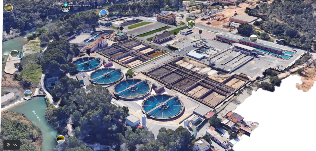
Figura 3. ETAP la presa.
