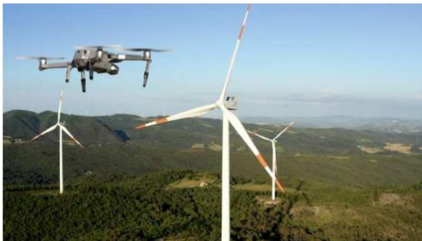
Ilustración 19. Inspección visual realizada por drones. Fuente: Dimitrova et al. (2020).
