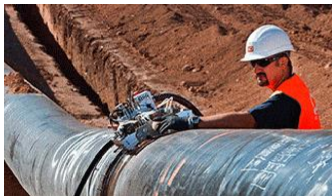
Ilustración 10. Técnica de inspección con ultrasonido. Fuente: SCI (2024).
