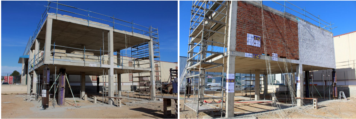
Figura 2: Ensayos llevados a cabo en edificios con estructura de hormigón ejecutada in situ, con y sin tabiques de fachada.
