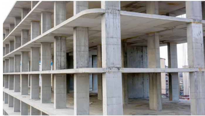
Figura 1. Construcció de formigó.
