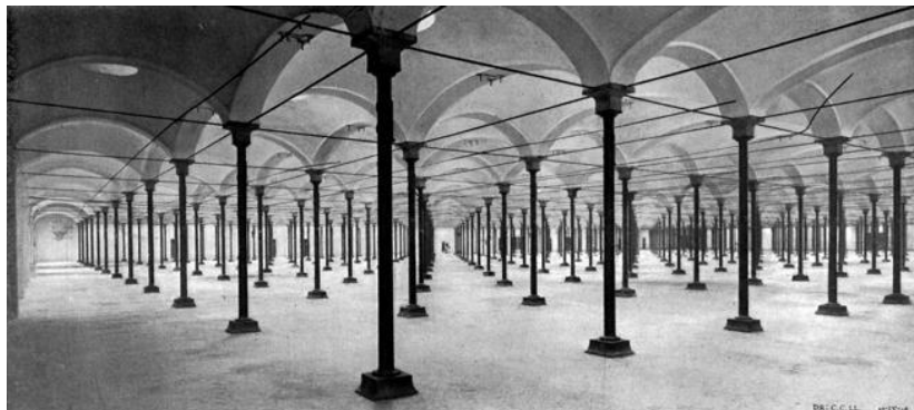
Figura 2. Vista interior de la sala de telers en la Fàbrica Batlló (Barcelona).
