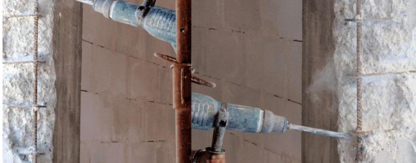
Figura 40. Reparació d'estructura de formigó armat.
