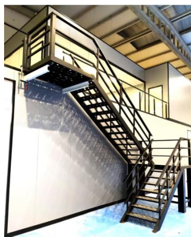
Figura 57. Exemple d'escalera metàl·lica prefabricada.
