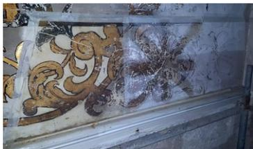
Fig. 102. Proceso de encolado: aplicación de la gasa de algodón.
