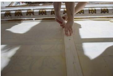
Fig. 122. Fragmentación del mural; corte con cúter. Fuente: M<sup>a</sup> Pilar Soriano Sancho.
