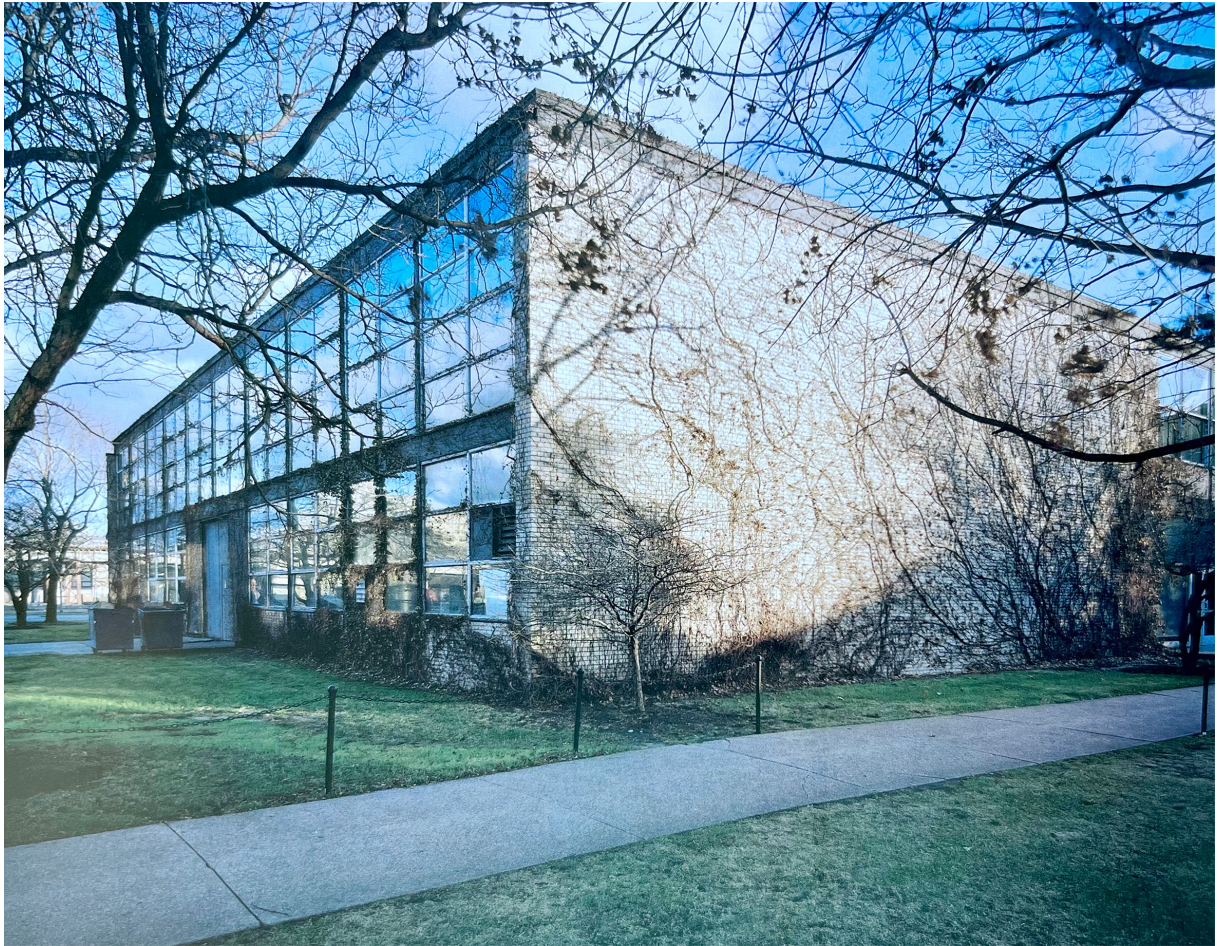
Figura 8b: Vista del exterior del Perlstein Hall. Mies in América (2001)
