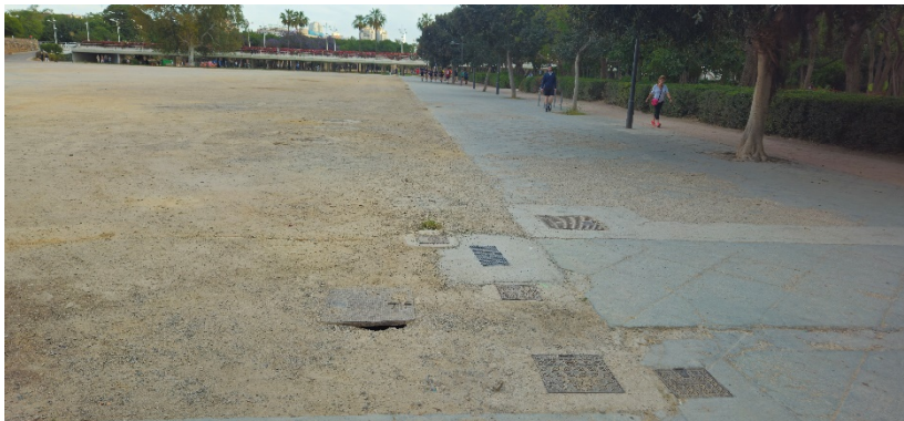
Fotografía 5. Ubicación del muro sur del depósito.
