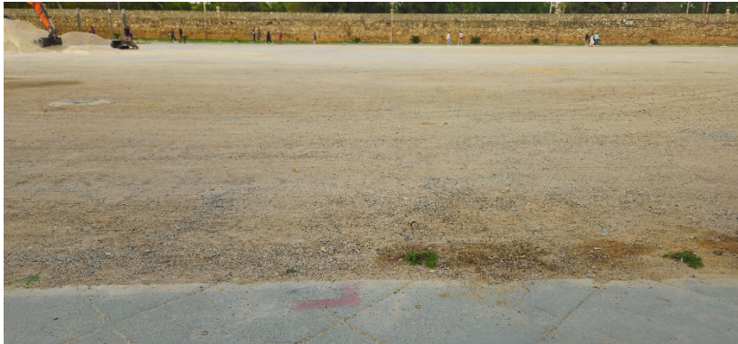
Fotografía 7. Ubicación del muro interior. Vistas al norte.
