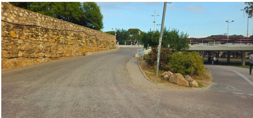
Fotografía 11. Rampa de acceso a la parcela.
