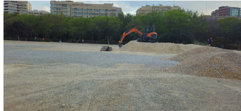
Fotografía 2. Estado actual de la parcela. Vistas al sur.
