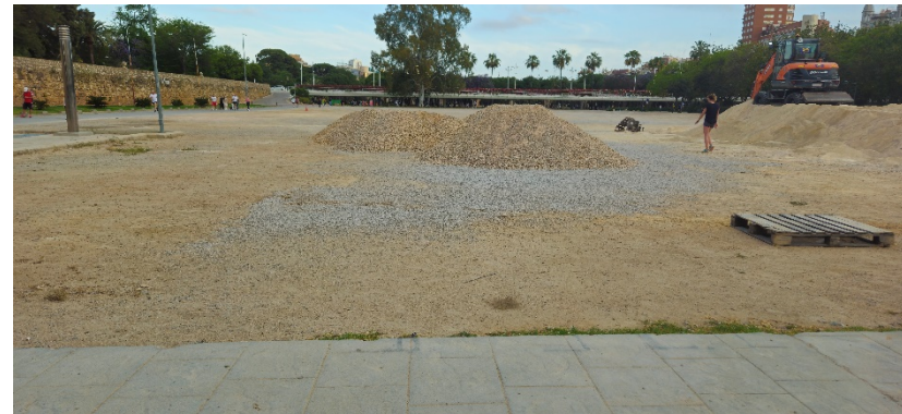
Fotografía 6. Ubicación del muro norte del depósito
