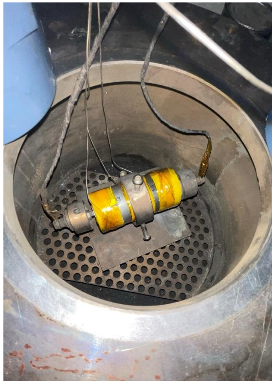
Ilustración 10. Celda preparada en el interior del canister
