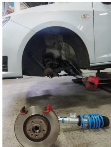
Imagen 119- Amortiguador y muelle delantero izquierdo. [Fuente propia]
