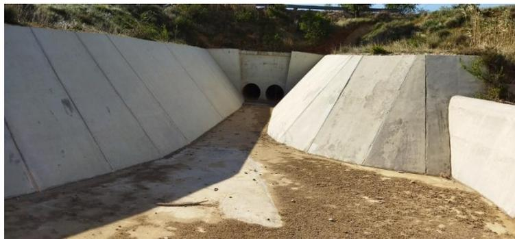
Figura 62.- Vista de dos conductos paralelos de salida del aliviadero al barranco. Fuente: visita realizada.
