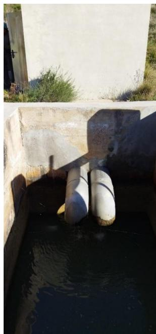
Figura 66.- Zafareche rotura de carga. Fuente: visita realizada.
