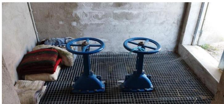
Figura 17.- Válvulas de regulación en la caseta de válvulas a pie de presa. Fuente: visita realizada a la presa.
