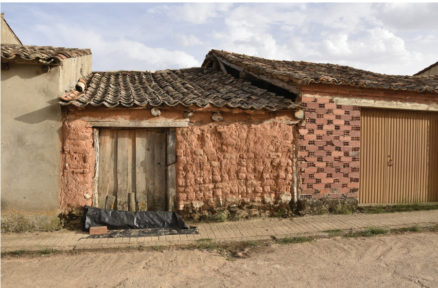
Figura 27: Anexo en adobes en Valdenebro (Soria), junio 2022.
