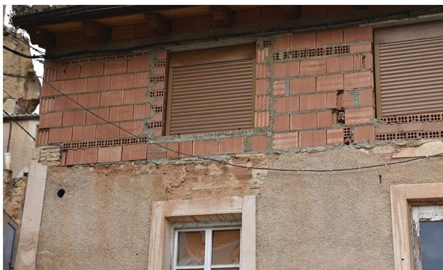
Figura 55: Sustitución de los adobes con ladrillos huecos en un edificio en Daroca (Zaragoza), abril 2023.
