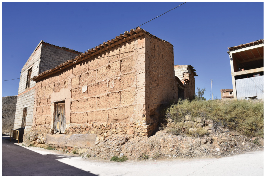
Figura 34: Anexo construido con tapia suplementada en juntas en Chodes (Zaragoza), octubre 2021.
