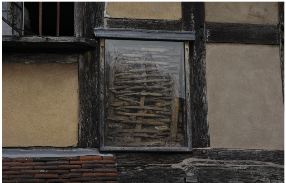
Figura 8: Ventana arqueológica del entramado con relleno de encastado (técnica comúnmente denominada wattle and daub en inglés) en Stratford Upon Avon, en la casa natal del poeta Shakespeare. Octubre 2022).
