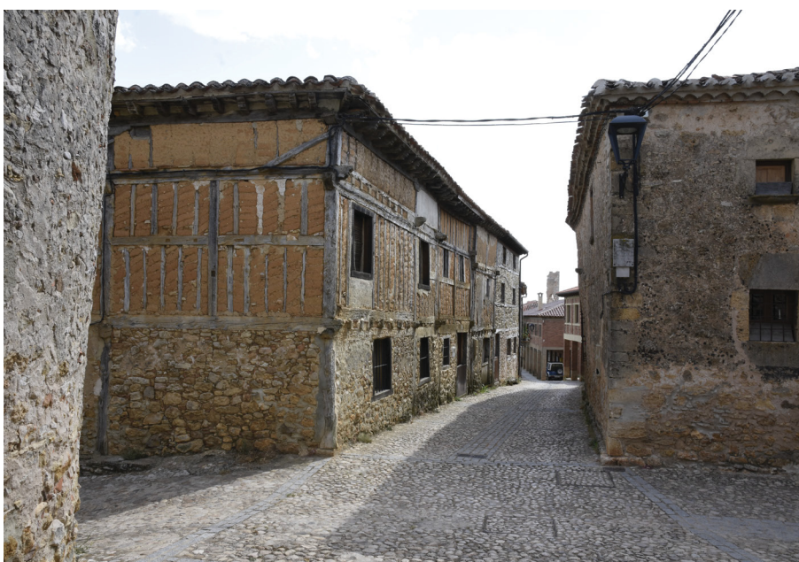
Figura 37: Edificio con entramados de adobes (inclinados en el primer nivel, apilados en el desván) en Catalañazor (Soria), junio 2022.
