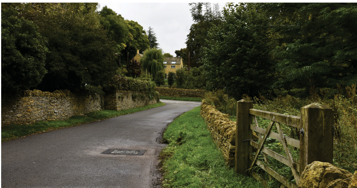
Figura 168: Muros contruidos con la técnica de la piedra seca en Upper Slaughter (Glouchestershire). Este elemento constructivos es característico del área y se utiliza también para delimitar los pastos. Incluso se ofrecen algunos cursos para formarse en esta técnica constructiva. Octubre 2022.
