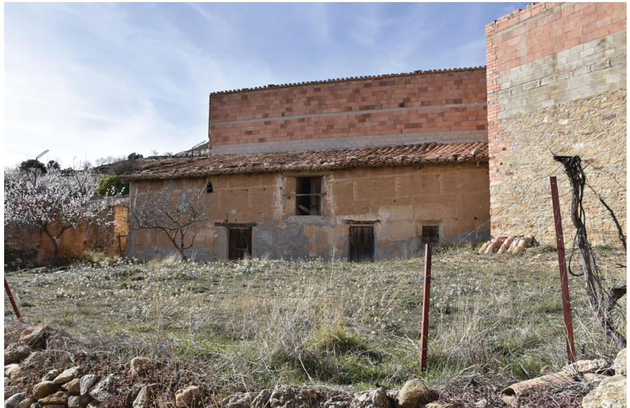
Figura 33: Edificio anexo (posiblemente establos y almacenes) de tapia con juntas calicostradas, en Olocau del Rey (Castellón), marzo 2023.
