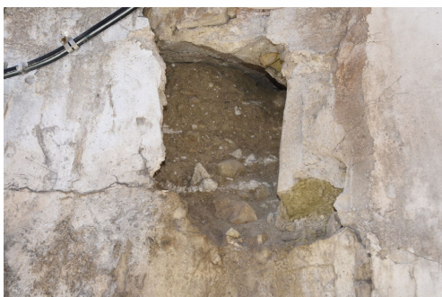
Detalle de un muro de tapia calicotradas. Marzo 2021
