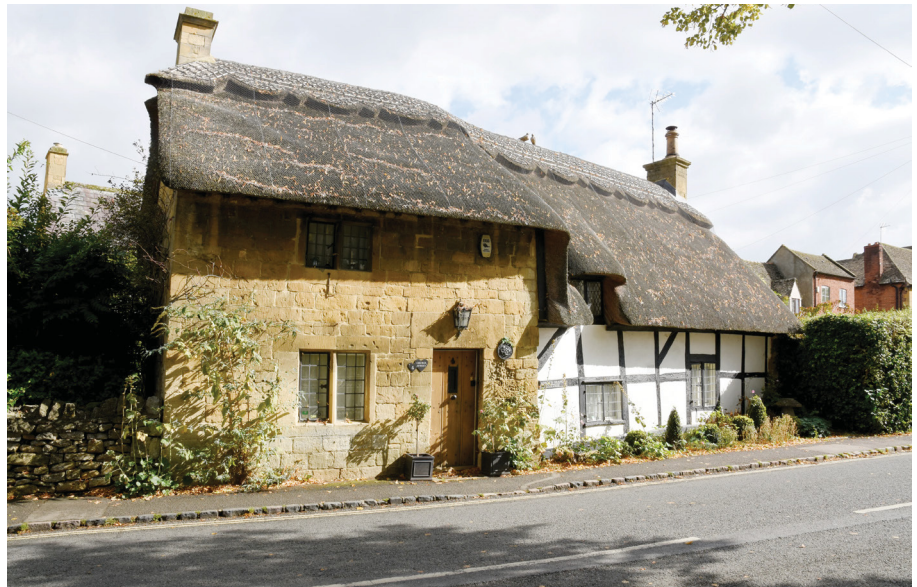
Figura 170: Viviendas tradicionales de piedra, entramado de madera y cubierta vegetal ( thatched roof ) en Broadway, Gloucestershire, octubre 2022.
