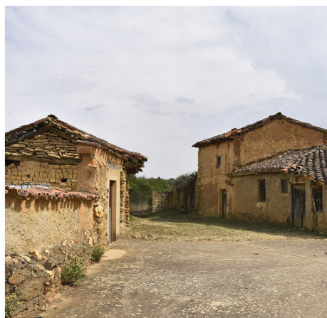
Figura 2: Técnicas constructivas tradicionales de tierra en España en diversas localidades. De izquierda a derecha: adobes y tapia en Chodes (Aragón, octubre 2021); Tepes, adobes y tapia en Molezuelas de la Carballada y muro de entramado de adobes en Boós (Castilla y León, junio 2022).
