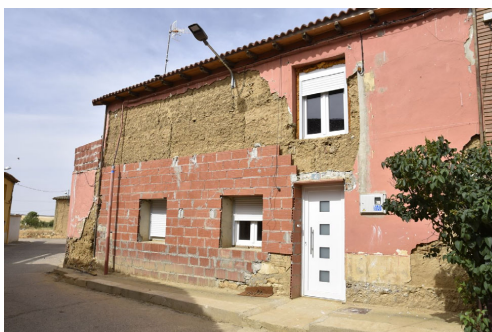
Intervención se sobre-posición de fachada en curso de desmontaje. Junio 2022
