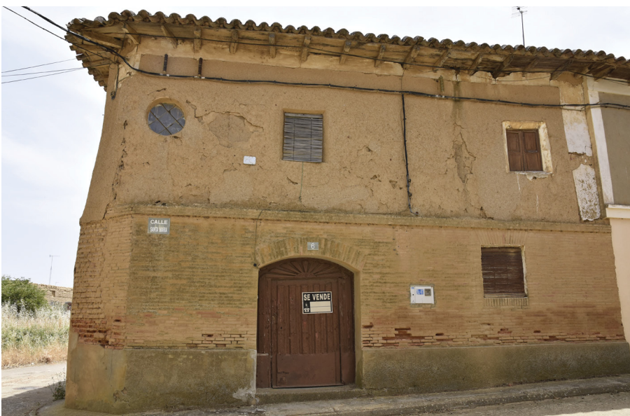
Figura 31: Vivienda de tapia simple con trullado y planta baja en ladrillos en Cuenca de Campos (Valladolid), junio 2022.
