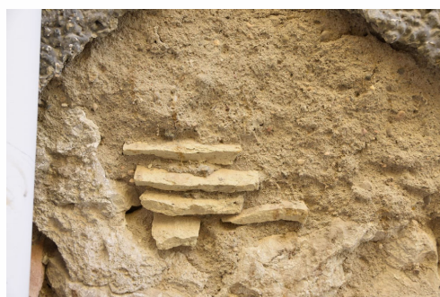
Detalle de un muro de tapia simple con refuerzos puntuales de tejas. Marzo 2021.
