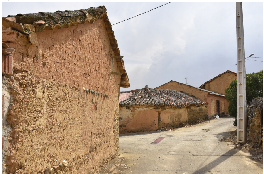
Figura 40: Edificios realizados con diversas técnicas tradicionales (de tierra y no) en Molezuelas de la Carballeda (Zamora). En el primer plano, un edificio de tapia simple y adobes, en segundo plano se observa además el uso conjunto de piedra y madera, además que de adobes y tapia. Junio 2022.
