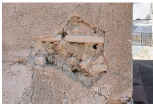
Detalle de un muro de tapia careada con ladrillos. Marzo 2021
