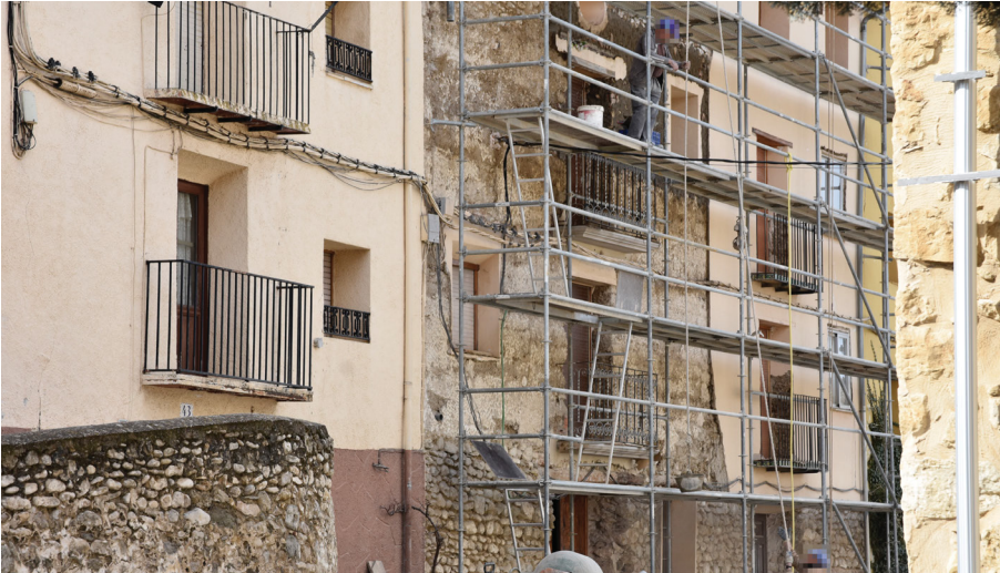
Figura 51: Realización de revestimiento con cemento en un edificio de tapia en la provincia de Castellón, marzo 2023.
