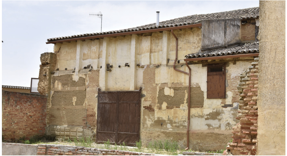
Figura 32: Tapia simple encadenada con machones y verdugadas de ladrillo en uno de los edificios del convento de San Bernardino, Cuenca de Campos (Valladolid), junio 2022.
