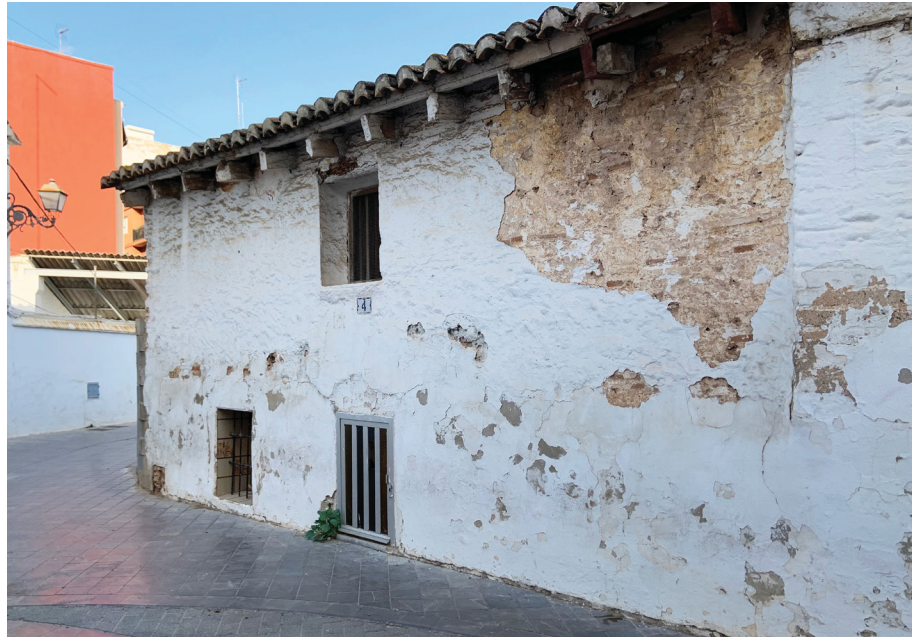
Figura 66: Alquería en el barrio de Campanar (Valencia) construida con tapia careada de ladrillos. Abril 2021.
