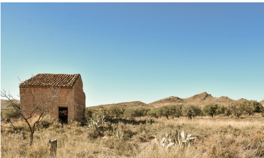
Figura 61: Efectos de la despoblación en edificios de tierra en Chodes (Zaragoza). Aunque el conjunto sigue habitado, las cifras de población son muy bajas y un número elevado de edificios se encuentra sin uso, experimentando fenómenos de abandono y degradación considerables, especialmente en las arquitecturas vinculadas con la actividad agrícola. Octubre 2022.
