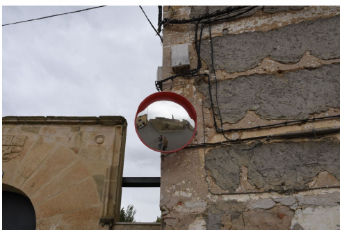
Resarcido de revestimiento de un muro de tapia con breccas mediante cemento. Abril 2023
