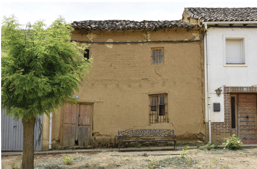
Figura 36: Edificio en adobes, revestido con trullado en Villafrades de Campos (Valladolid), junio 2022.
