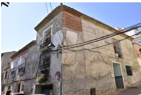
Edificio de tapia en el cual se ha intervenido con materiales industriales. Marzo 2021
