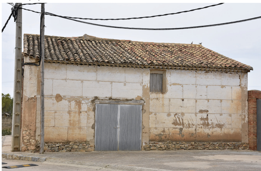
Figura 46: Edificio de tapia calicostrada suplementada en las juntas en Villarquemado (Teruel). A pesar de no haber sufrido intervenciones importantes, aparte la sustitución de la carpintería de la puerta, el edificio se encuentra en un buen estado de conservación, ya que no presenta grandes daños materiales ni estructurales. Abril 2023.
