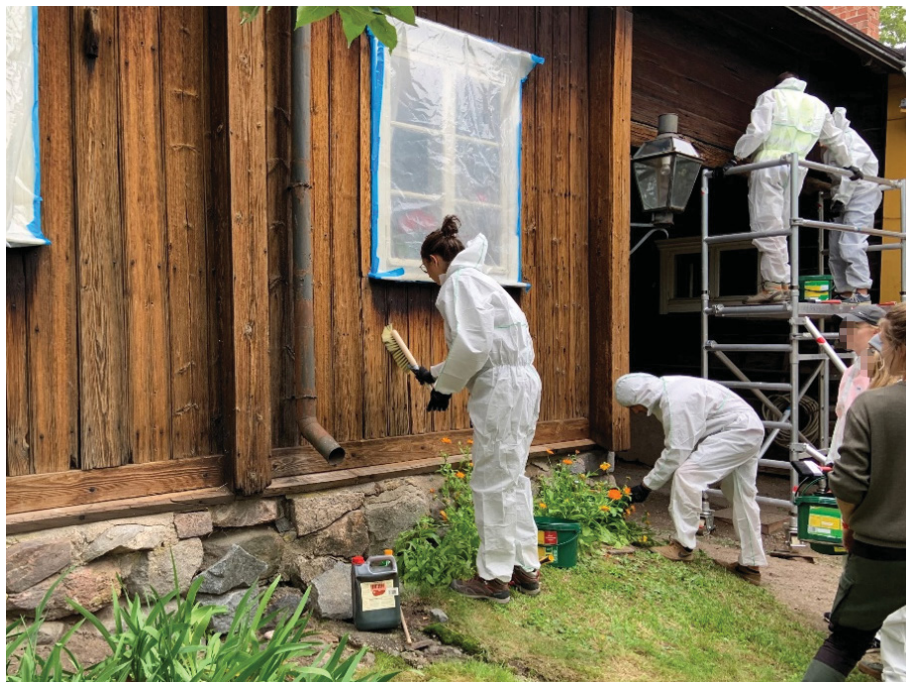
Figura 178: Voluntarios del proyecto World Heritage Volunteers Initiative pintando la fachada de la casa museo con pintura tradicional a base de alquitrán. Rauma, agosto 2019.
