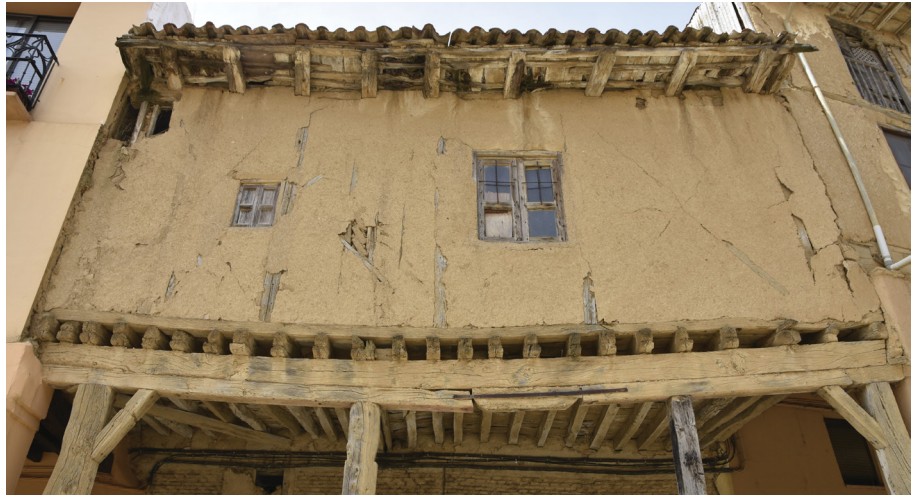
Figura 38: Entramado con adobes en espiga y trullado en un soportal de Villalón de Campos (Valladolid), junio 2022.
