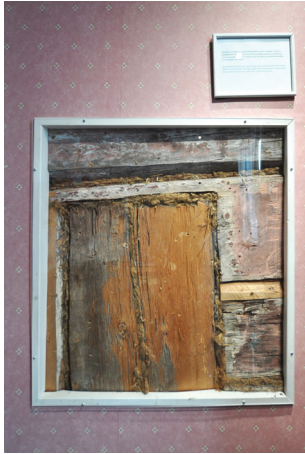
Figura 176: Ventana arqueológica en una de las salas de Tammela, que permite comprender la estructura del muro y el aprovechamiento de los elementos de madera en su construcción. Rauma, septiembre 2019.
