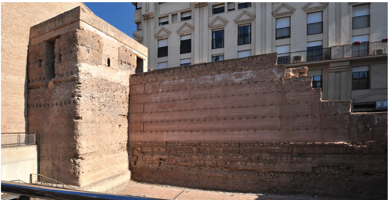
Figura 71: Tapia intervenida en la muralla islámica de Murcia, en el tramo del antiguo convento de las verónicas. Marzo 2019.
