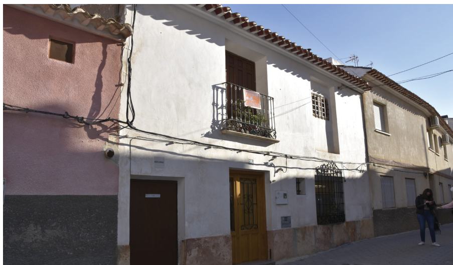
Figura 50: Vivienda en Mula (Murcia) cuyo nuevo revestimiento se ha realizado con materiales tradicionales. Marzo 2021.
