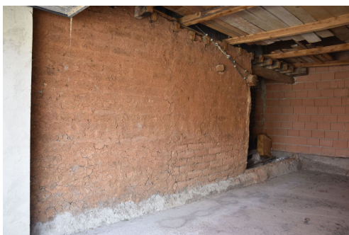
Tabique de adobes que se ha conservado en el interior de uno de los edificios del pueblo. Junio 2022
