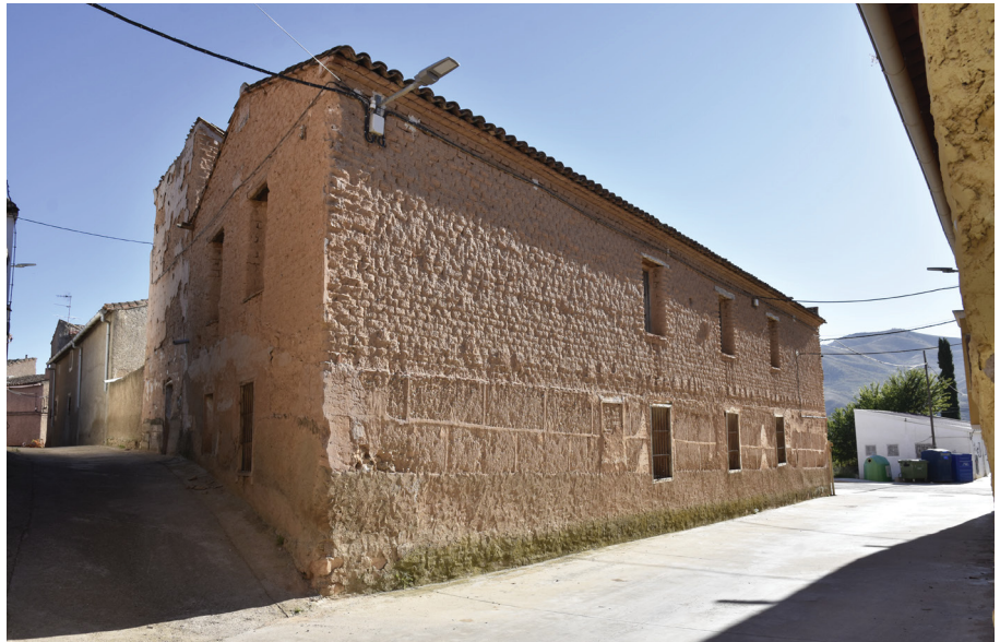
Figura 39: Edificio en Chodes (Zaragoza), con la planta baja de tapia suplementada en las juntas y las plantas superiores en adobes. Octubre 2021
