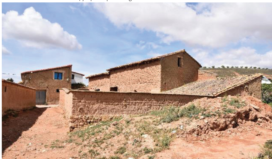
Figura 47: Conjunto de construcciones realizadas con adobes en Torralba de Ribota (Zaragoza). Aunque se aprecia cierta erosión superficial debido sobre todo a la falta de protección y mantenimiento, el estado global de la arquitectura es bastante bueno. Abril 2023.
