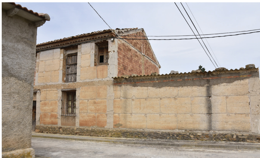
Figura 56: Sustitución del muro de tapia con un muro de ladrillos en la pared lateral de una vivienda en Villarquemado (Teruel), abril 2023.
