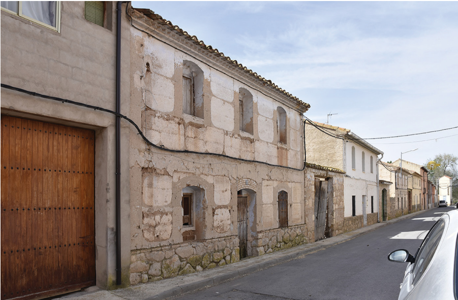
Figura 26: Vivienda de tapiá en Villarquemado (Teruel), abril 2023.
