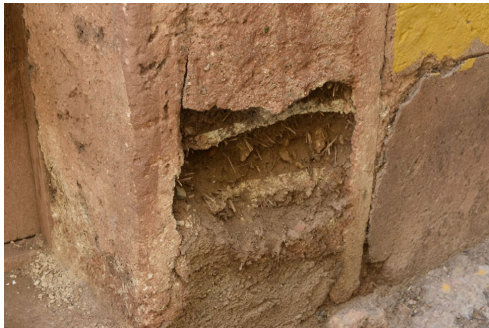
Sección del muro donde se aprecia la presencia de tapia calicotrada. Abril 2023
