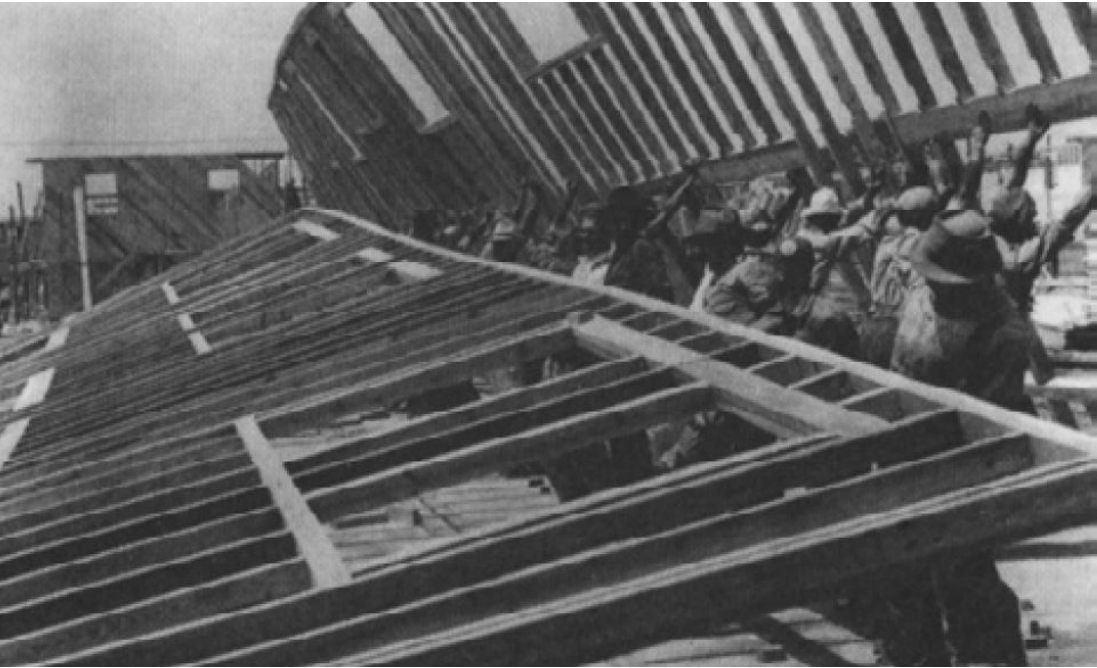
Figura 5. ▲ Montaje Balloon Frame, EEUU
