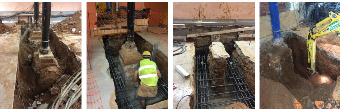
Figura 38. Fotografías de zapatas bajo pilares de fundición de un edificio del Ensanche de Barcelona ▼
