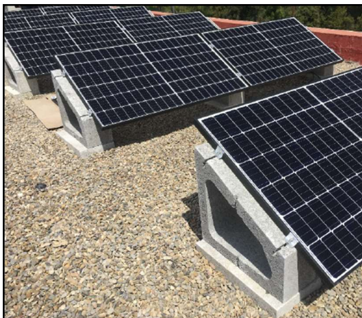
Figura 2. Modelo tipo de la instalación. Fuente: Solarbloc.
