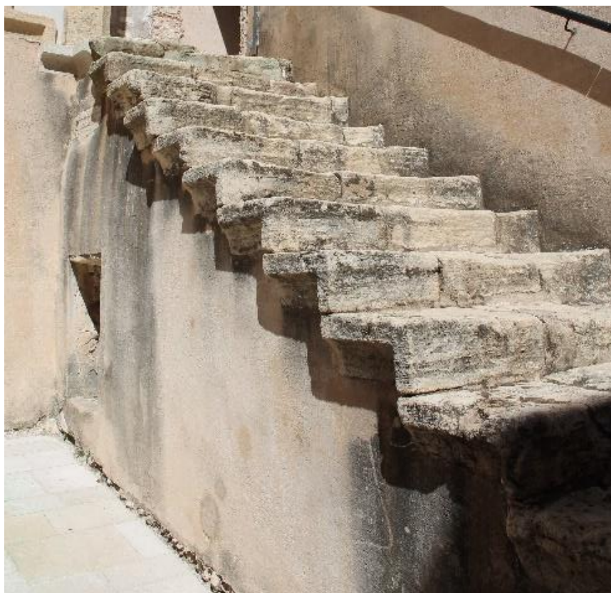
Ilustración 20: Escalera de acceso a la planta noble. Autoría propia (2024) 24
