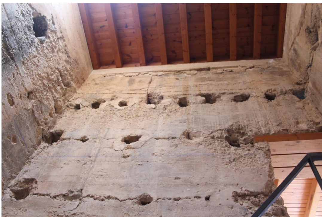
Ilustración 23: Fotografía de los muros de la torre norte junto al acceso a la cubierta. Muro de tapia donde se pueden apreciar los agujeros del retirado de las agujas en el proceso de ejecución de una tapia mediante método tradicional. Autoría propia (2024) 28
