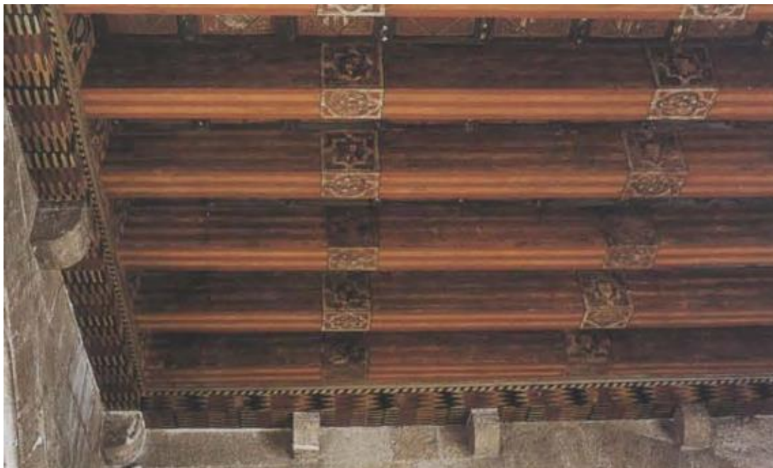
Ilustración 64: Fotografía del alfarje del Palacio del Almirante, donde se aprecia como las vigas apoyan sobre las ménsulas de piedra 62
