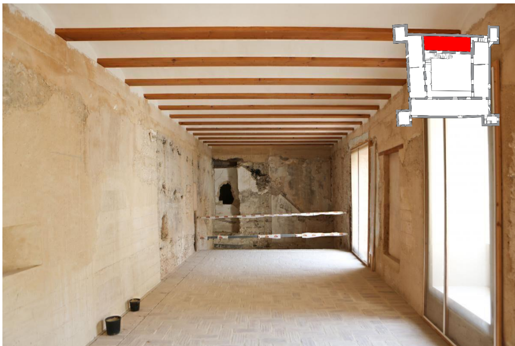
Ilustración 50: Fotografía del estado actual de la sala derecha de la planta noble en el ala este
