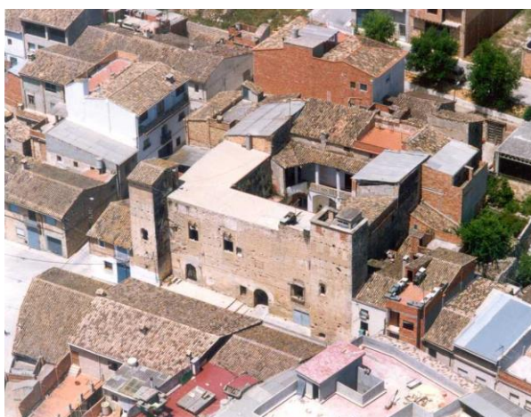
Ilustración 14: Fotografía aérea desde torre sureste donde se ven las viviendas anexas al cuerpo principal del castillo. Fotografía previa a las intervenciones de restauración 12
