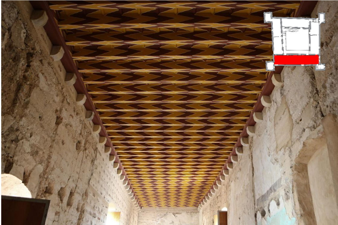
Ilustración 45: Estado actual de la sala del ala oeste de la planta noble, con el alfarje policromado restaurado y los muros pendientes de restaurar
