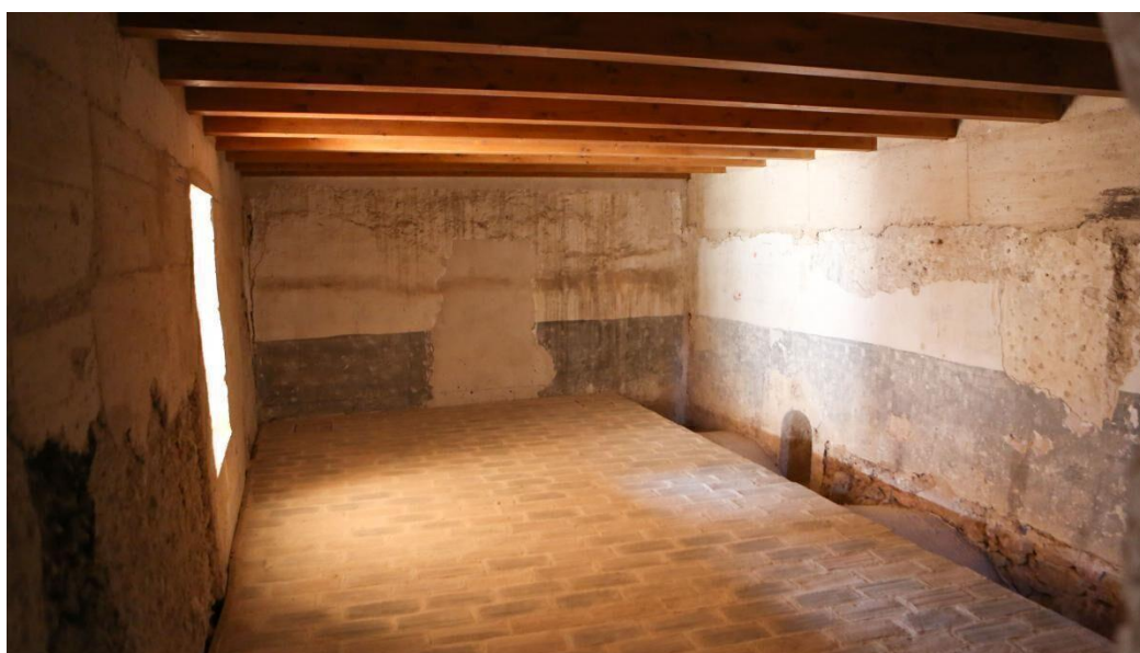
Ilustración 52: Sala con forjado visto en la segunda planta
