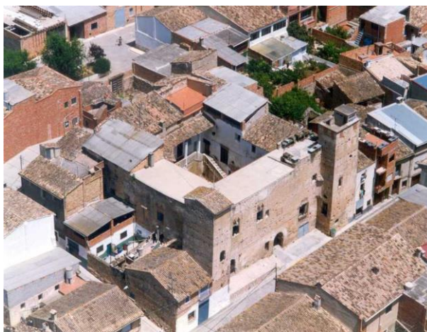
Ilustración 13: Fotografía aérea desde torre suroeste donde se ven las viviendas anexas al cuerpo principal del castillo. Fotografía previa a las intervenciones de restauración
