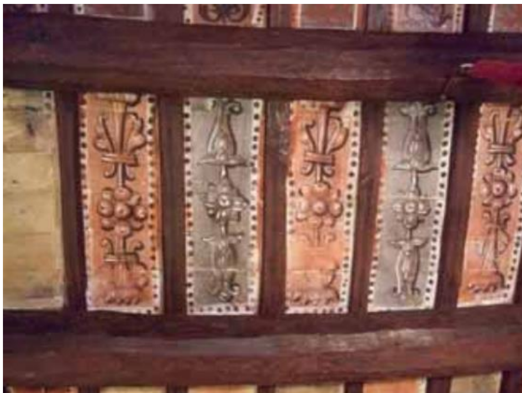
Ilustración 34: Techo de vigas, alfargías y ladrillos por tabla pintados al temple. Monasterio de la Encarnación. Osuna 46
