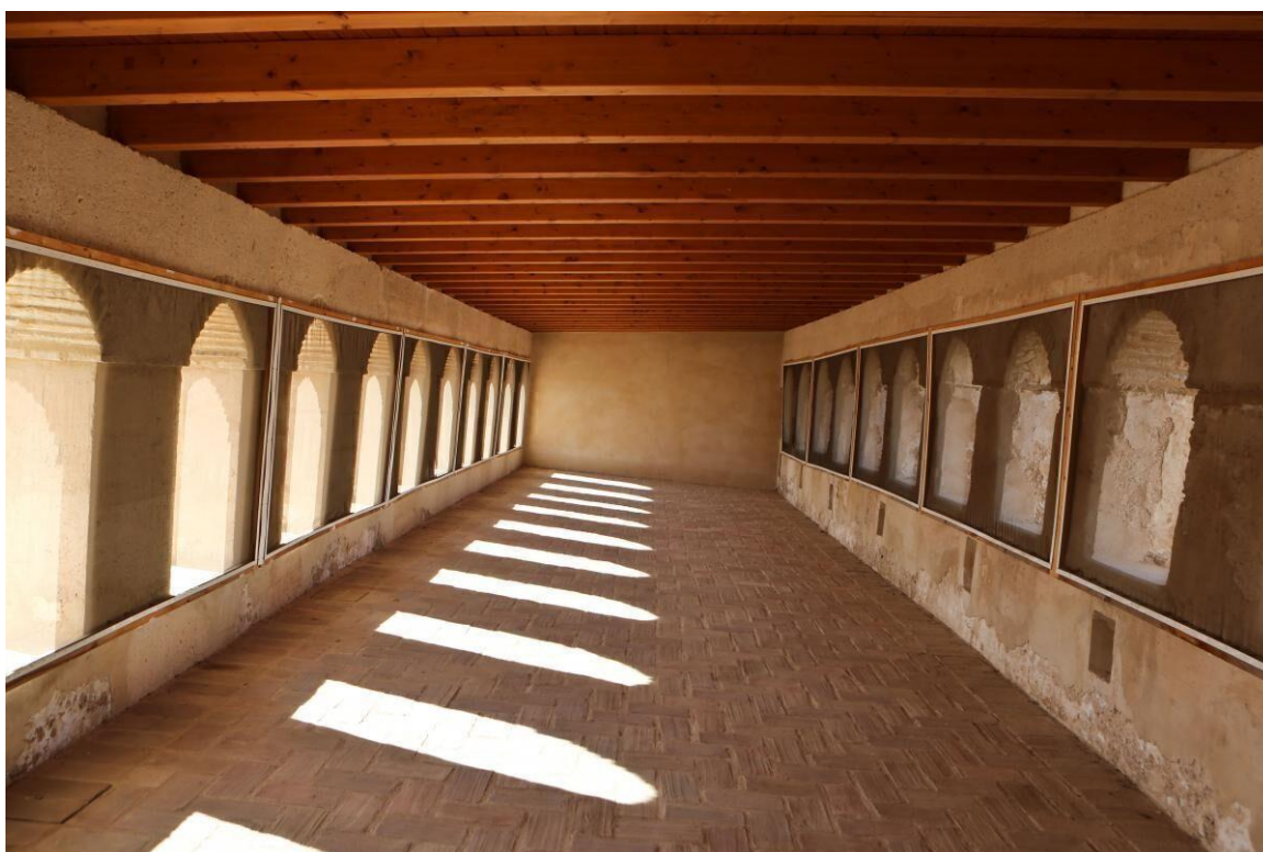
Ilustración 53: Fotografía de la galería de almenas cerradas en última planta
