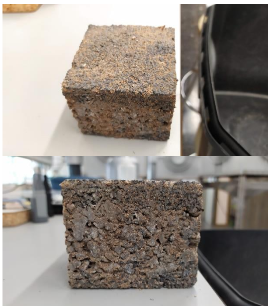
Figura II.6. Vistas de superficie (izquierda) y de sección (derecha) de una porción de pavimento poroso colmatado. Elaboración propia.
