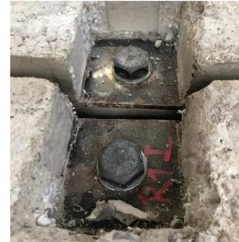
Figura 3.13: Conectores P3 usados en el proyecto FIREDUCE
