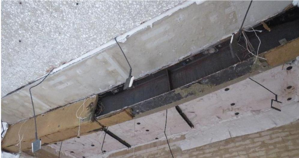
Figura 3.45: Desprendimiento del material de protección lana de roca en la viga con conector P15
