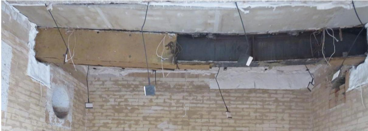
Figura 5.10: Viga mixta con conector P15 y desprendimiento del material lana de roca
