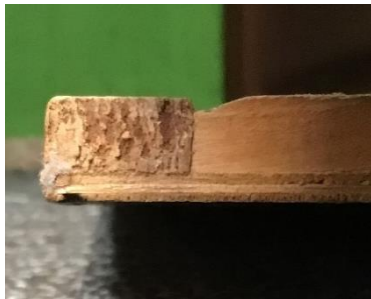
Figura 22. Foto detalle de una de las esquinas del cuadro, donde se observa el tipo de ensamble que se utilizó para el refuerzo de la anterior intervención.
