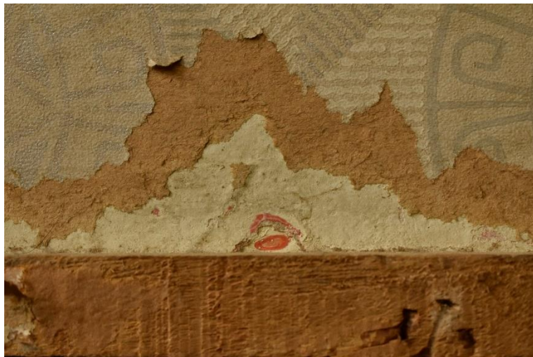
Figura 21. Foto detalle de una cata que se realizó para saber el número de capas que comprendía falso marouflage . Viéndose hasta el reverso del soporte. .
