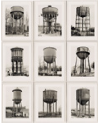
Fig. 5. Torres de agua (Wassertürme) , Bernd and Hilla Becher, 1980. Ejemplo de serie, si una sola imagen fuera extraída (como en su portada) puede representar su contenido.
