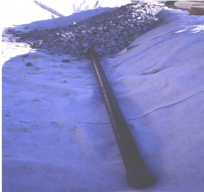
Figura 19. Colocación de la tubería de salida en un humedal de flujo subsuperficial horizontal.
