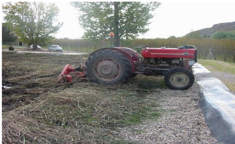
Figura 26. Operaciones de plantación de plántulas de carrizo en un sistema de flujo subsuperficial.
