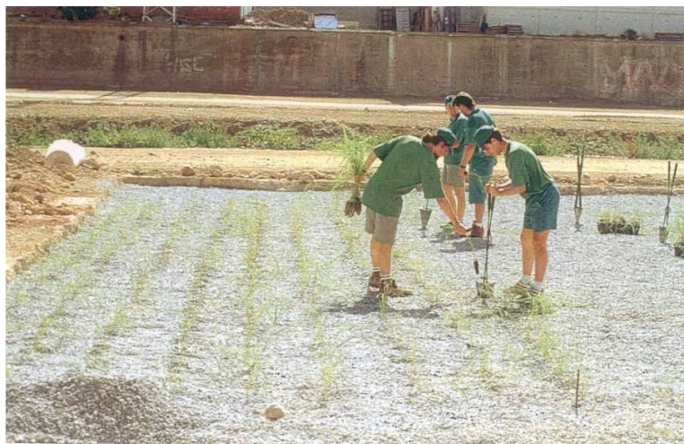
Figura 25. Operaciones de plantación de plántulas de carrizo en un sistema de flujo subsuperficial.
