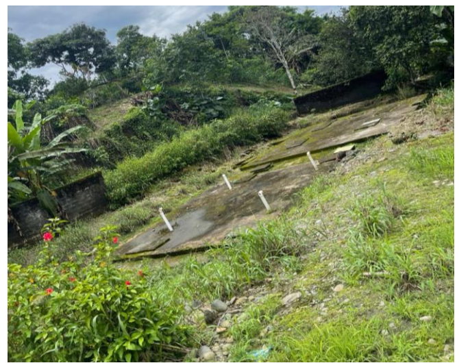
Figura 30. Piscinas de oxidación ineficientes en la cabecera parroquial de Luz de América.
