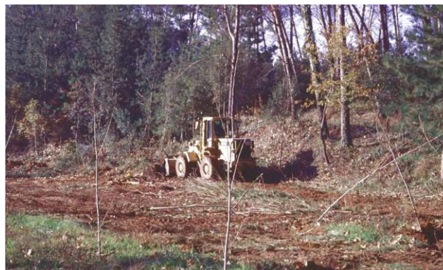
Figura 14. Operaciones de desbroce y limpieza durante la construcción de un sistema de humedales artificiales.
