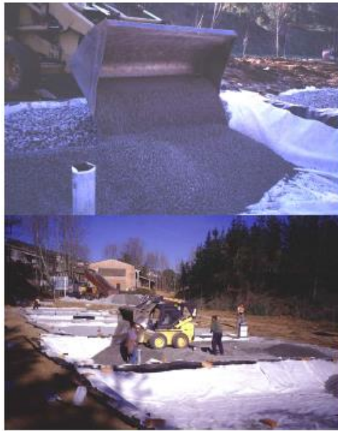
Figura 23. Imagen superior: colocación del material granular desde el exterior de la celda. Imagen inferior: colocación del material granular con maquinaria ligera desde el interior de la celda.
