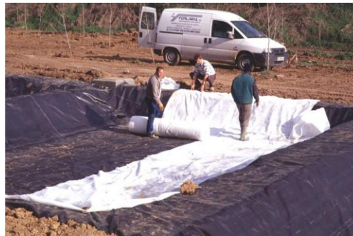
Figura 22. Operaciones de colocación del geotextil.
