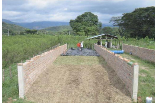
Figura 45. Silo bunker.
