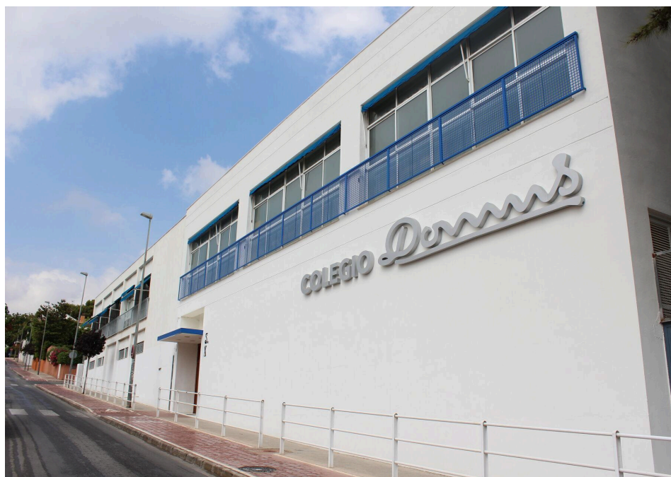
Figura 1. Fachada de la Fundación Institución Cultural Domus.
