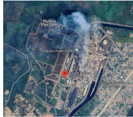
Figura 63: Centrales carboeléctricas Plutarco Elías Calles. Fuente: Elaboración propia.
