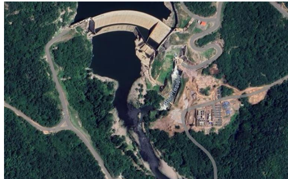
Figura 33: Ubicación de la Minicentral Hidroeléctrica Presa Picachos. Fuente: Elaboración propia
