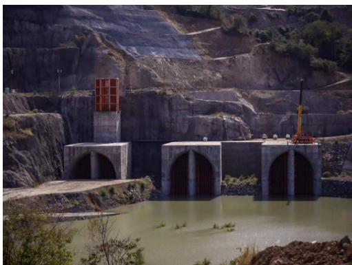
Figura 34: Infraestructura física de la Presa Santa María. Fuente: (Gobierno de México, 2023)
