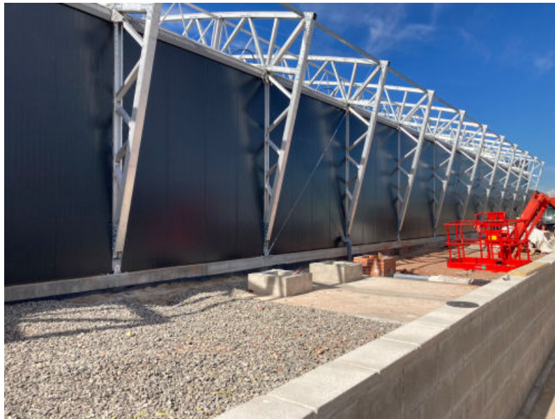
Figura 29: Estructura con Paneles Sándwich de Acero Galvanizado. Fuente: Generador de Precios
