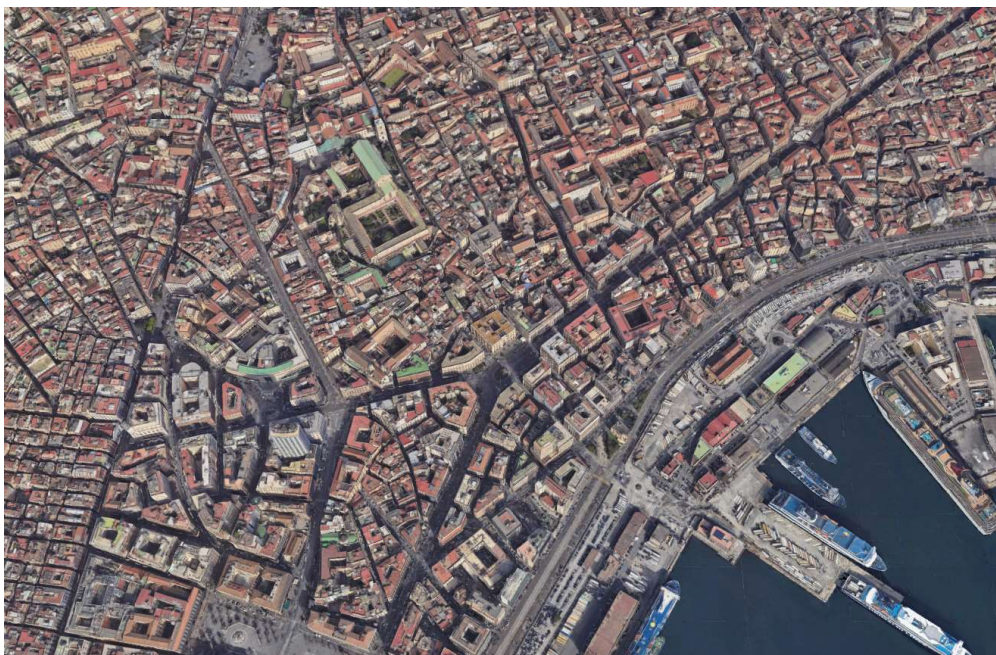
Fig. 2.27 Vista aérea de Nápoles. Fuente: Google Earth (2023).
