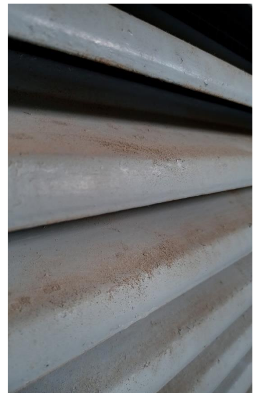
Fig. 16. Detalle de rejillas de un garaje en Avenida de Peris y Valero.
