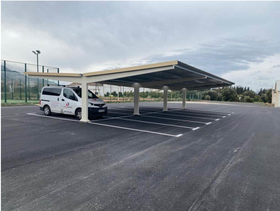
Ilustración 36: imagen real de marquesinas dobles
