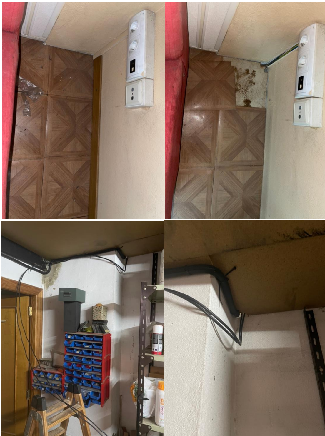
Il·lustració 79 - Instal·lació cable DAC
