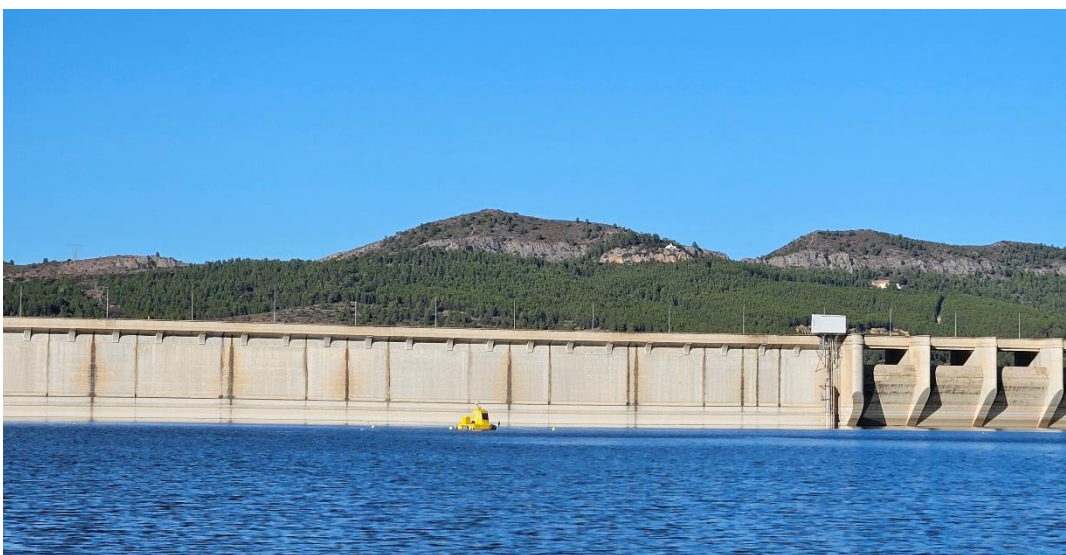
Figura 3. Dron-barco y presa. Fuente: propia
