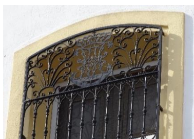
Fig. 7 Detall del finestral central de la façana.
