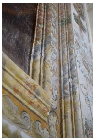
Fig. 35 Detall de zona on ha hagut pèrdua de pintura.
