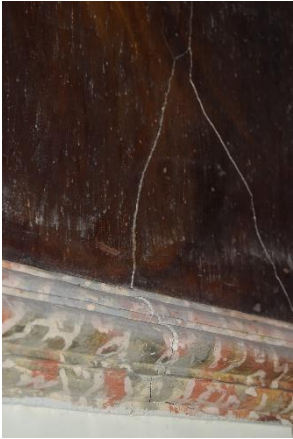
Fig. 33 Detall d'esquerda que arriba fins el final de l'obra.
