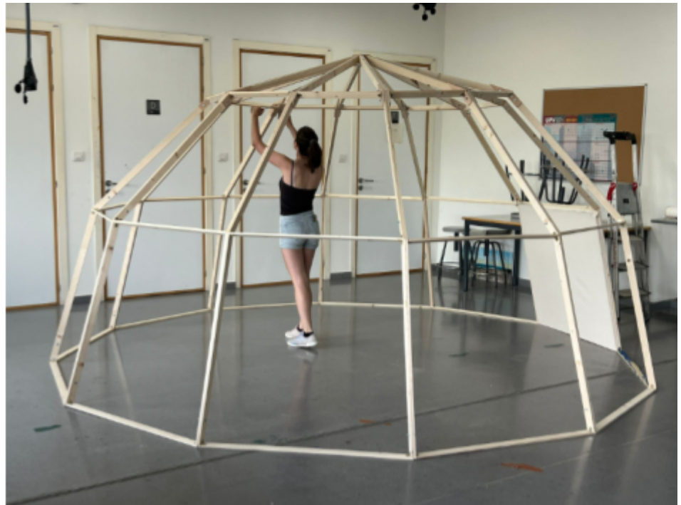
Imagen 53: Estructura de madera montada
