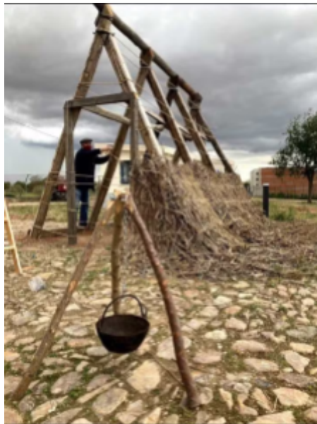
Imagen 18: Chozo de pastor en proceso de construcción.
