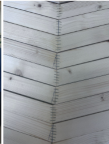
Imagen 44: Montaje de módulos.
