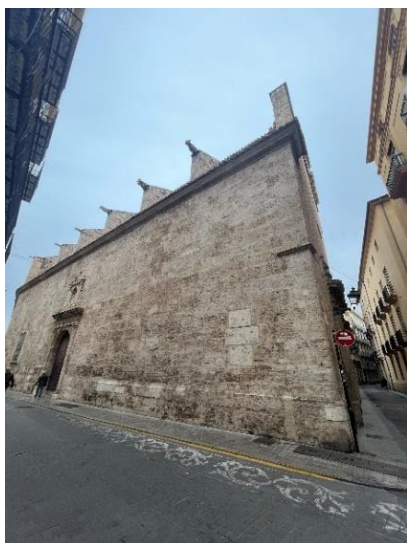
Figura 13: Fotografía general del exterior de la parroquia.
