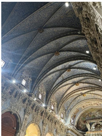
Figura 11: Fotografía de las bóvedas de crucería actual.
